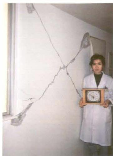
北棟一南棟の渡り廊下の破損はひどく、廊下壁および実習室内壁に大きな亀裂が入った。（4階生理学実験室前の廊下壁）
