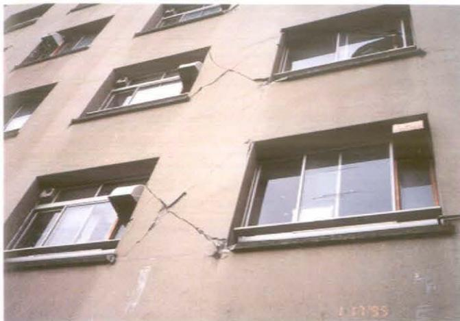
第一病棟北側面外壁の亀裂
