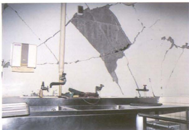
第一病棟 1階調理場内壁の亀裂、剥落
