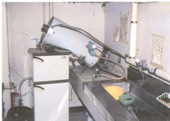
第一病棟キチネットの給湯器の倒壊（各階同様）
