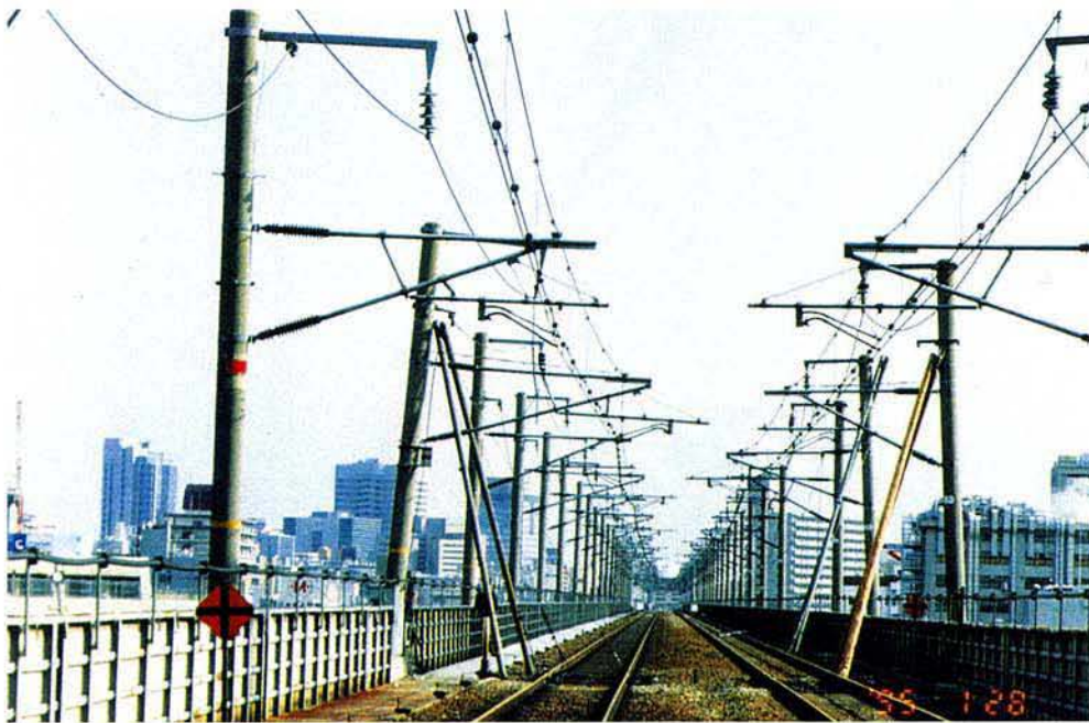
新幹線 新大阪～新神戸間 電柱傾斜補強
