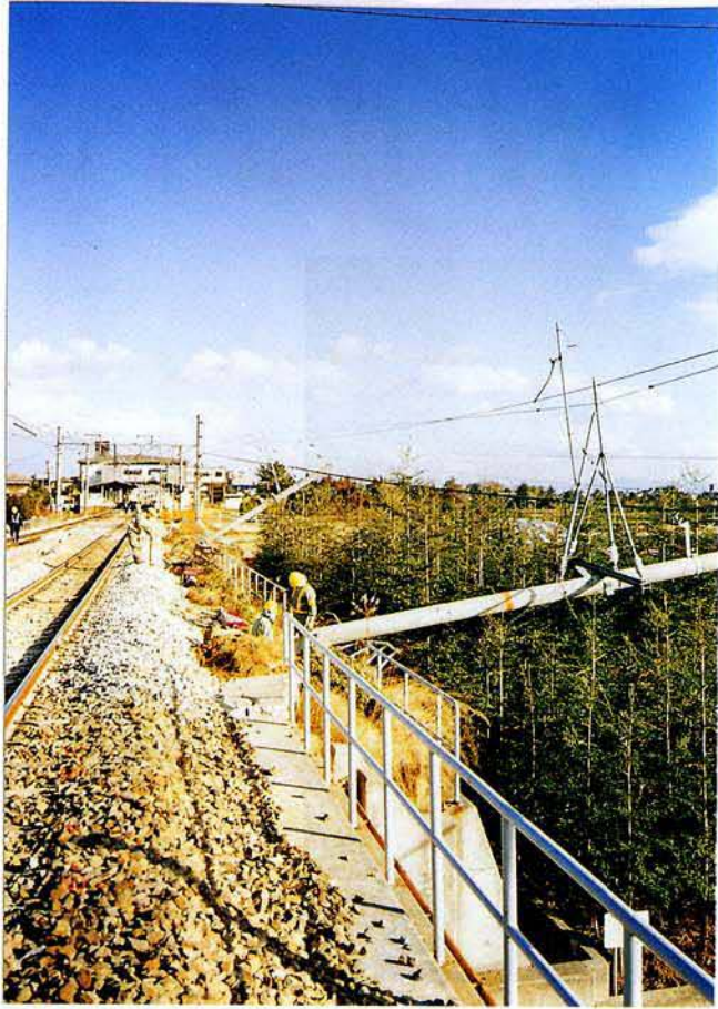
福知山線 中山寺駅構内 下り10～13号柱付近 電柱倒壊
