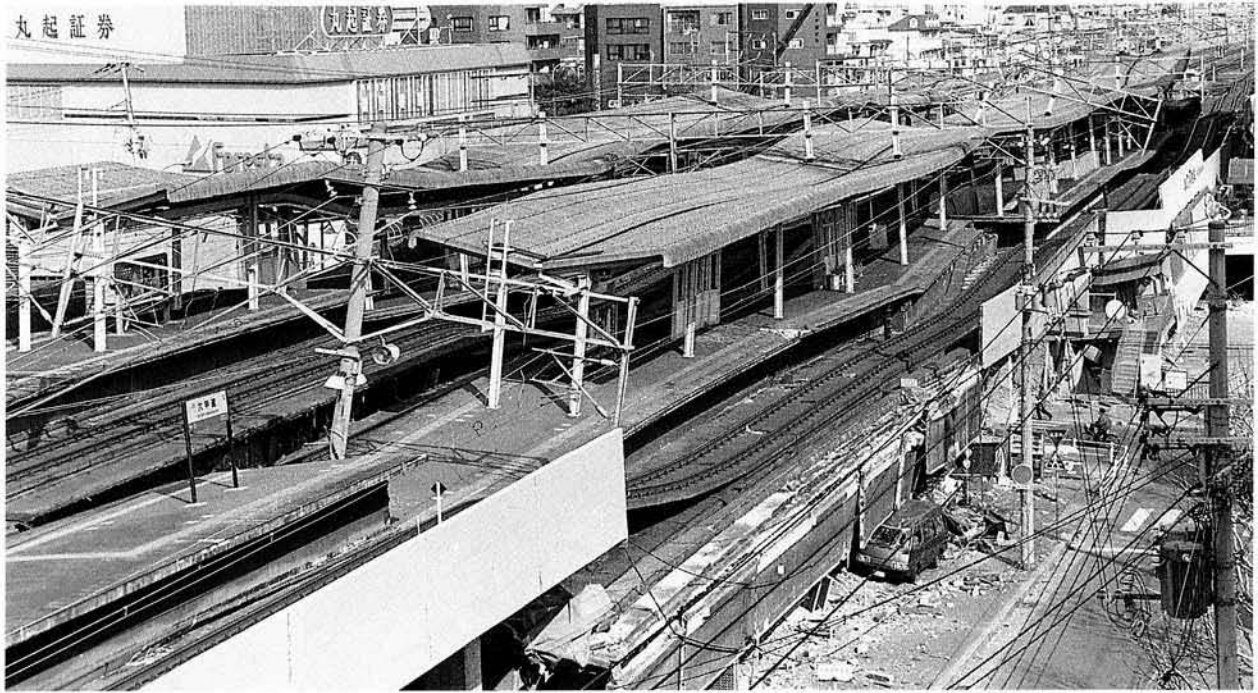
六甲道駅ホーム被害惨状
