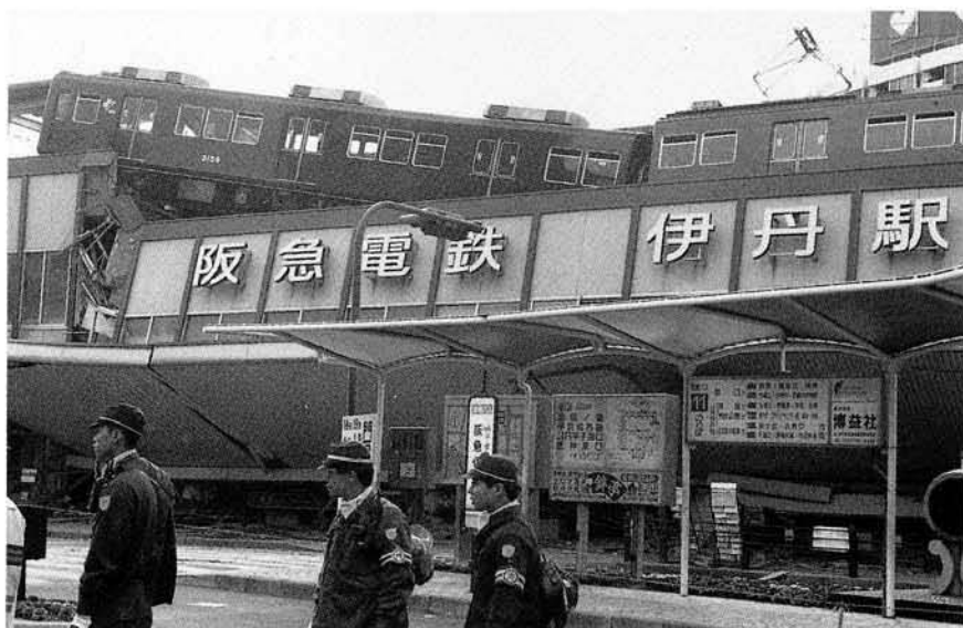
電車ごと高架が落下して 押しつぶされた阪急伊丹駅の惨状
