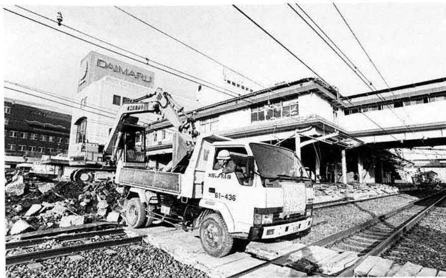
芦屋駅仮設ホーム復旧作業
