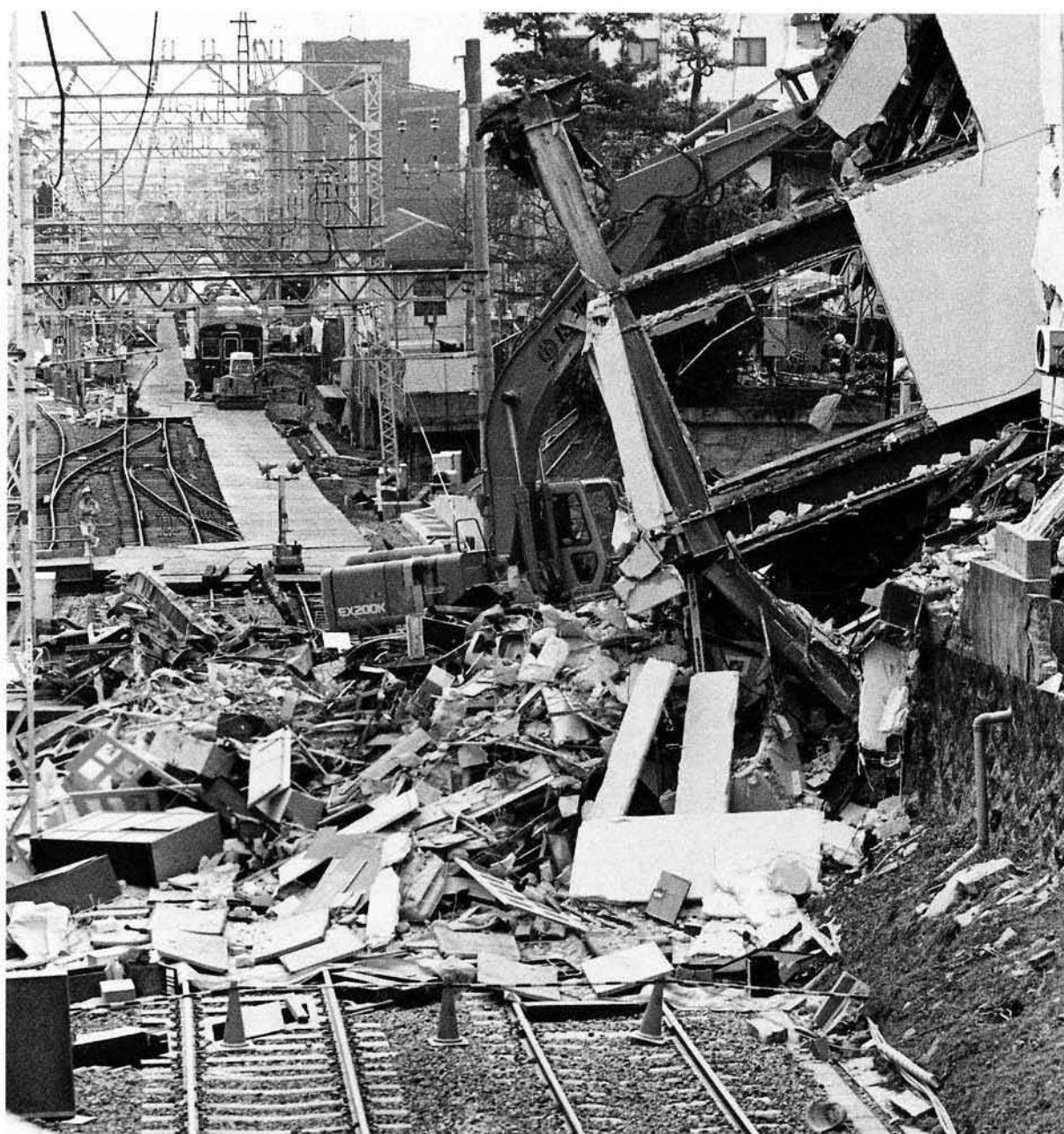
阪急電鉄・夙川駅付近の倒壊したビルが線路まで崩壊した
