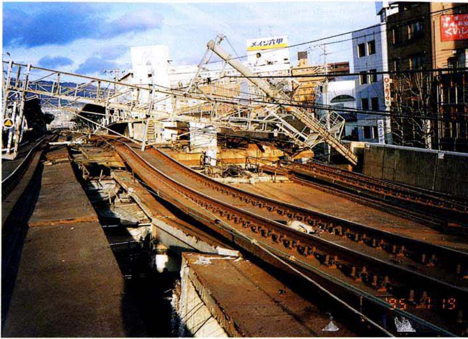
東海道本線 六甲道駅構内 構6号柱付近 鉄柱倒壊
