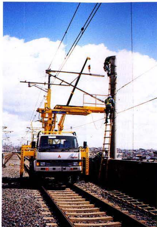
新幹線 新大阪～新神戸間 可動ブラット取付作業
