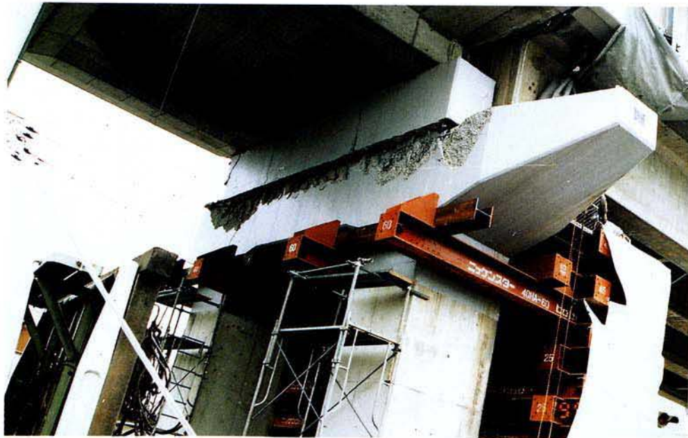
新幹線 高架橋復旧工事 (仮受け架台)
