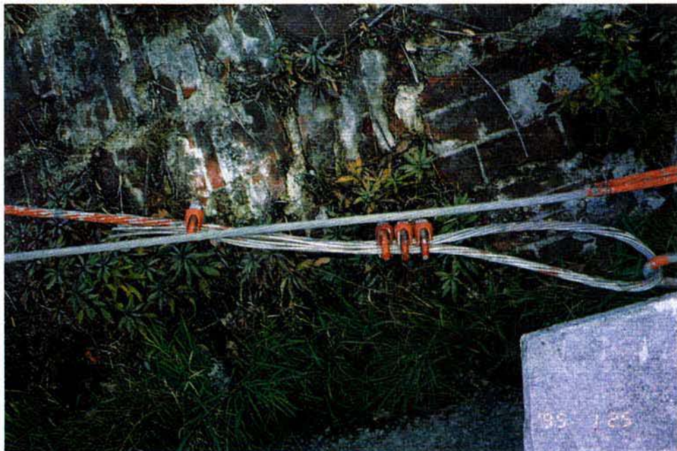
東海道本線 芦屋～摂津本山間 支線 (St135mm 2 ) 損傷 電柱及び支線基礎部が大きく振動し、両設備間が引っ張られて支線のワイヤクリップが弛んだ
