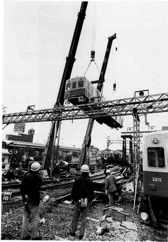
阪神電鉄・石屋川電車基地における被害電車の收容作業（5 8両）
