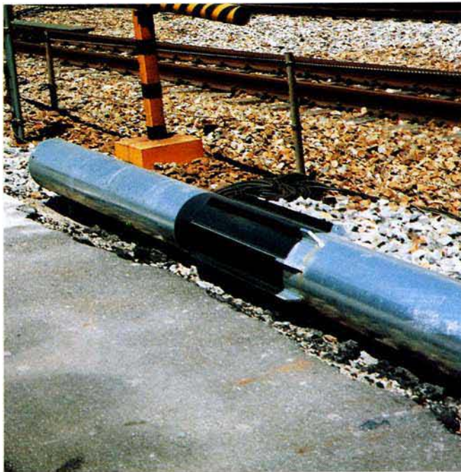
芦屋駅構内 投込み式鋼管柱と建植鋼管柱
