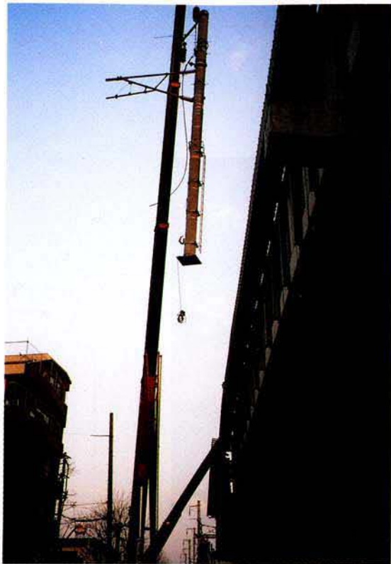
鋼管柱建替作業
