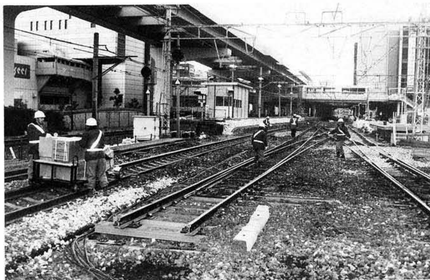
住吉駅構内X字型分岐器仮設工事
