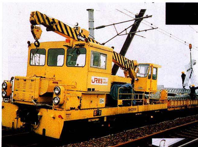
高架上に復旧資材吊り上げ作業
