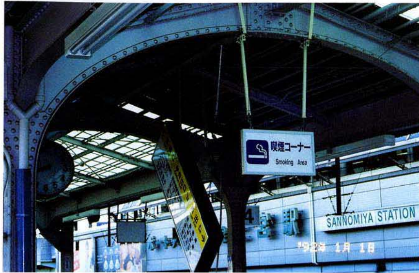
三ノ宮駅ホーム電気掲示器落下
