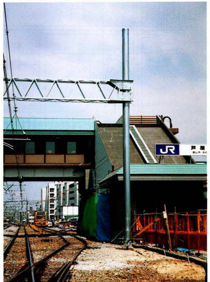
芦屋駅構内 投込み式鋼管柱と建植鋼管柱
