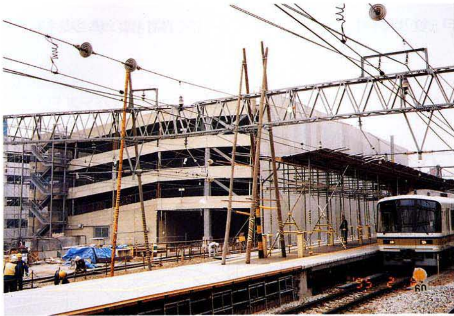
芦屋駅構内 構9号柱 ビーム仮受け
