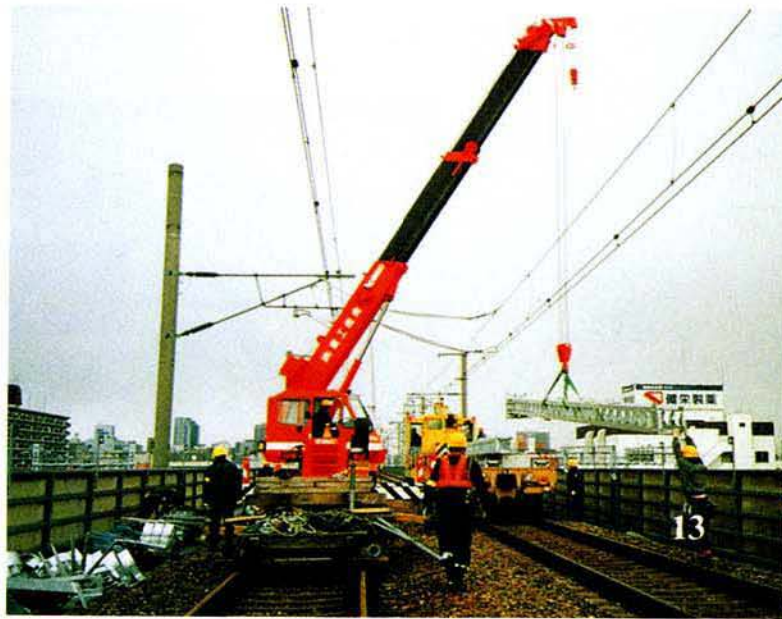
新幹線 新大阪～新神戸間 電柱建替作業
