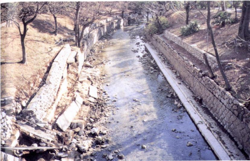
国道2号下流では両岸の石積みが前面に傾き、崩壊に到った箇所もある
