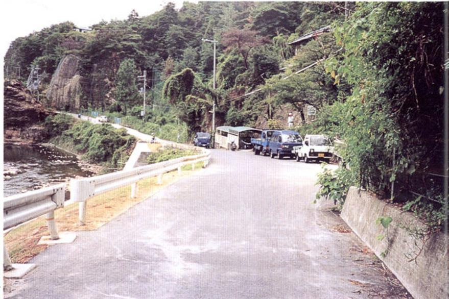
落石防止ネットを施し、舗装面を打ち換えた
