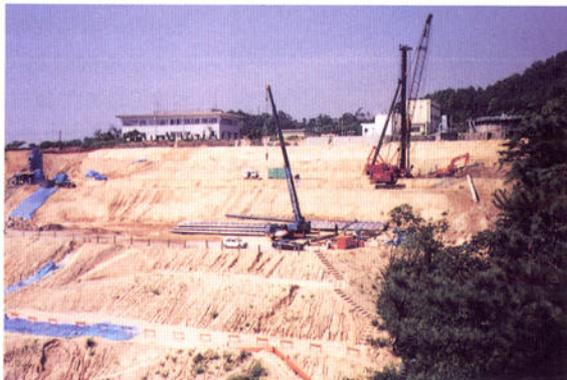
台風時期までに完了を急ぐ抑止杭工事
