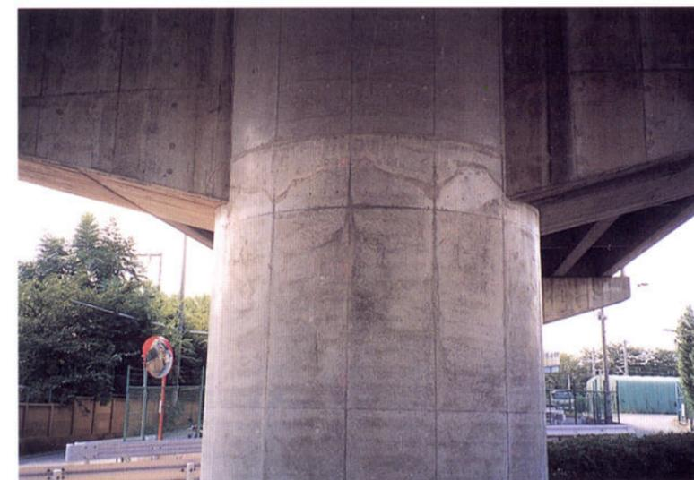
補修工にはRC巻き立て工法を採用
