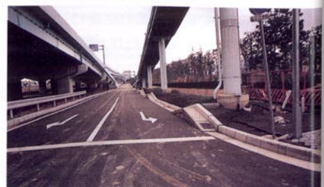
構造物付近を残し、全体沈下
