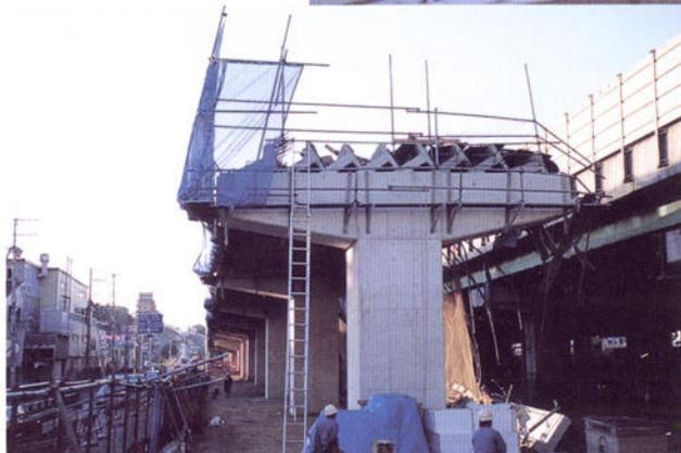
桁の移動・転倒・落下などが生じた
