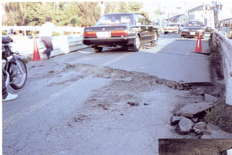
上部工コンクリート床版などにクラックが生じ、通行止めに
