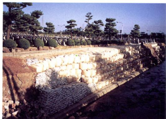
応急仮工事。土のう積みの面積が広いため、コンテナバッグを用い、施工の迅速化を図った
