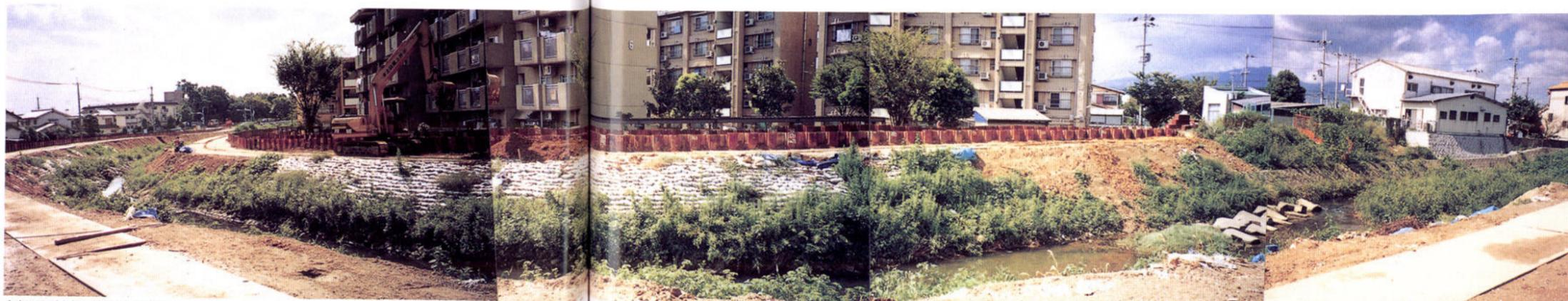
止水および土留矢板を右岸に施工
