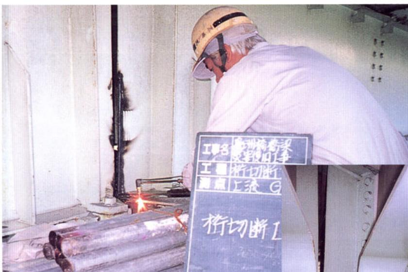
遊間を確保するため桁端を切断中
