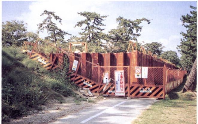
雨期の二次災害防止のため鋼矢板による仮締め切り
