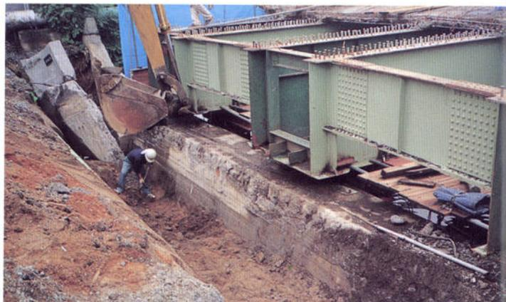
バラベットのコンクリート床版撤去後の橋梁端部
