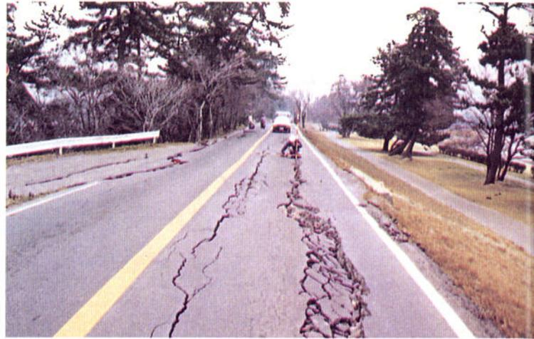
堤体の不等沈下により路面にクラックが発生
