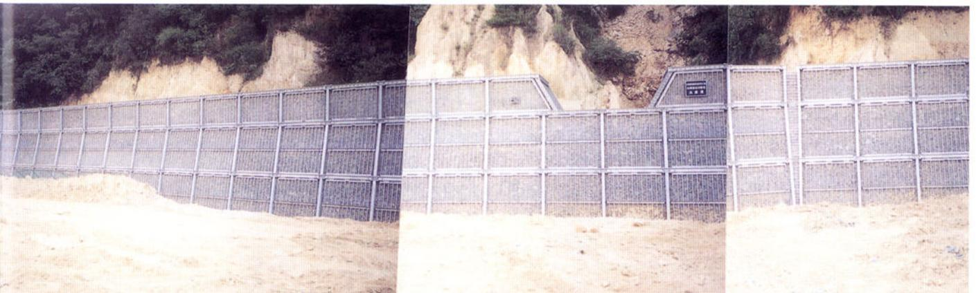
鋼製枠組み堰堤(L=120m)の完成状況(白瀬南谷川)
