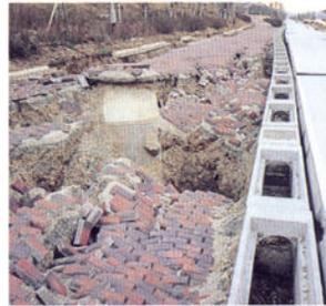
南芦屋浜地区北護岸、北緑地で護岸・緑地が沈下・滑り
