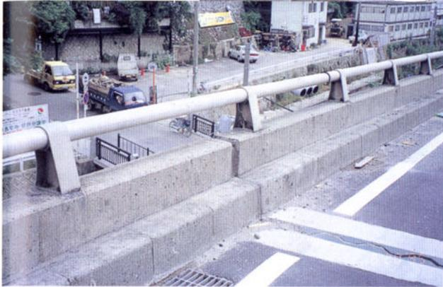
支承が全て破損し、橋上に隙間を生じた
