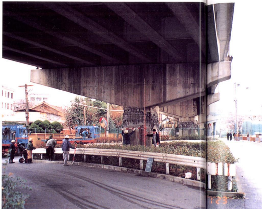
全橋脚柱にせん断クラックが発生し、程度の差はあるが主鉄筋が露出
