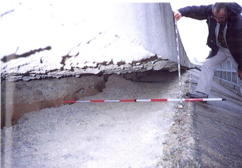
杭で支持された床版を残して堤体が沈下
