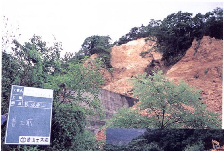
堰堤の上流左岸山腹で崩壊が生じた
