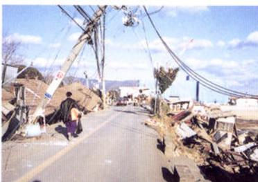
路肩石積みが破損し、舗装面にもクラックが入った
