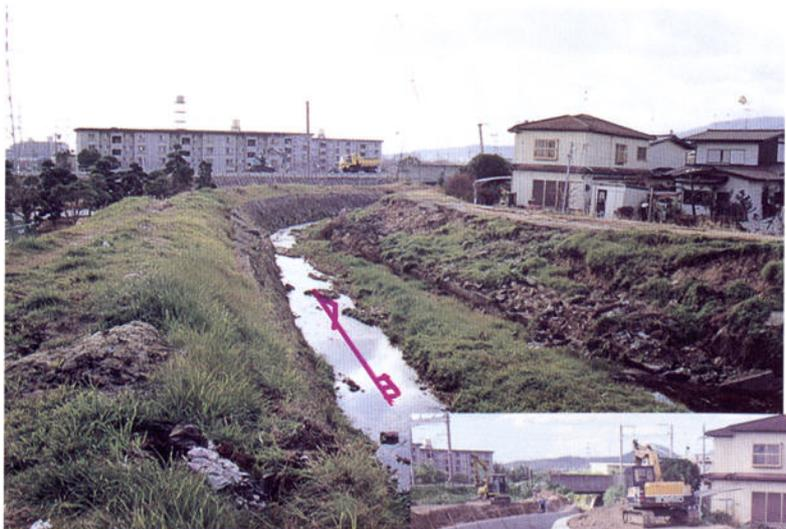
護岸が崩壊し、堤防天端にクラックが入った
