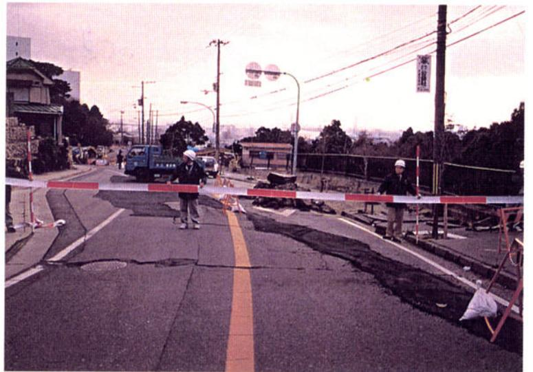
地割れ部分への碎石等の充填と段差すりつけによる応急処置で片側交互通行を確保
