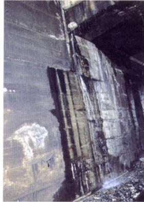
山側の橋台が線路側に押し出され、上面河床より漏水が発生
