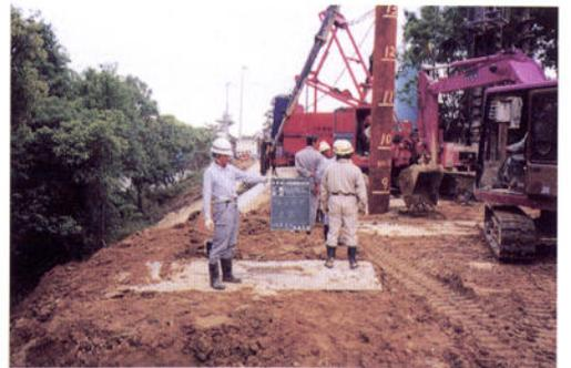
梅雨時期までに完了を急ぐ隣接斜面の抑止杭工事
