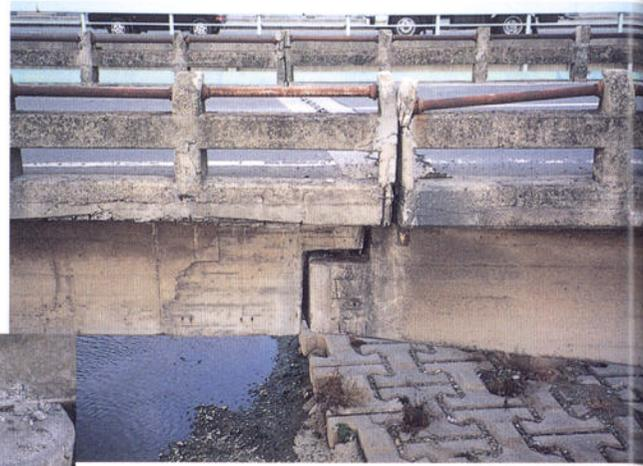
コンクリート製高欄が破損
