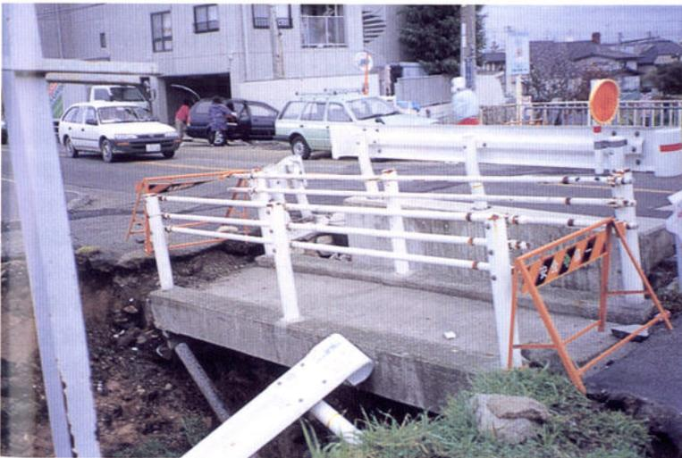
護岸が倒壊し、側道橋が落下
