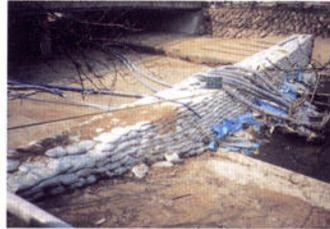
仮締め切りを築堤し、6インチポンプを6台設置して橋の下流側で排水
