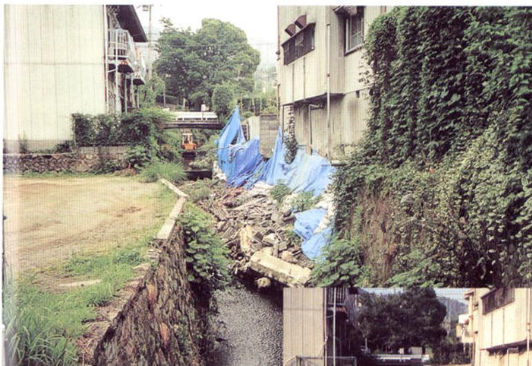
民家のブロック塀が崩壊し河川断面を閉塞
