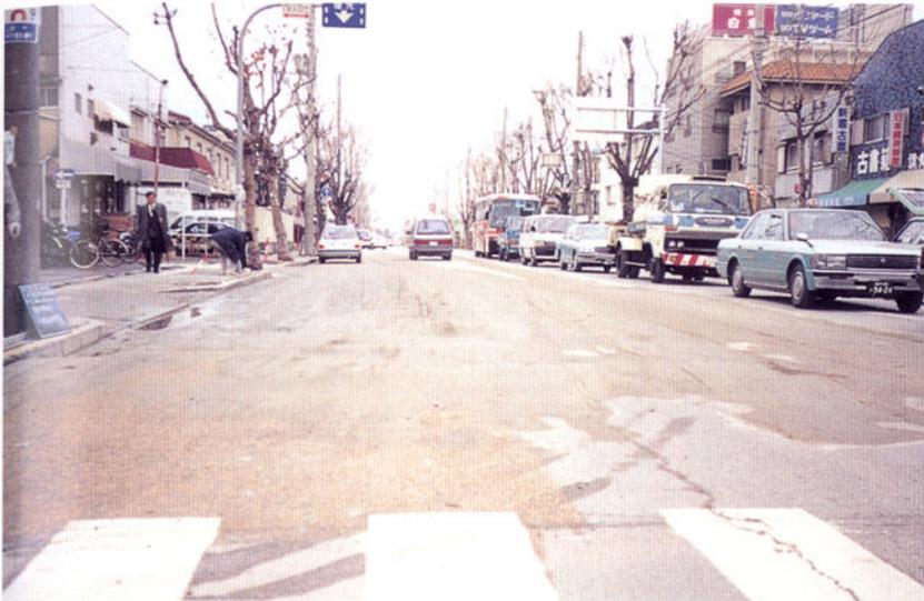
液状化により噴き出した砂が路面に堆積
