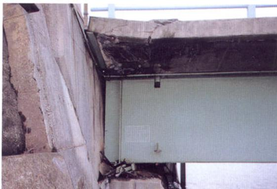
鋼桁の水平動により、バラベットのコンクリート床版等が破損
