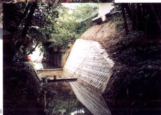
ブロック積み工法により護岸を復旧
