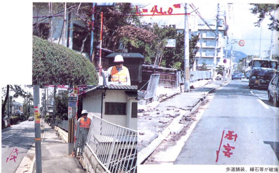
歩道が沈下し、擁壁が傾く
