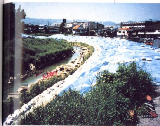
左岸を土のう積みによる護岸法で保護し、ブルーシートで堤体を保護
