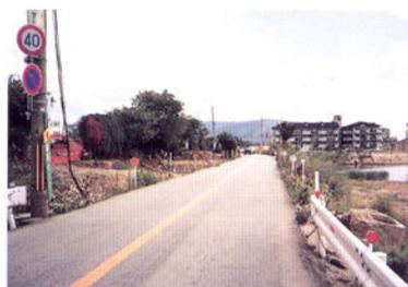
倒壊家屋などを撤去し、舗装面のオーバーレイを施工して供用開始
