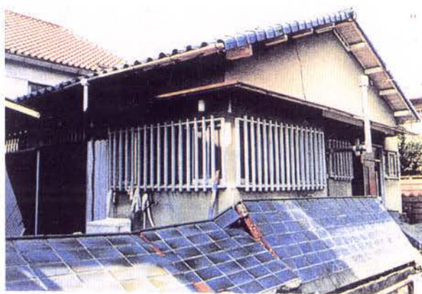
倒壊：全体が形を保って倒れている状態を「倒壊」とした。
