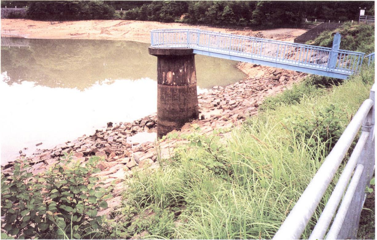
奥池のリップラップ崩壊、取水塔傾斜・管理橋破損
