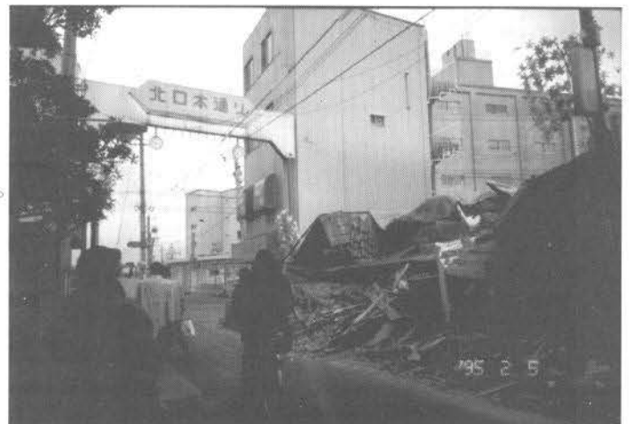
阪神・淡路大震災の後、全壊した建物がしばらくそのまま放置され続けていました。3 カ月あたりからようやく、仮設店舗が建ちはじめ、町の活気が出てきました。
