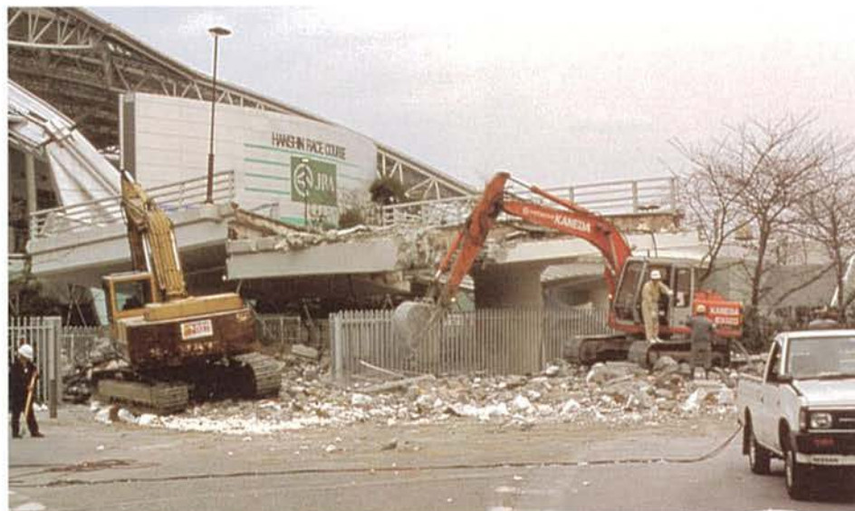
宝塚（阪神）競馬場。駐車場1階部分が押しつぶされるなどの被害を受けた
