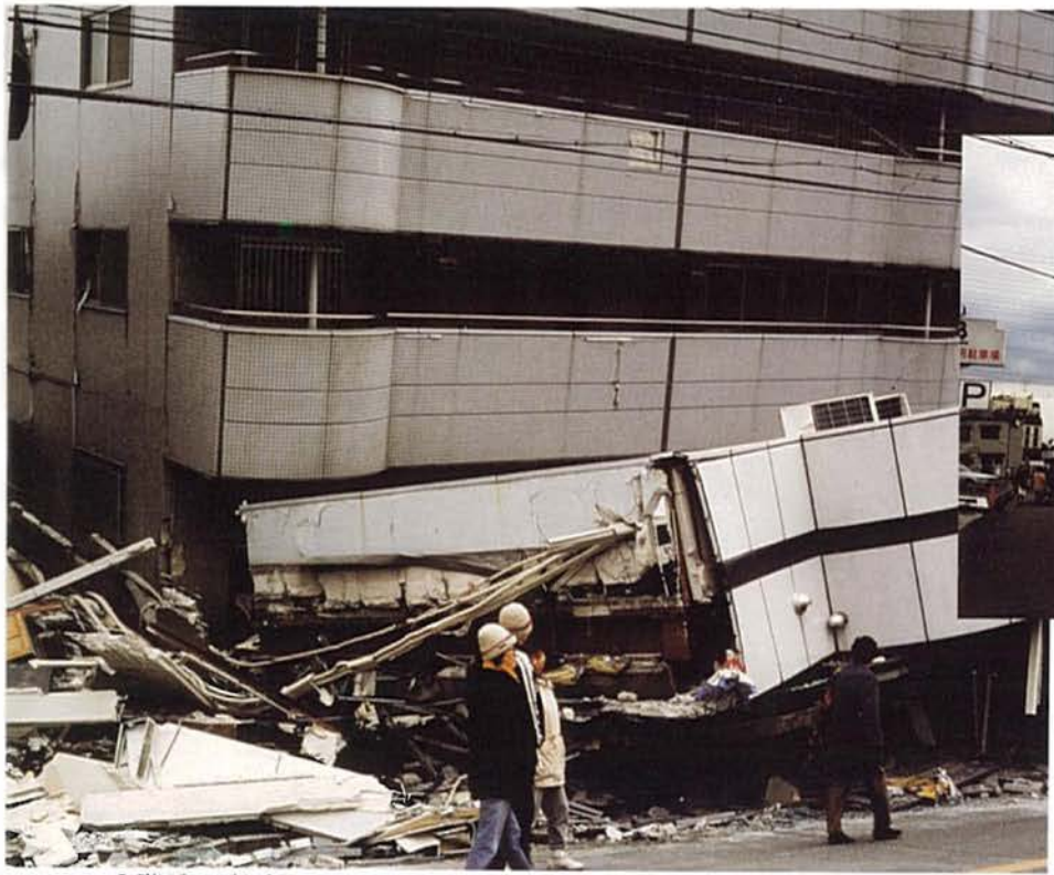
1階がつぶれ傾いたマンション（中山寺1丁目）
