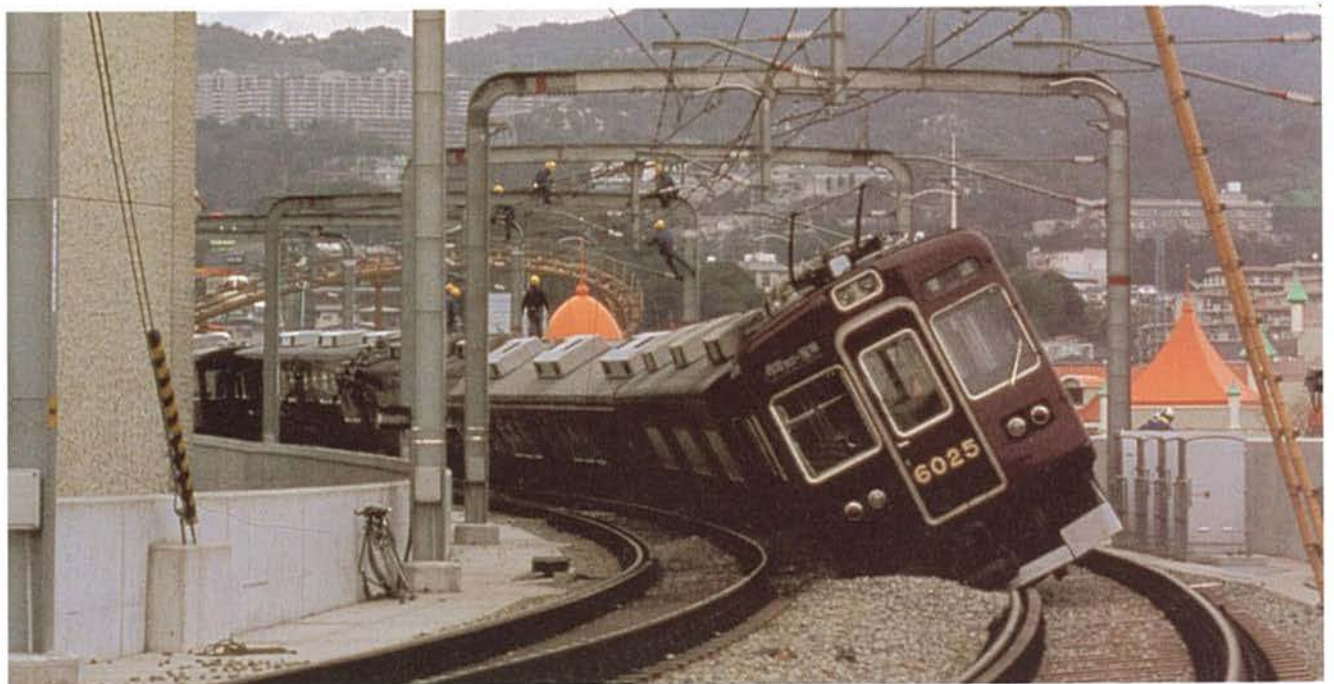
脱線し傾いた阪急電車（栄町1丁目）
