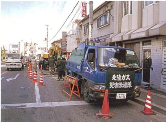
ガスの復旧工事（伊子志4丁目）
