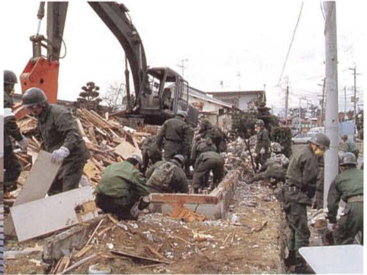
自衛隊による家屋解体（売布2丁目）
