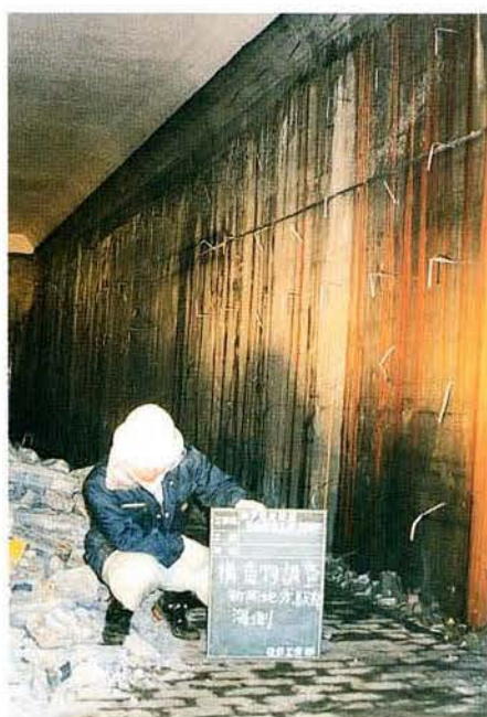
写真 3.1-42 新開地側の側壁（海側）
