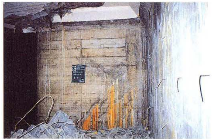
写真 3.1-35 高速長田側妻壁（山側）
