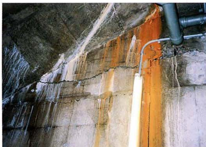
写真 3.1-50 開閉所ホーム側側壁
