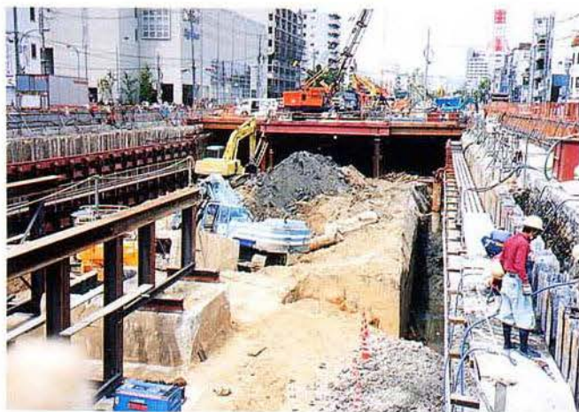
写真 3.1-72 高速長田側端部付近の上床版の状況
