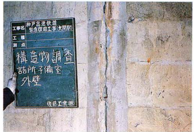
写真 3.1-53 予備室側壁の施工継目部の 拡幅状況
