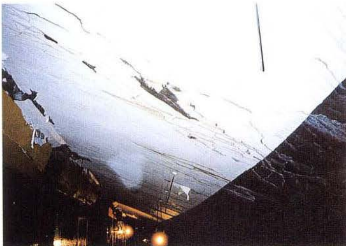
写真 3.1-32 高速長田側の端部から中央部 を見た上床版（山側）
