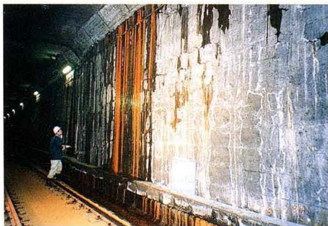
写真 3.1-66 一般路線部・新開地側 側壁（海側）
