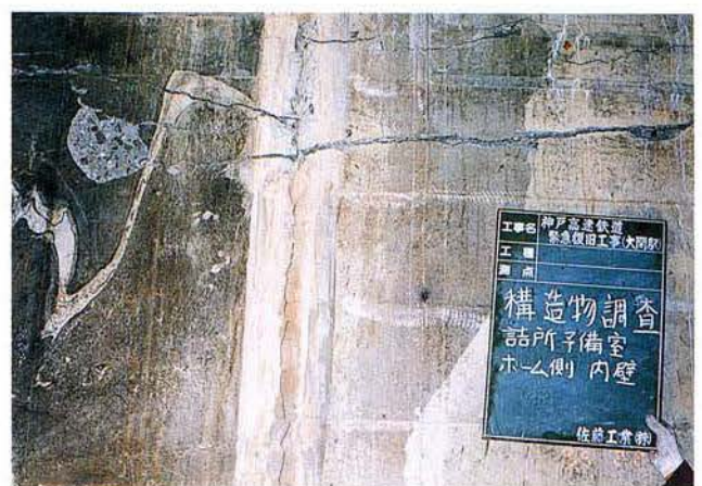
写真 3.1-55 予備室ホーム側側壁
