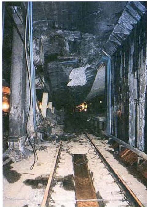
写真 3.1-57 高速長田側より駅部を望む (海側)
