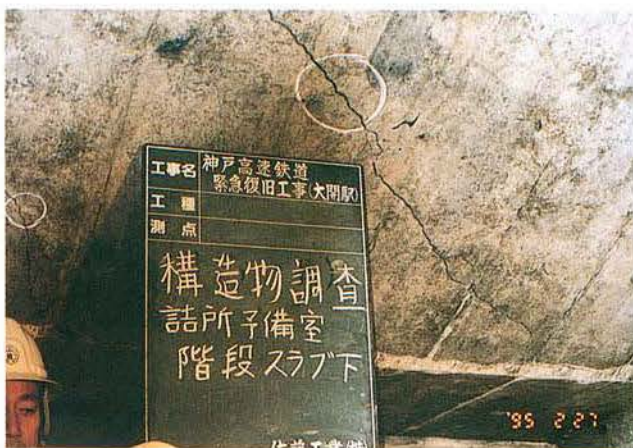
写真 3.1-54 予備室階段床版
