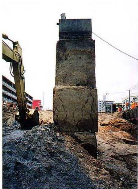
写真 3.1-75 換気塔（新開地側から望む）
