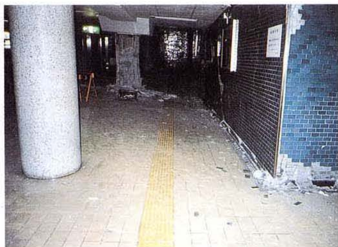
写真 3.1-14 コンコースの床版 (山側→海側)
