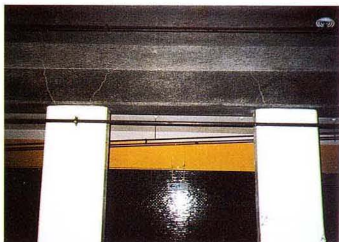
写真 3.1-29 中柱32－33間の上床梁
