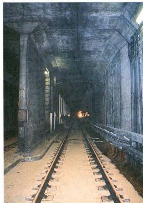
写真 3.1-59 新開地側より駅部を望む (山側)
