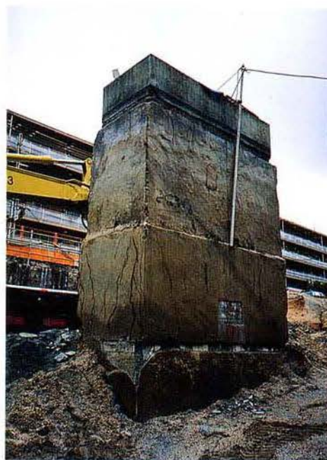
写真 3.1-76 換気塔 （山側から望む）
