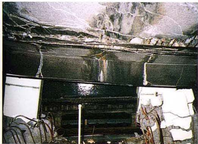
写真 3.1-26 中柱 3－4間の上床梁
