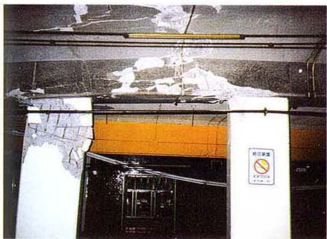
写真 3.1-28 中柱25－26間の上床梁
