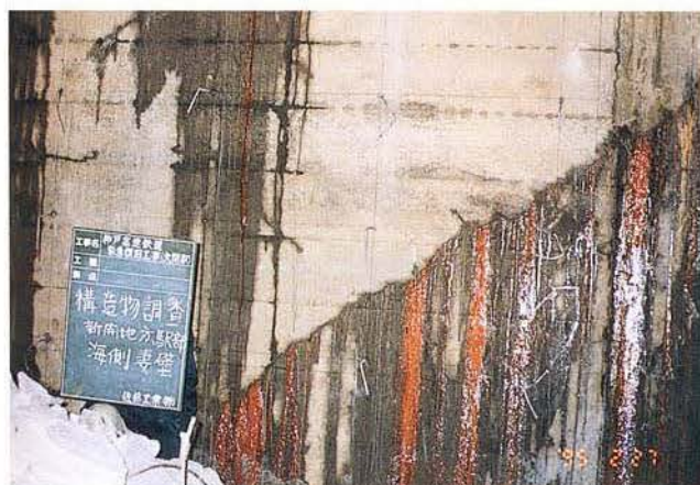
写真 3.1-38 新開地側妻壁（海側）
