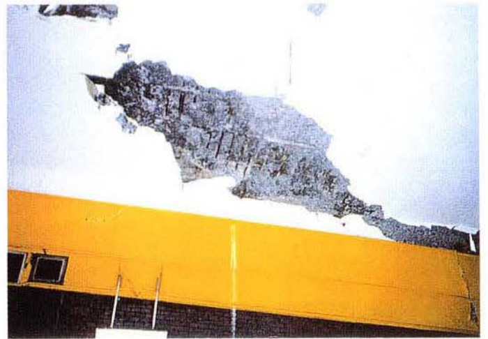
写真 3.1-31 中柱24の側壁側の上床版（海側）
