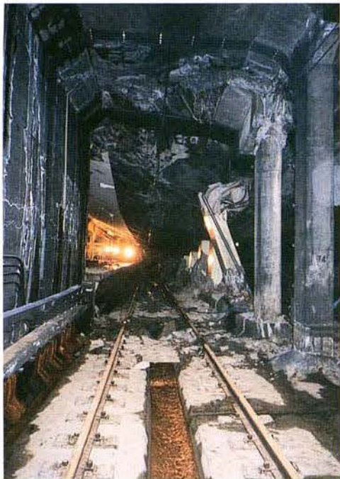
写真 3.1-56 高速長田側より駅部を望む (山側)
