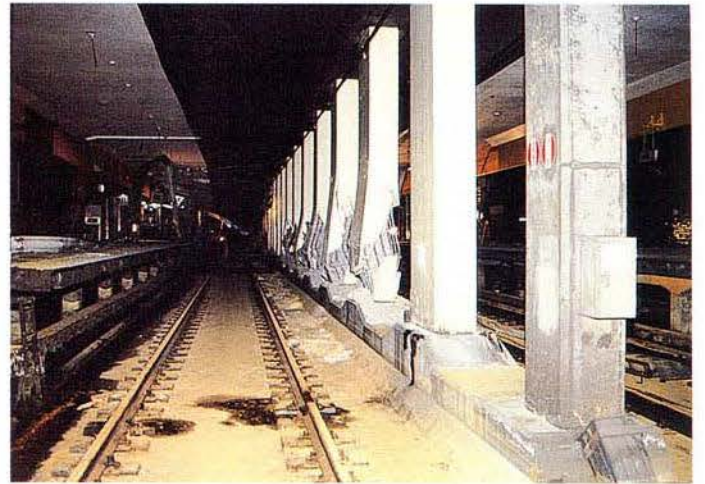
写真 3.1-18 新開地側（海側）
