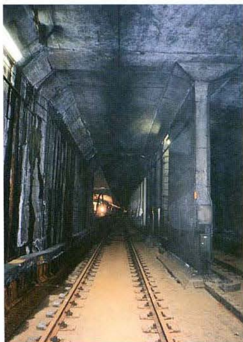
写真 3.1-58 新開地側より駅部を望む (海側)
