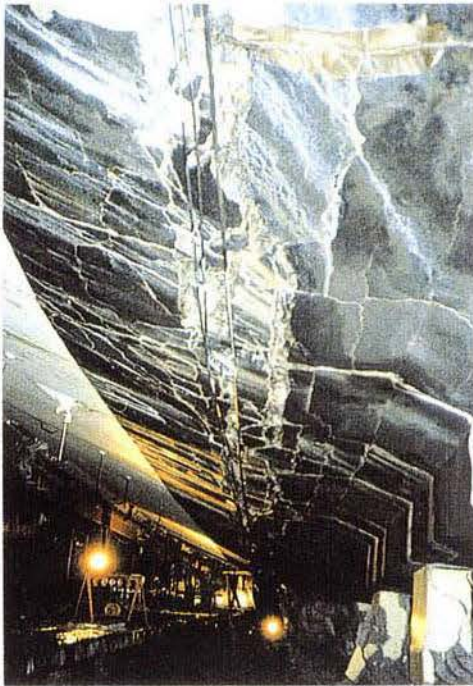
写真 3.1-30 中柱18付近から高速長田 方面を見た上床版（海側）
