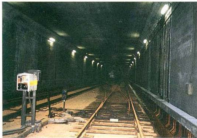
写真 3.1-61 駅部より一般路線部 新開地側を望む
