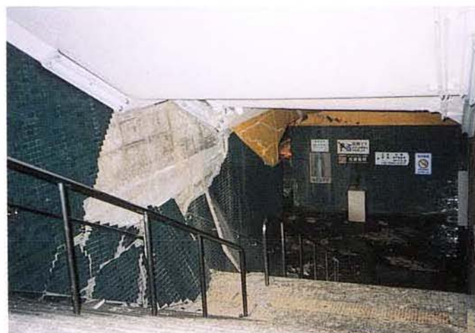
写真 3.1-15 プラットホームへの階段
