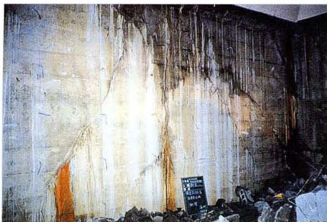
写真 3.1-40 高速長田側妻壁付近の側壁（海側）
