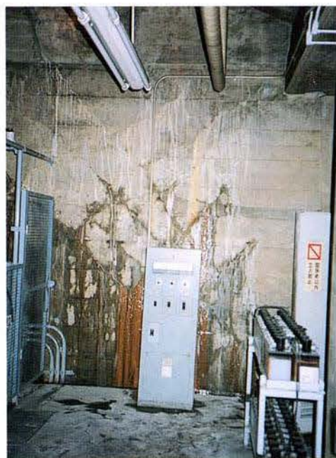
写真 3.1-51 電気室 新開地側妻壁
