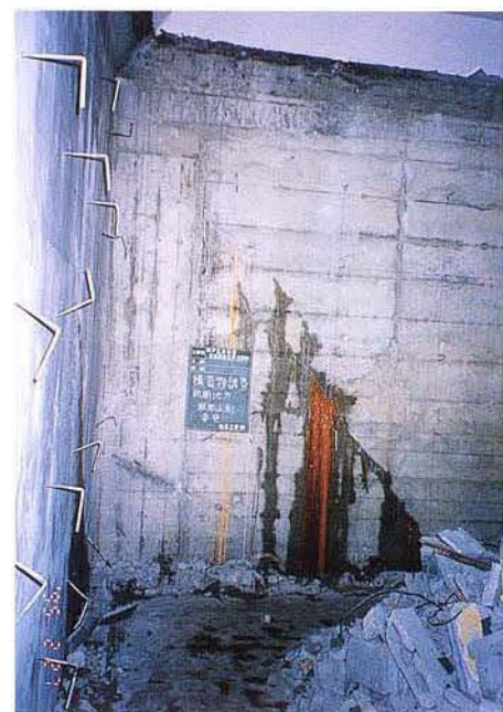
写真 3.1-39 新開地側妻壁（山側）
