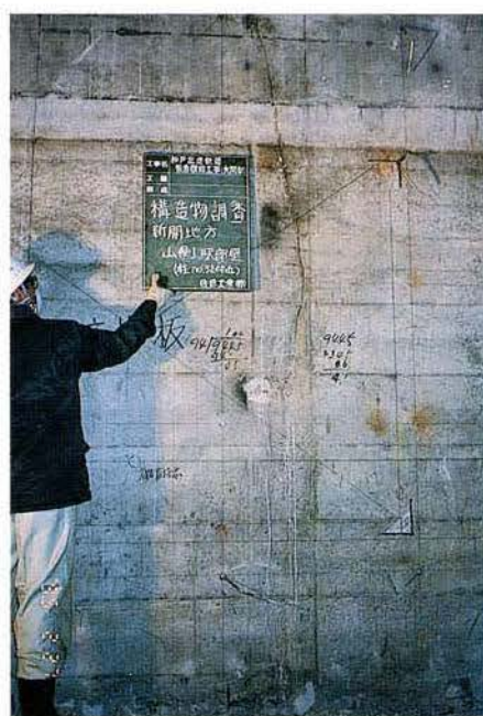
写真 3.1-43 新開地側の側壁（山側）
