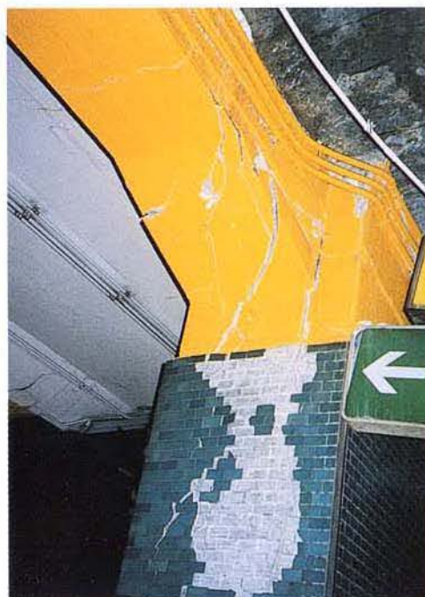
写真 3.1-16 プラットホーム入口の梁
