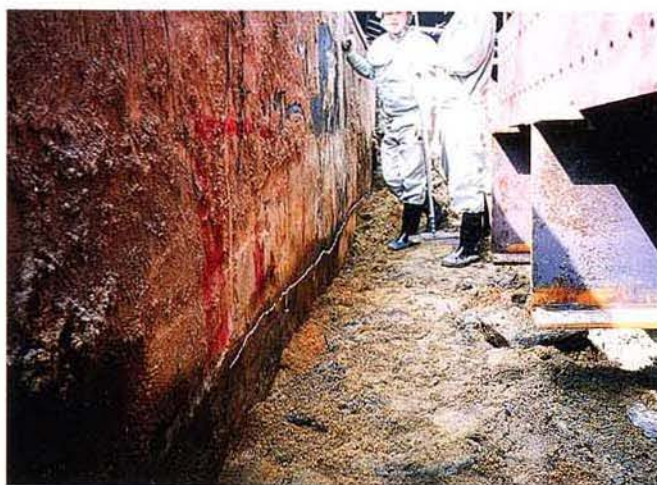
写真 3.1-77 新開地側端付近の側壁外面 に生じたひびわれ（山側）
