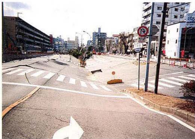
写真 3.1-2 国道28号線路面の陥没状況 (高速長田側を望む)
