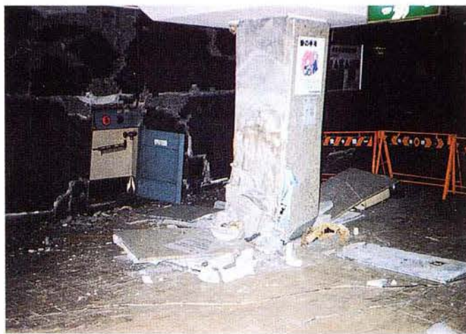
写真 3.1-12 改札口を入ったところの柱
