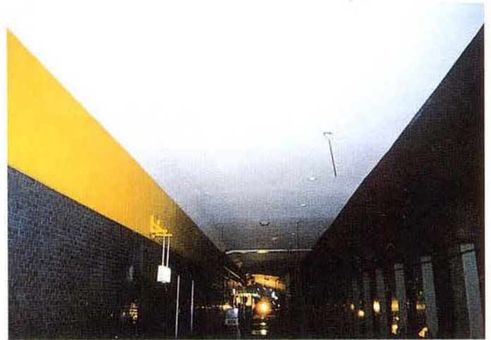
写真 3.1-33 新開地側の端部から中央部 を見た上床版（海側）
