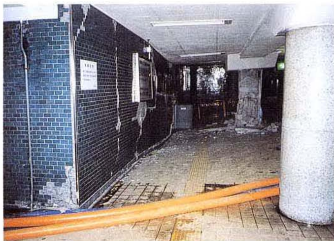
写真 3.1-13 コンコースの床版 (海側→山側)
