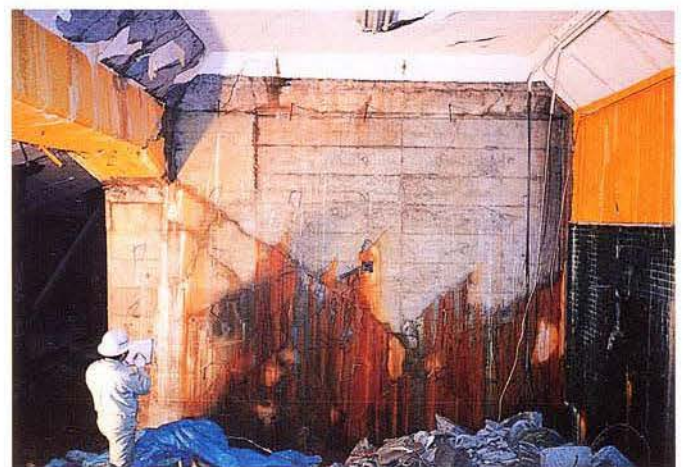
写真 3.1-37 階段付近妻壁（山側）
