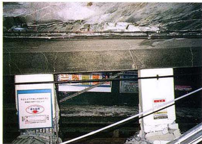
写真 3.1-27 中柱21－22間の上床梁
