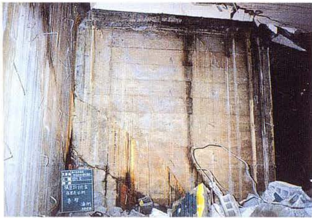
写真 3.1-34 高速長田側妻壁（海側）
