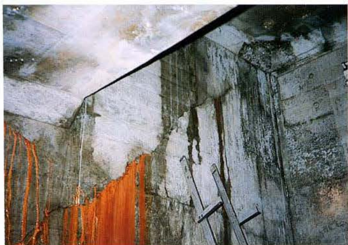
写真 3.1-48 開閉所新開地側の妻壁
