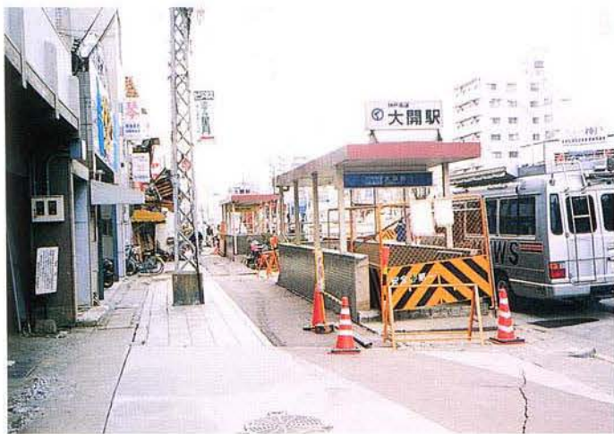
写真 3.1-9 地上への出入口
