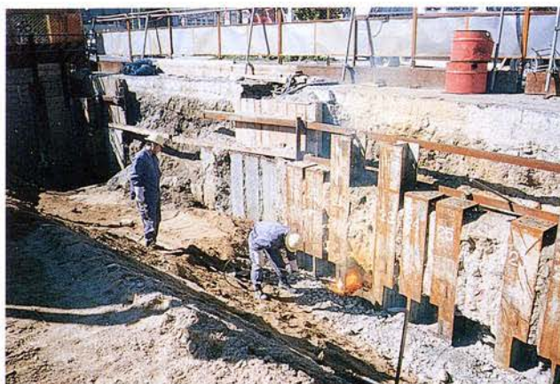
SMW芯材撤去状況
