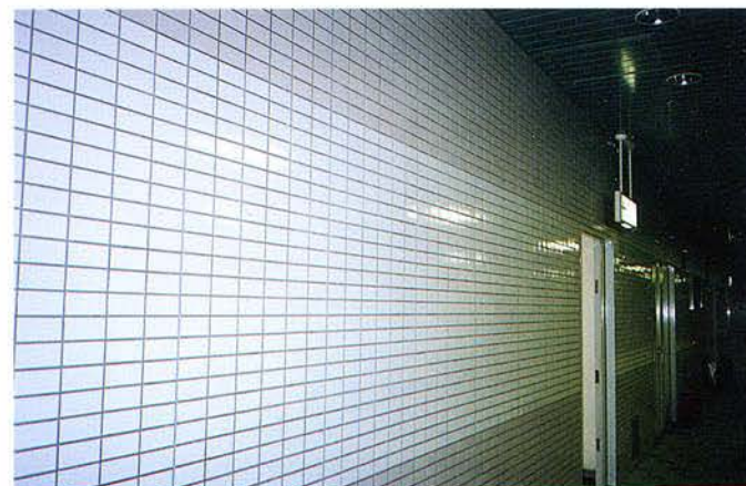
壁タイル張り完了(プラットフォーム)
