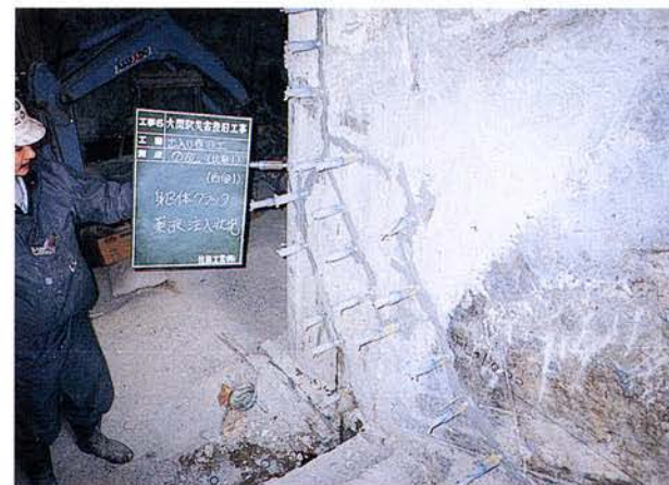
クラック補修状況(出入口部)
