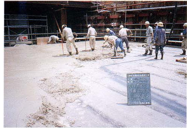
シート防水工（保護コンクリート打設状況）
