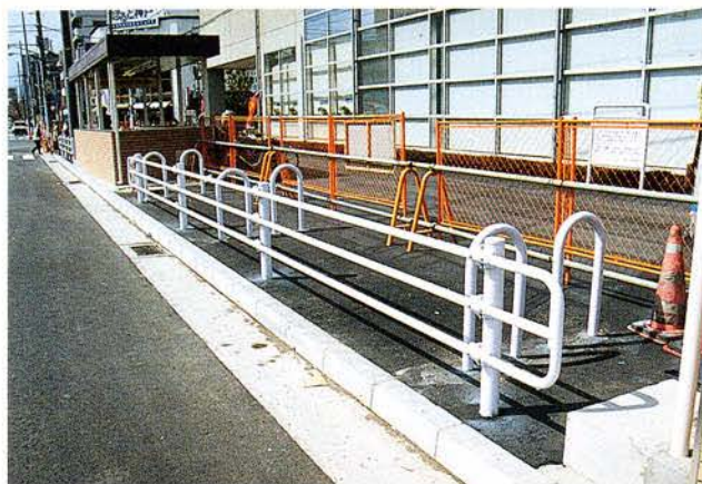
路上施設(ガードパイプ、転倒防止柵)設置状況
