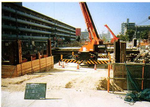
路面覆工撤去状況
