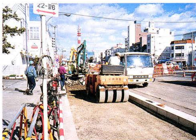
歩道実掘部 路盤転圧状況
