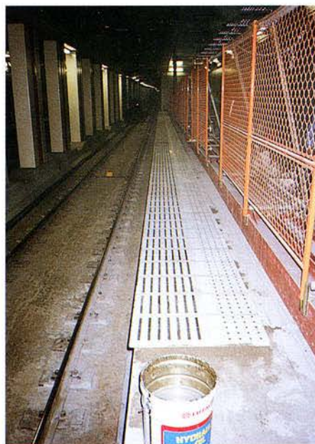
床先端テラゾタイル張り状況
