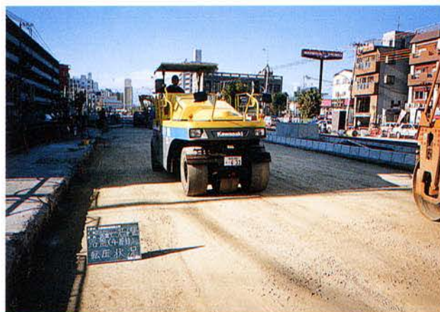
車道実掘部 路盤転圧状況
