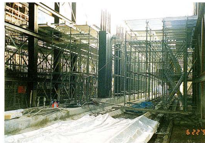
型枠支保工組立て
