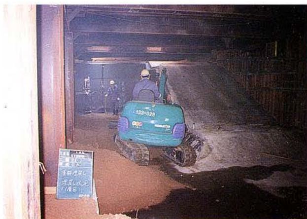
頂部埋戻し状況(覆工下部)
