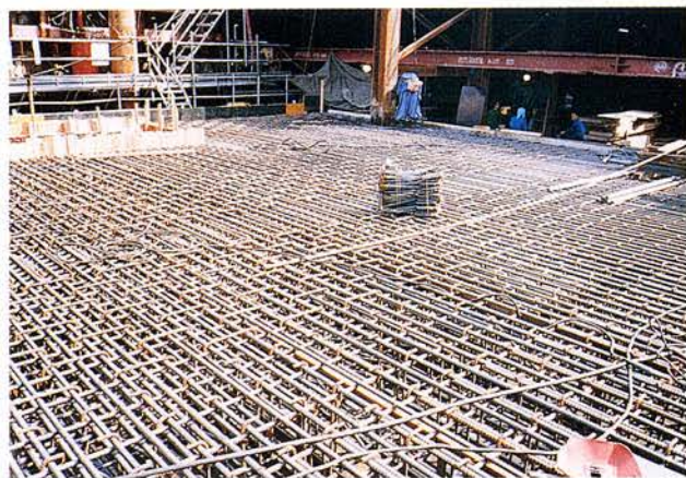
鉄筋組立状況
