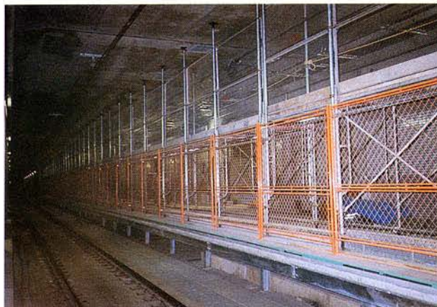
列車防護網設置状況
