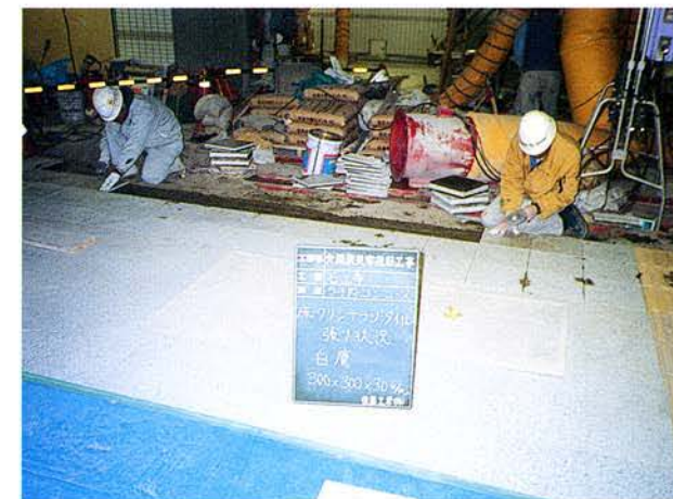
床クリンテラゾタイル張り状況（コンコース階）
