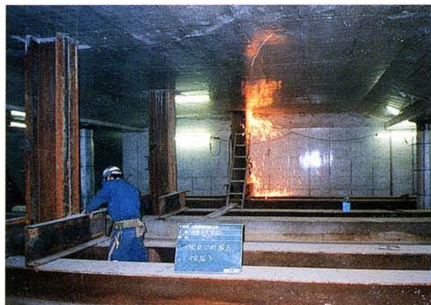
中間杭撤去状況(コンコース階)
