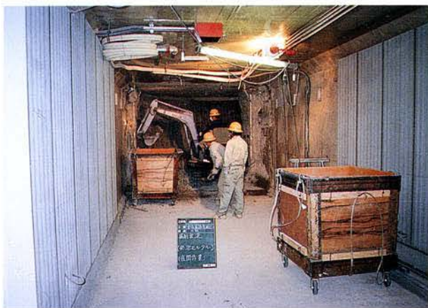
発泡モルタル掘削状況(出入口部)
