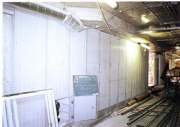
アスロック建込み状況（コンコース階）
