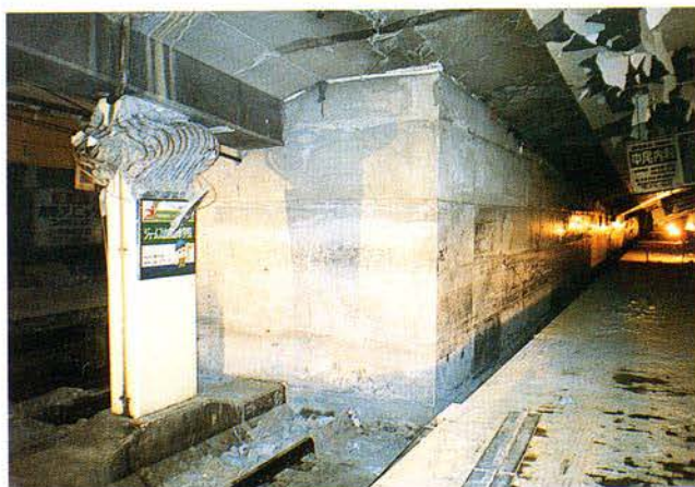
仮受エアモル工
