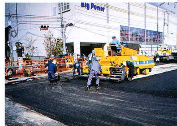
車道実掘部 基層敷均し状況
