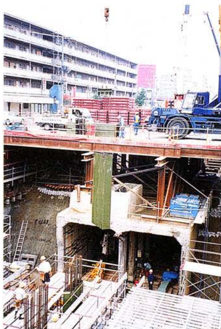
中柱鋼管柱建込み
