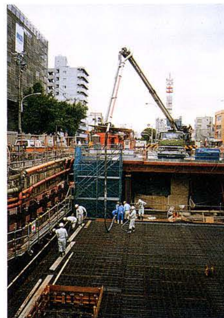
コンクリート打設状況
