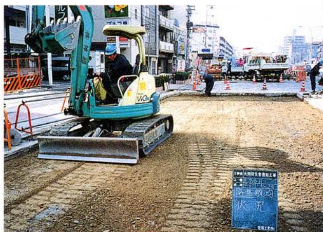
車道影響部 路盤敷均状況
