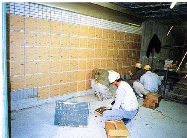
壁タイル張り状況（コンコース階）
