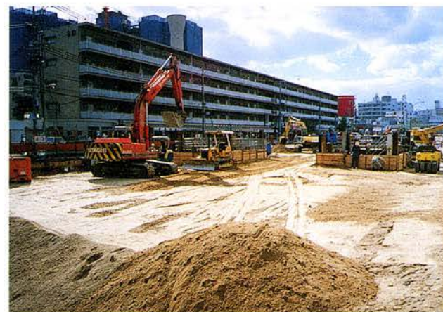
頂部埋戻し(路床)状況
