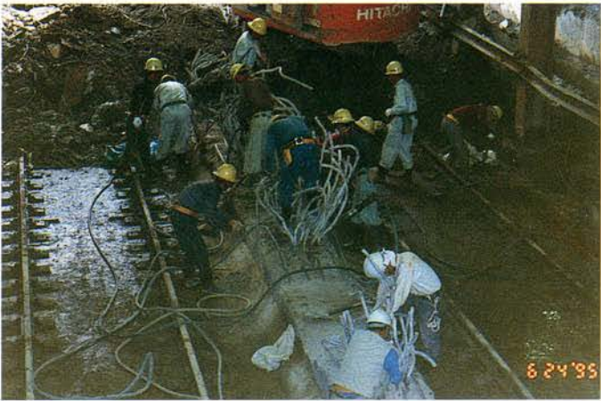
軌道防護工撤去工
