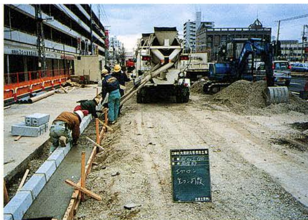
街渠工(エプロン打設)
