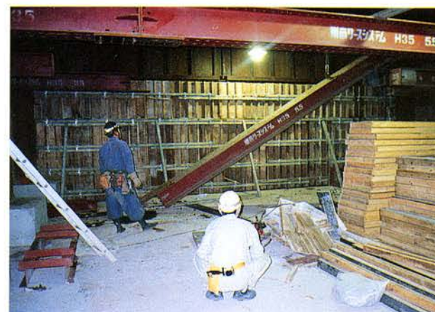
切梁撤去状況
