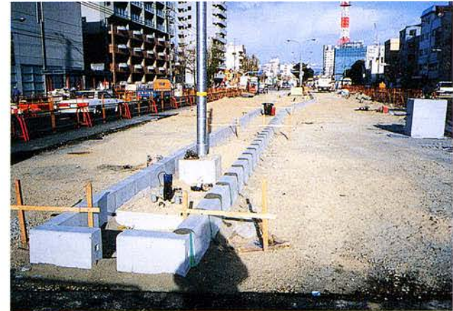
中央分離帯工(緑石据付)
