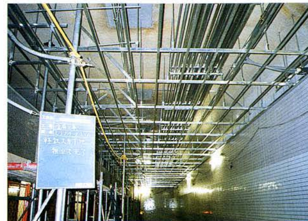
軽量鉄骨天井下地組立完了(プラットフォーム)
