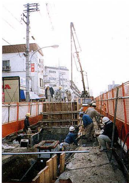
コンクリート打設状況(出入口部)
