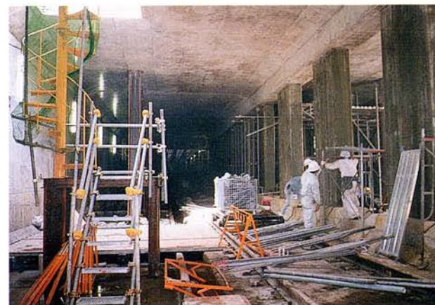
躯体仕上がり状況（構内）
