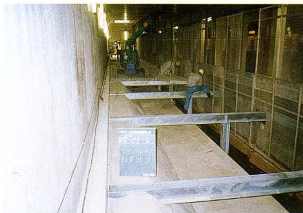
スパンクリート設置状況
