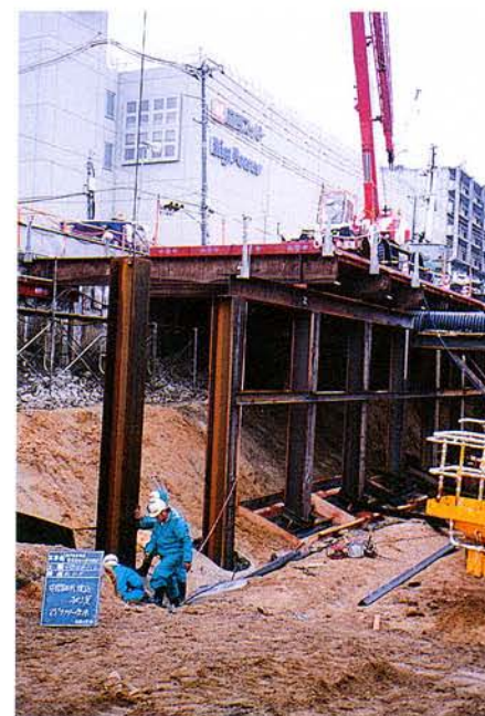
中間杭建込み(路面覆工)
