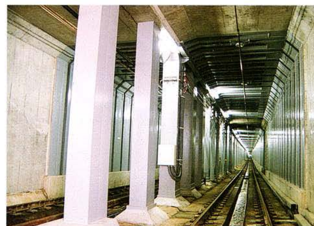
一般軌道部仕上がり状況
