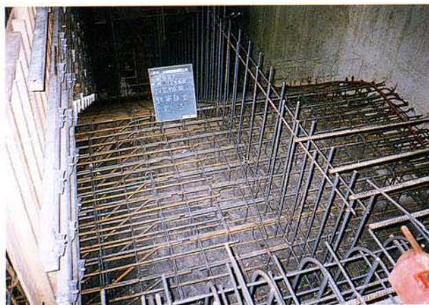
鉄筋組立状況(階段部)
