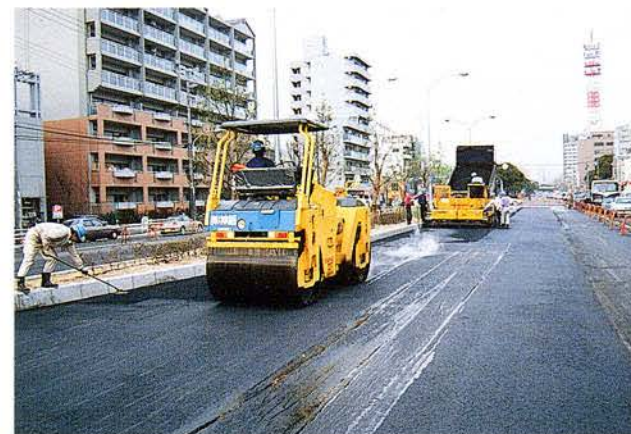
車道部 表層工
