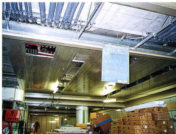
天井スパンドレル取付完了（コンコース階）
