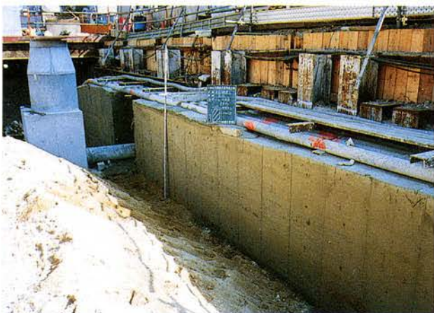
埋設管受防護状況
