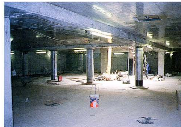
コンコース階仕上がり状況
