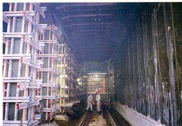
一般軌道部補強工
