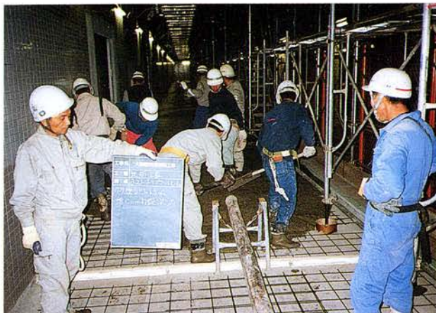
増しコンクリート打設(プラットフォーム)
