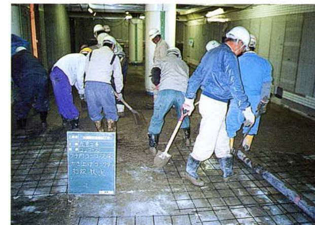
床増しコンクリート打設状況（コンコース階）
