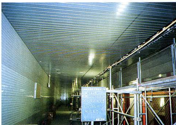
天井スパンダレル取付完了(プラットフォーム)
