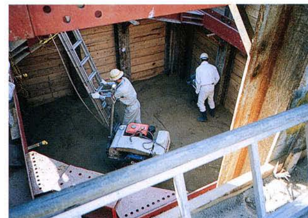
施工開口部埋戻し状況
