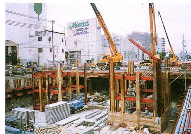
施工開口部土留め状況
