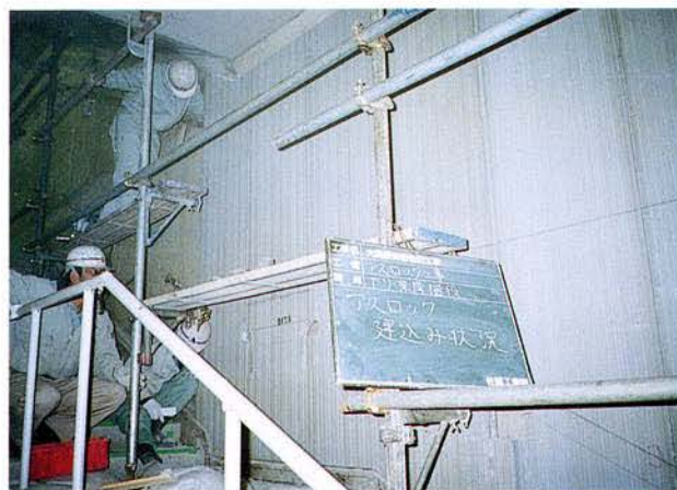
アスロック建込み状況(階段部)
