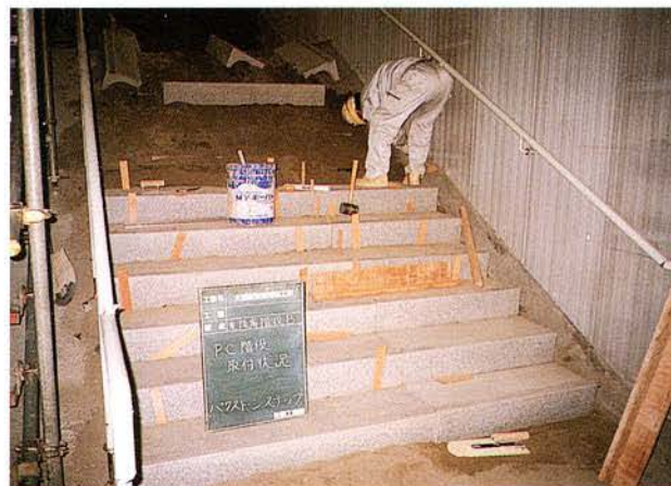
PC階段取付状況
