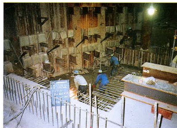
アースアンカー撤去状況
