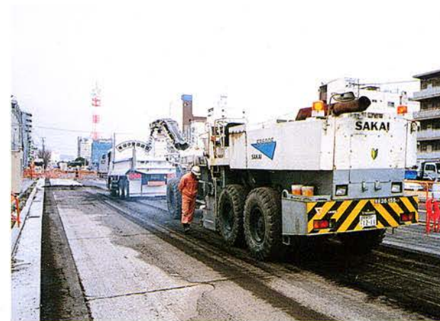
車道切削オーバーレイ部 切削状況
