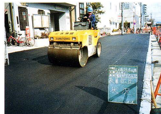
歩道部 表層転圧状況
