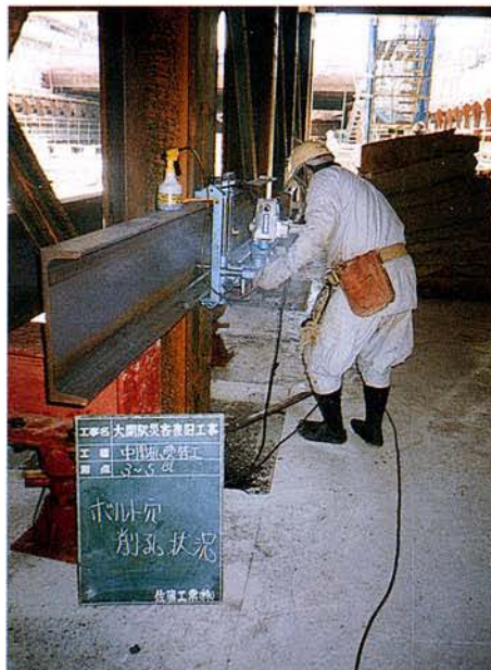
中間杭受替工
