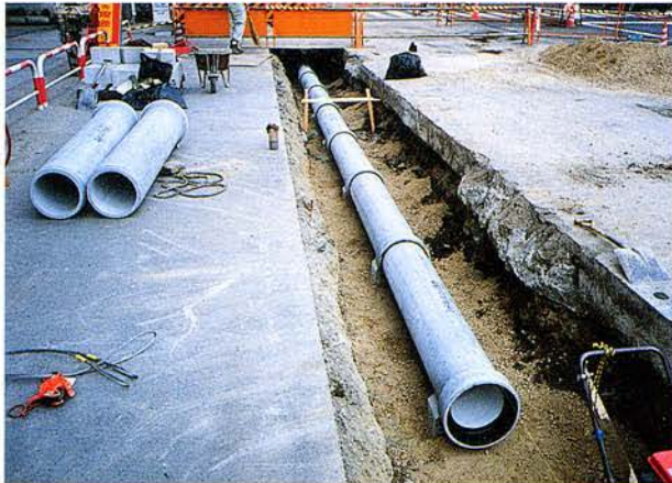
街渠工(ヒューム管据付)
