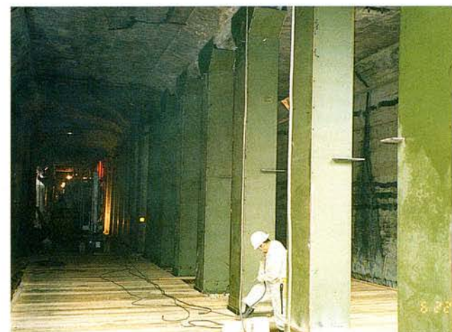
既設中柱補強工
