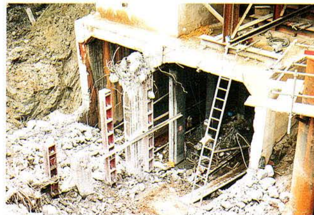
本体構築壊し工 (西側境界部)
