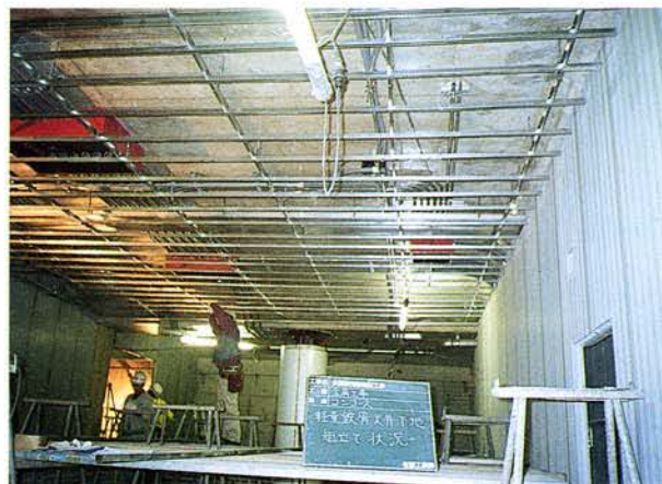
軽量鉄骨天井下地組立完了（コンコース階）
