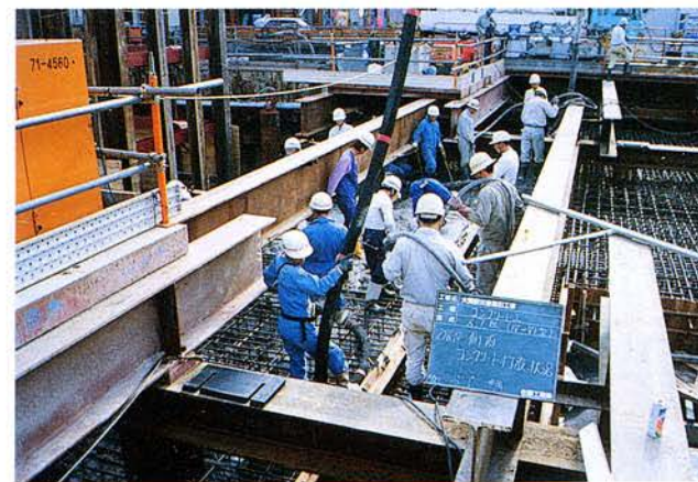
コンクリート打設状況(二層部)
