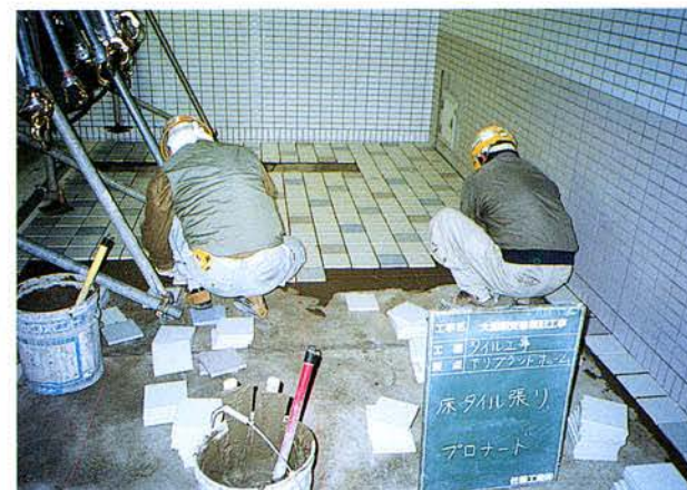
床タイル張り状況(プラットフォーム)
