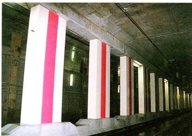
駅部仕上がり状況（大開駅通過時）
