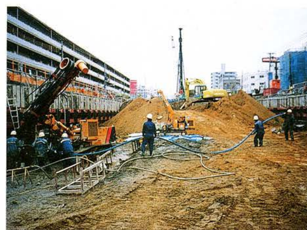
アースアンカー工
