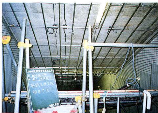
軽量鉄骨天井地下地組立完了(階段部)
