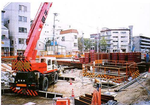
路面覆工状況
