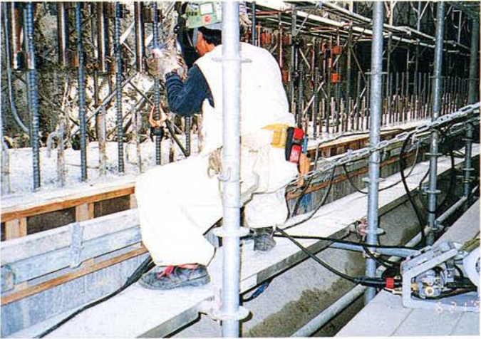
鉄筋エンカ-ズ溶接
