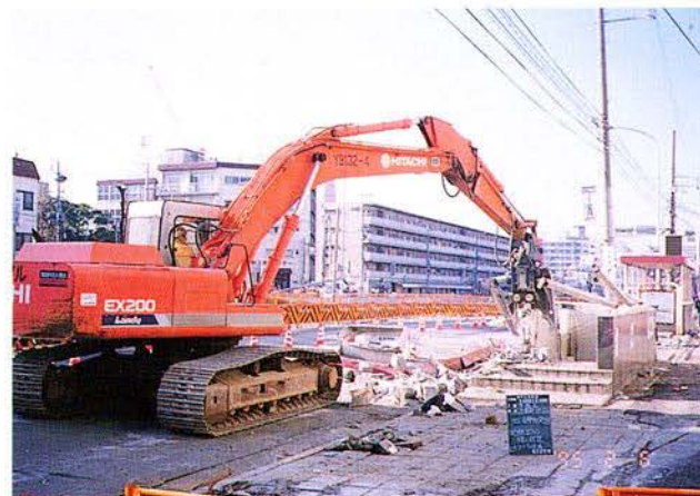
出入口部撤去工
