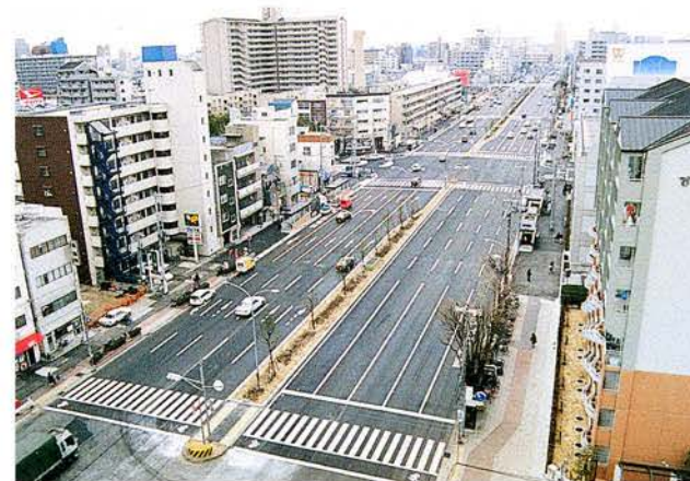
現場全景(施工完了)
