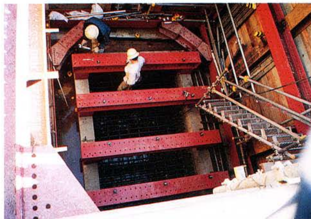
施工開口部閉塞(鉄筋組立)状況
