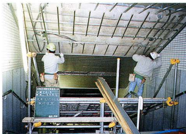
天井スパンデル取付状況(階段部)
