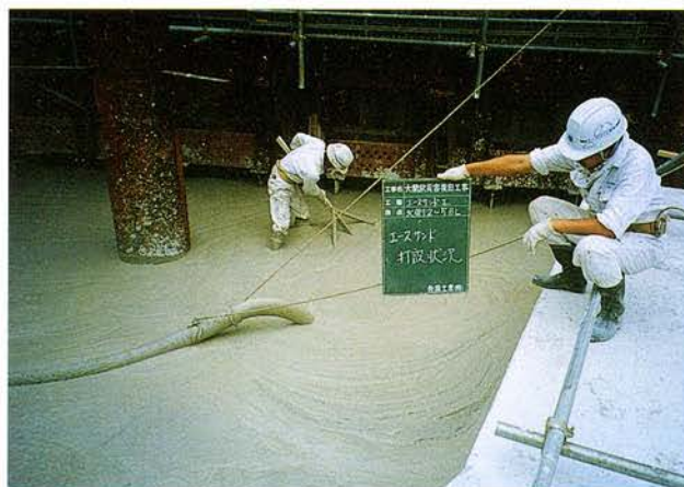
側部埋戻し状況
