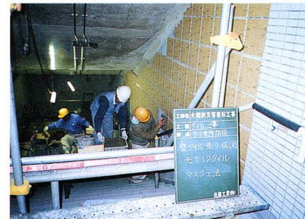
壁タイル張り状況(階段部)
