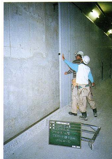
アスロック建込み状況(プラットフォーム)
