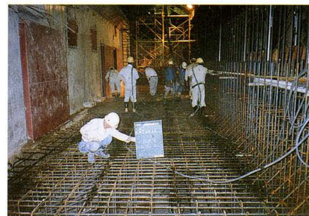
コンクリート打設状況(拡幅部底床)
