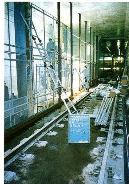
線路防護網設置状況
