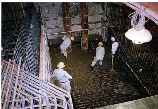
コンクリート打設状況(連絡通路部)
