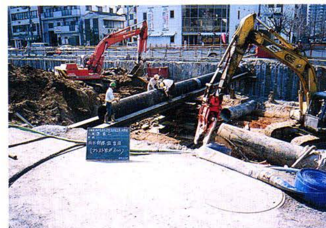
雨水幹線仮復旧
