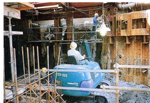
掘削状況(連絡通路部)
