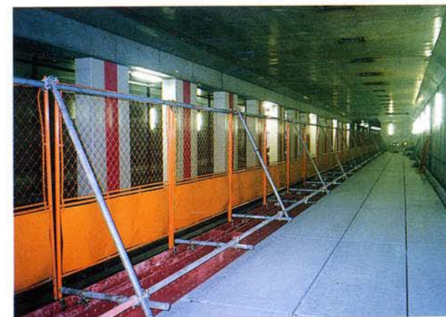
線路防護網盛替完了
