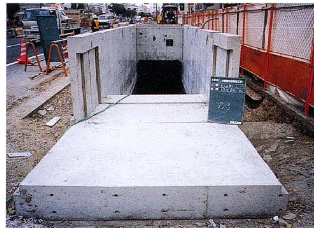
出入口部構築完了
