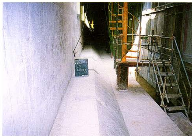
隅角部補強状況
