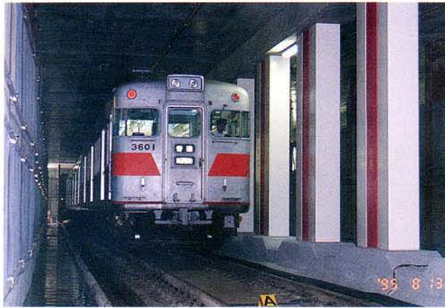
開通状況（大開駅通過）
