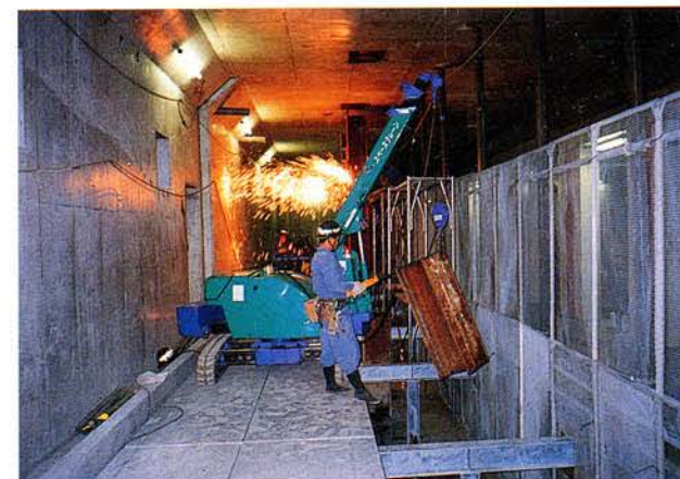
中間杭撤去状況(構内)
