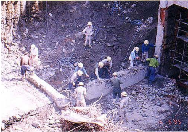
躯体砕り状況（人力）
