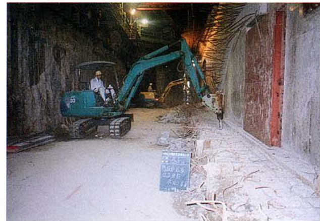
階段部底床スラブハツリ状況
