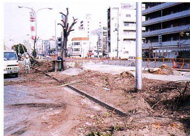
中央分離帯撤去
