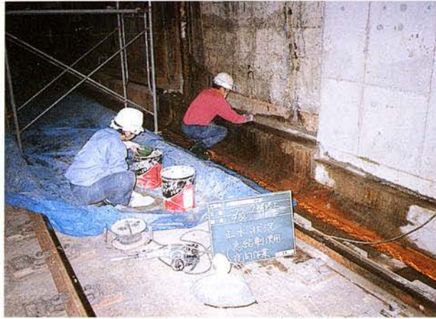
クラック補修状況(坑内)
