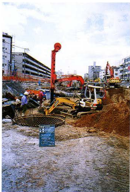
深礎工(路面覆工)
