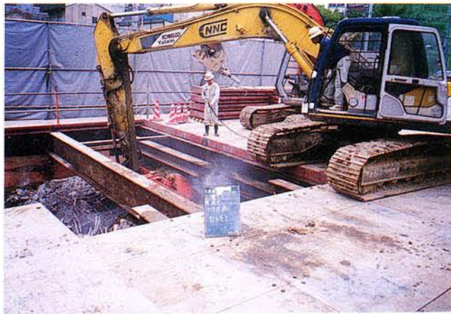
軀体壊し工（2層部上スラブ）
