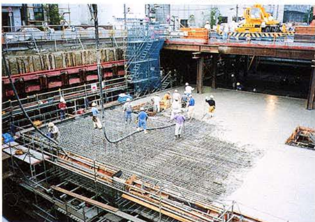
写真 5. 11. 1-5 スラブ鉄筋組立状況
