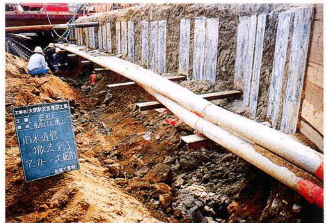
写真 5. 4. 2-5 受け防護状況
