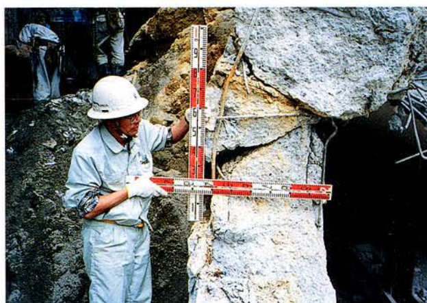
写真 5. 10. 6-1 コンクリート壁厚
