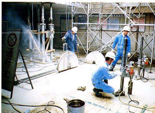
写真 5. 1. 2-3 中床スラブ切断状況
