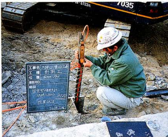
写真 5. 9. 4-1 計測機器の設置状況(1)
