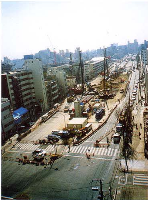
南側土留杭打設時 写真 5. 2. 8-3
