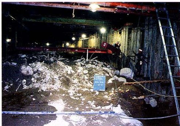
写真 5. 8. 1-1 支保工架設状況(1)
