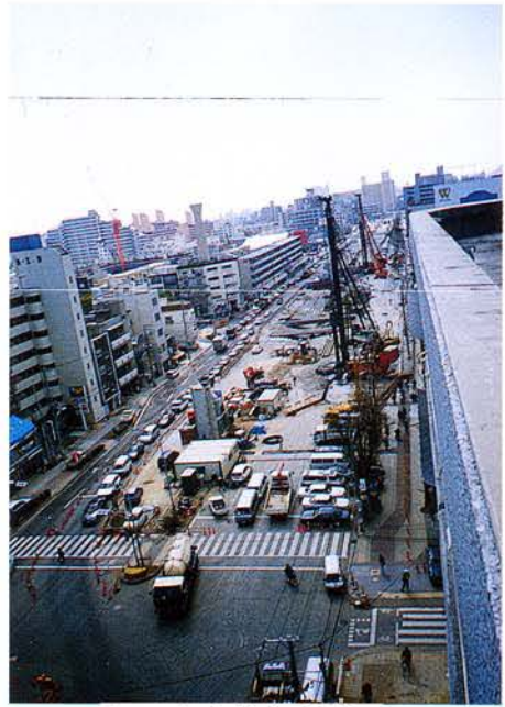
北側土留杭打設時 写真 5. 2. 8-2
