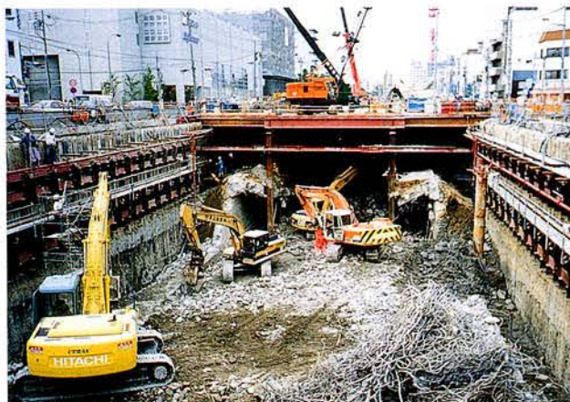
写真 5. 10. 1-1 躯体撤去状況
