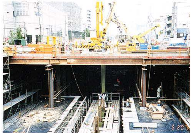
写真 5. 11. 1-4 中柱建て込み状況
