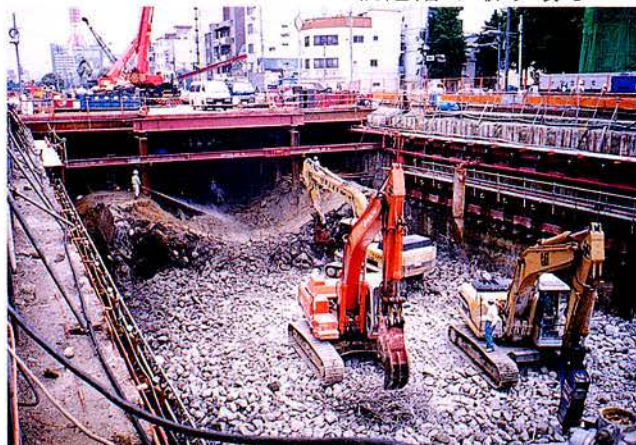
写真 5.10.2-2 軌道階取り壊し状況
