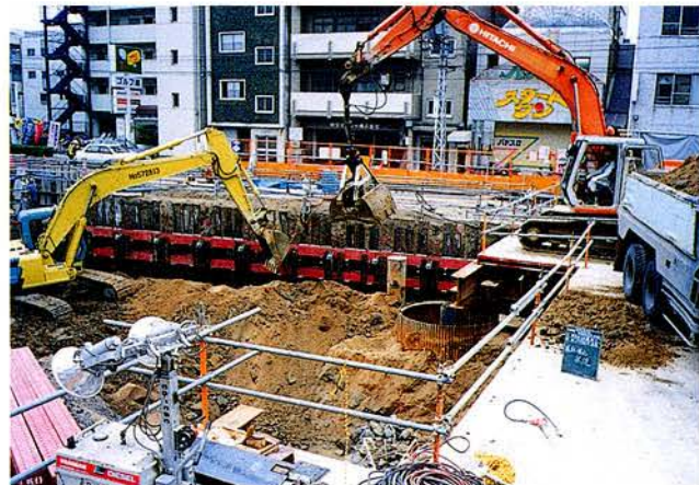
写真 5.4.2-2 二次掘削状況
