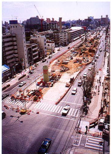
施工完了後 写真 5. 2. 8-4
