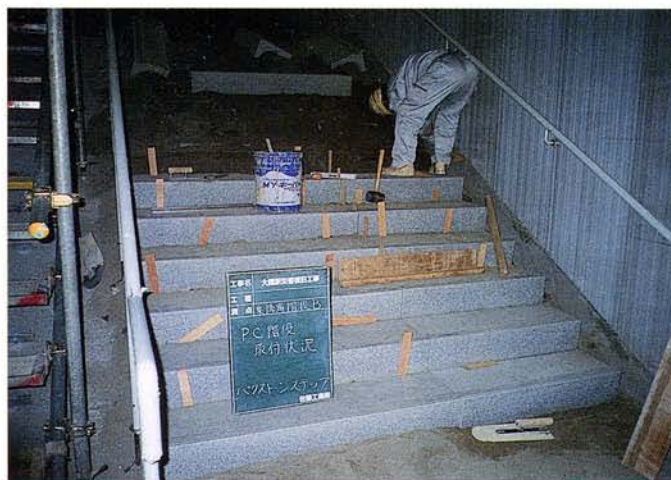
写真5. 16. 2 -2 PC階段取付状況
