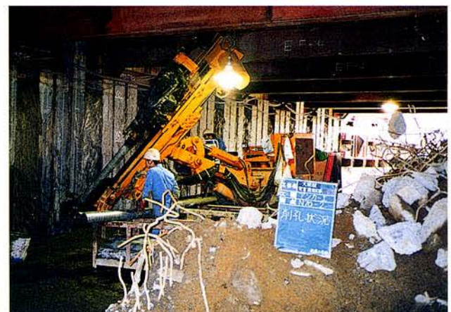
写真 5. 7. 1-2 削孔状況（覆工下）
