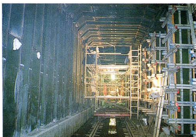
写真 5. 12. 3-3 無収縮モルタル打設状況
