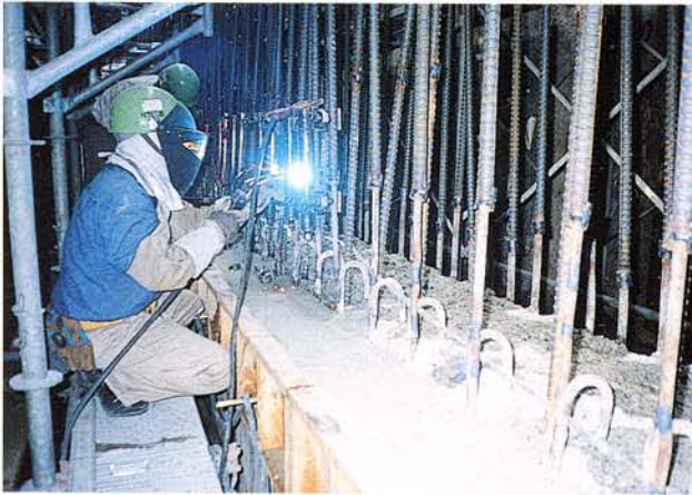
写真 5. 11. 1-3 エンクローズ溶接状況
