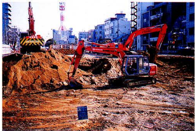
写真 5. 4. 2—1 一次掘削状況
