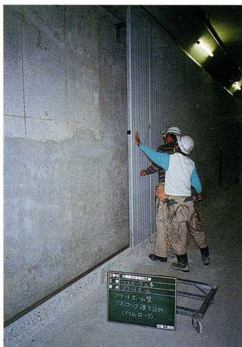
写真5. 16. 2 -1 アスロック建て込み状況
