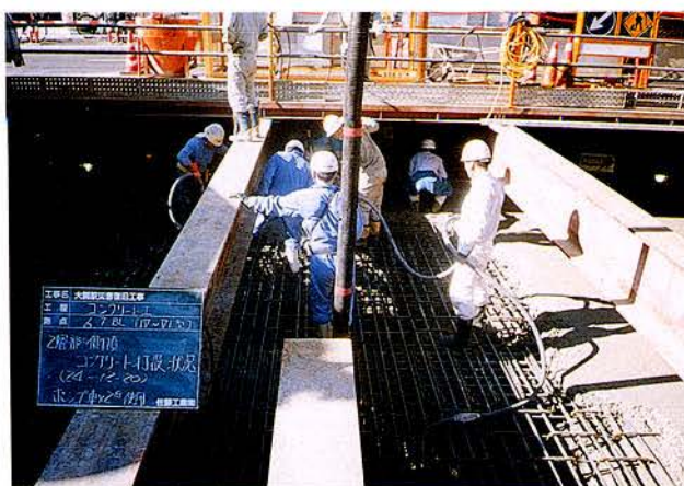
写真 5. 11. 1-8 コンクリート打設状況(2層部側頂)
