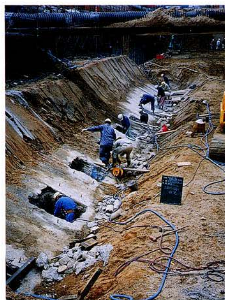
写真 5. 6. 1—2 上床スラブハツリ状況
