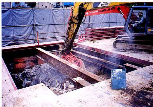
写真 5.10.2-1 上床スラブ取り壊し状況
