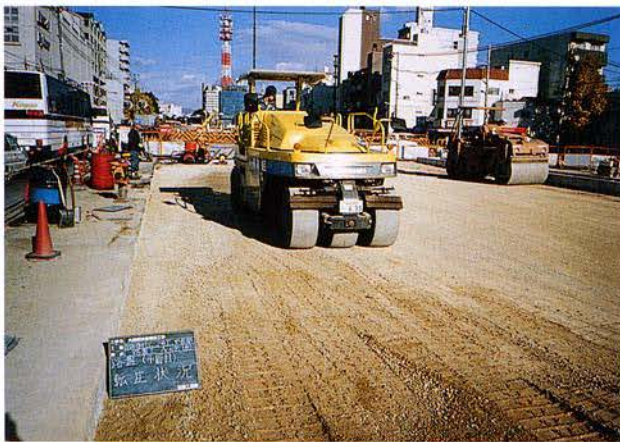
写真 5. 15. 2-1 路盤転圧状況
