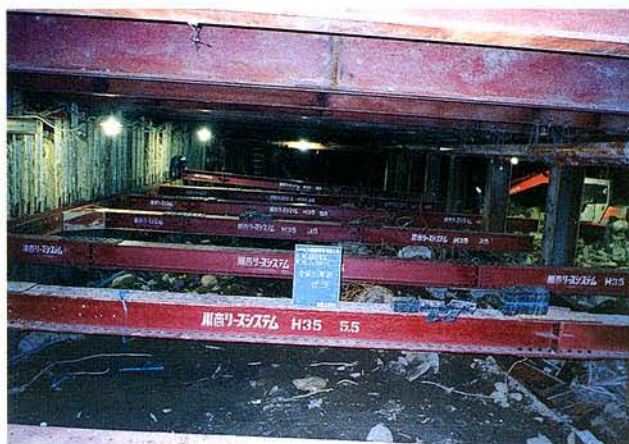
写真 5. 8. 1-2 支保工架設状況(2)
