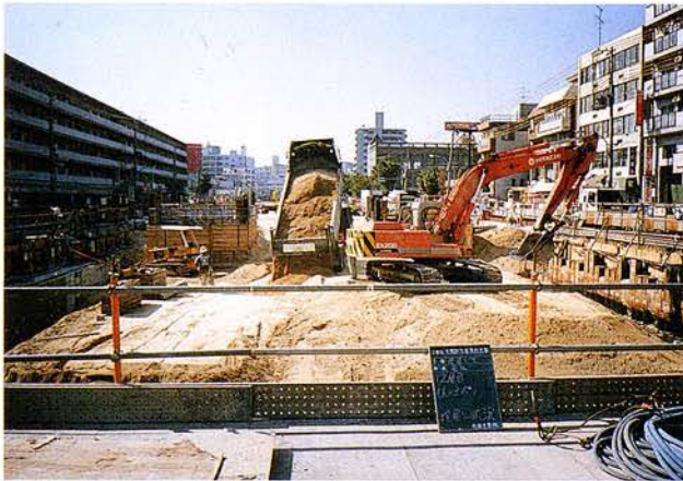
写真 5. 14. 4-1 埋戻し状況(真砂土)
