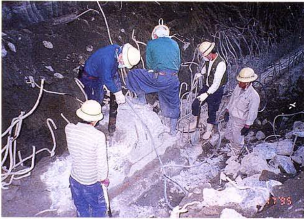
写真 5. 11. 1-1 仕上げハツリ状況
