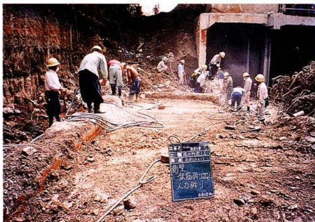
写真 5. 10. 6—4 人力によるハツリ状況
