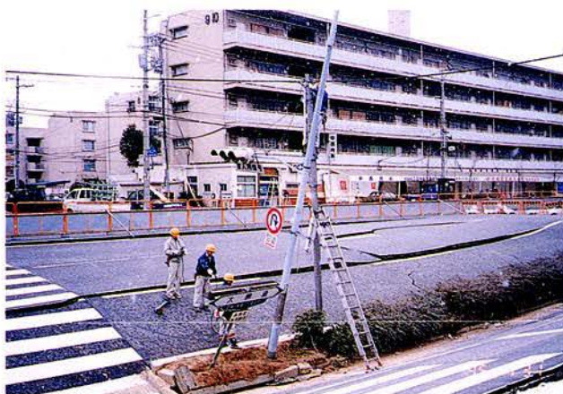
写真5. 1. 3—2 信号機撤去状況
