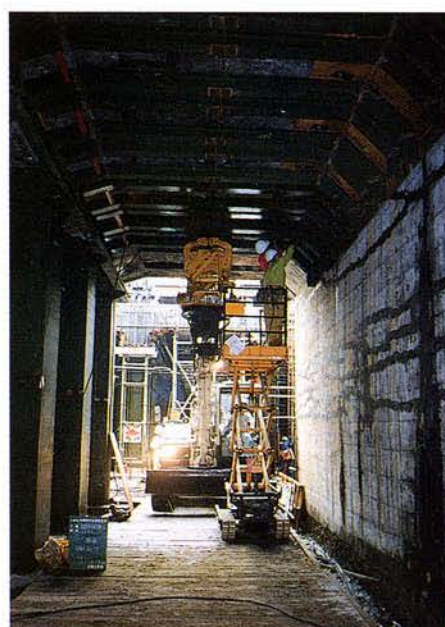
写真 5. 12. 3-2 鋼材取付状況
