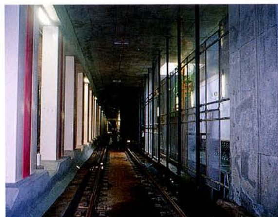
写真 5. 11. 4-1 線路防護網設置状況(1)
