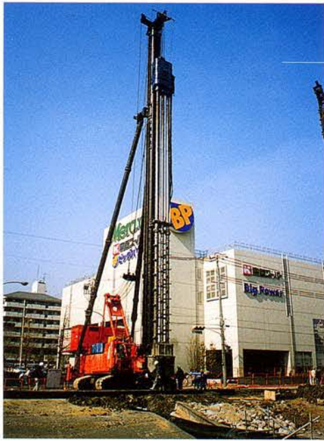
3 点式杭打機 (DH608-120M, M90D) 写真 5. 2. 8-1
