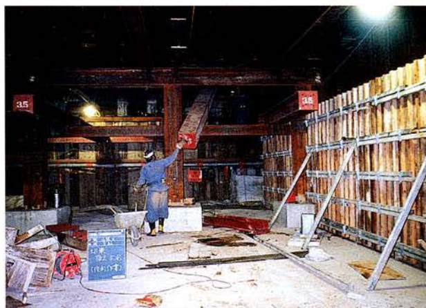
写真 5. 8. 2-1 切梁撤去状況
