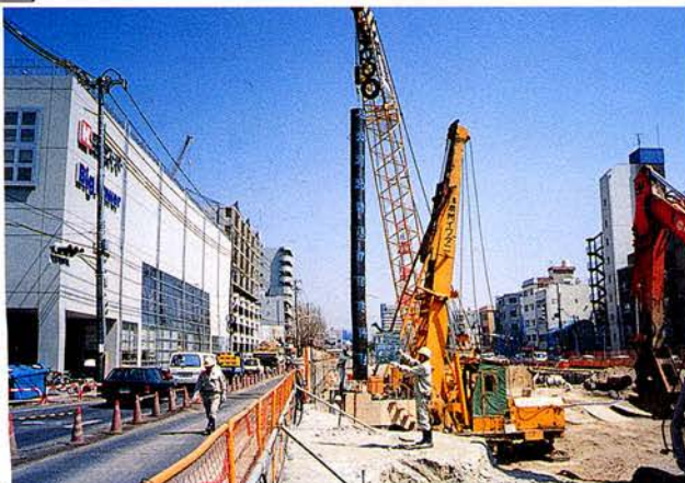
写真 5. 5. 5-2 建て込み状況 ベノト機にてケーシングチューブを引き抜き豆砂利を補充しながら抜き取った。
