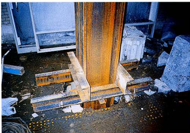
写真 5. 6. 1—1 中間杭建て込み状況
