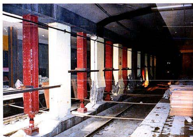
写真5. 1. 6-2 H型鋼とジャッキによる 仮受防護
