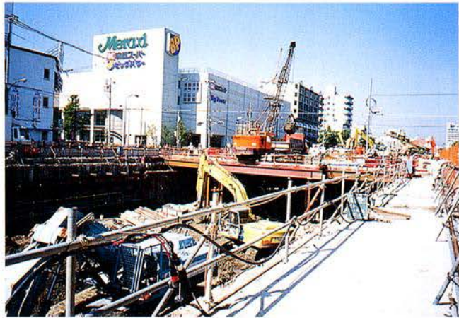
写真 5. 4. 2-3 三次掘削状況
