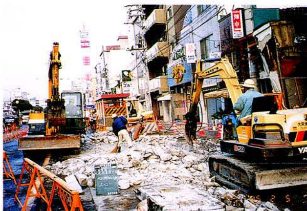
写真5. 1. 3—1 出入口撤去状況
