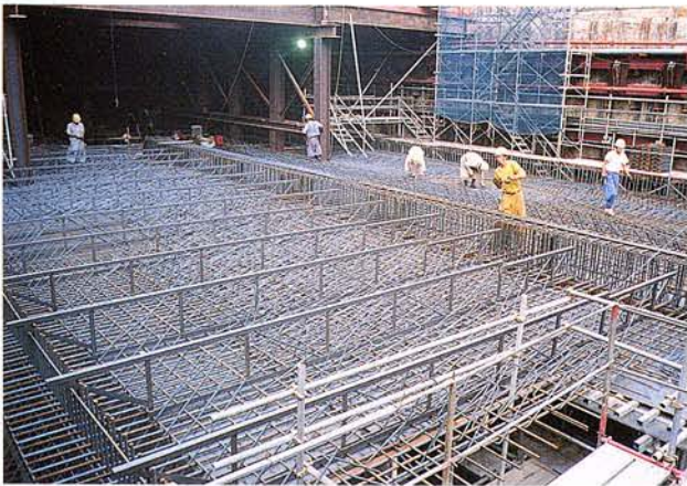
写真 5. 11. 1-5 スラブ鉄筋組立状況
