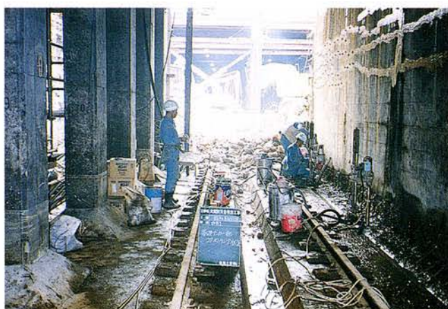
写真 5. 12. 3-1 基礎コアボーリング状況
