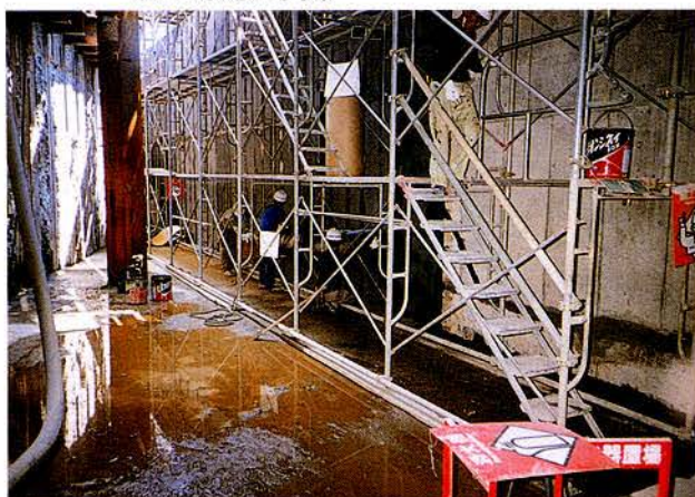
写真 5. 13. 2-1 側部施工状況
