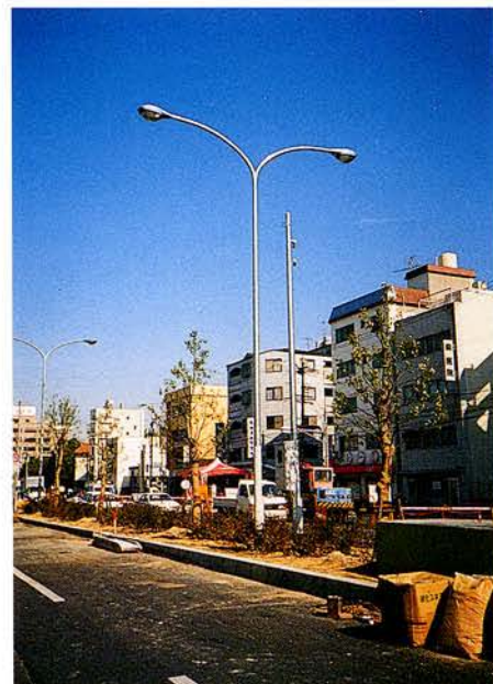
写真 5. 15. 5—1 街路灯設置状況
