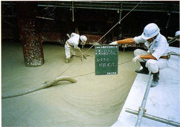
写真 5. 14. 2-1 エースサント打設状況
