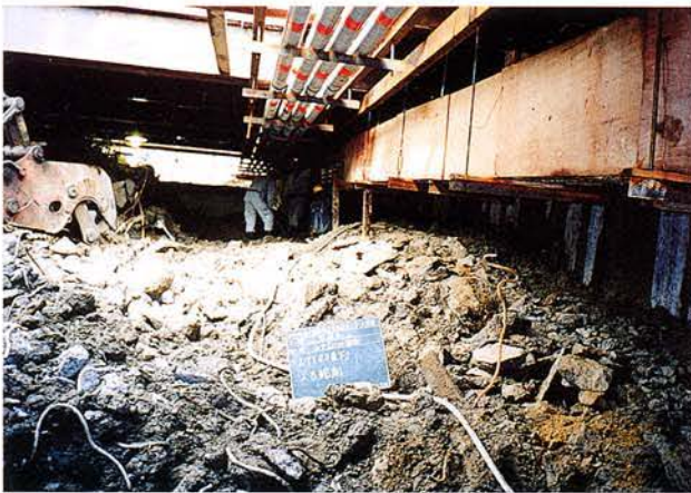
写真 5. 4. 2-4 吊り防護状況
