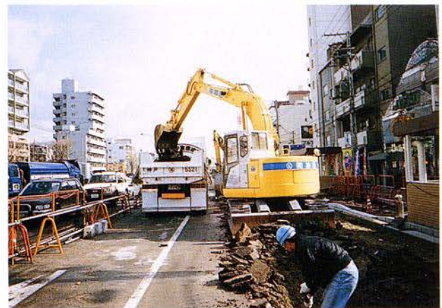
写真 5. 15. 2-2 ガラ積み込み状況
