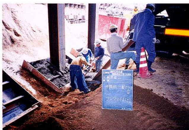
写真 5. 6. 1—3 コンクリート打設状況
