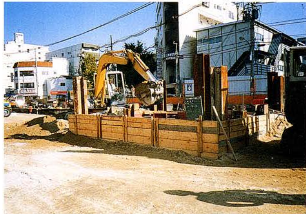
写真 5. 14. 4-2 施工開口部土留状況
