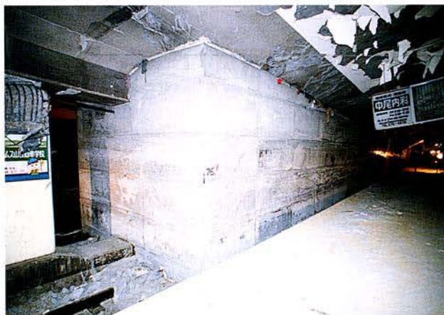
写真5. 1. 6-1 エアミルクによる仮受防護
