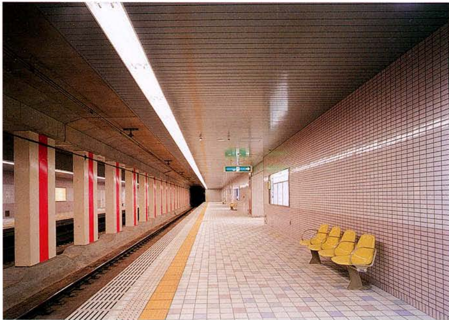
写真5. 16. 2-5 プラットホーム完成
