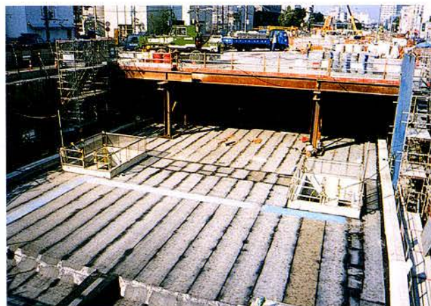
写真 5. 13. 2-2 頂部施工状況
