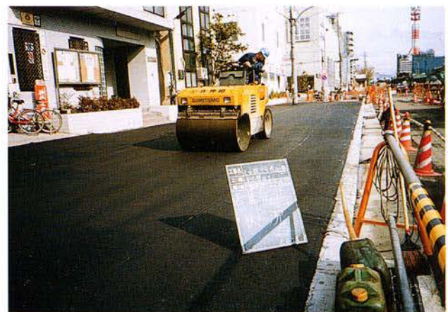
写真 5. 15. 2-4 表層転圧状況
