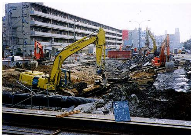
写真 5. 4. 1-1 舗装壊し状況
