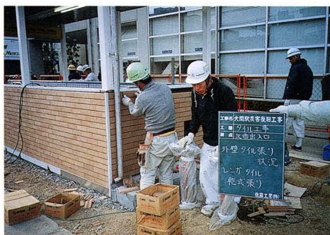
写真5. 16. 2 -3 外壁タイル張り状況
