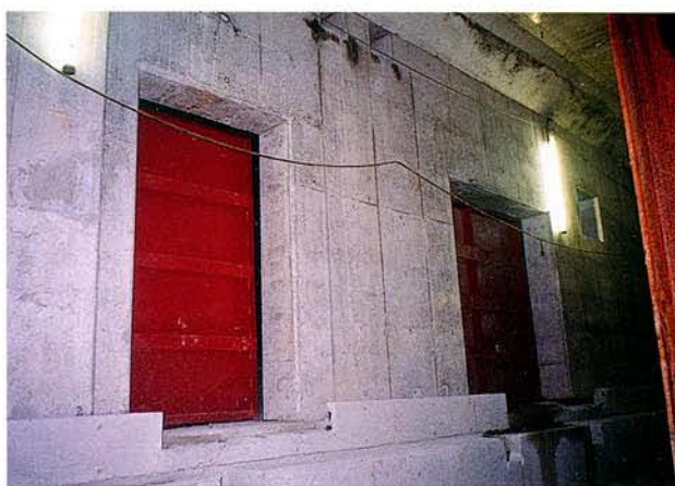
写真 6. 2. 2-1 止水鉄板設置状況
