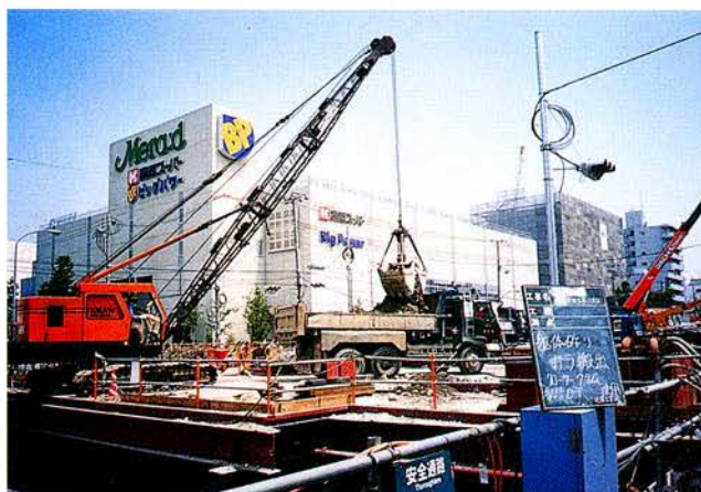
写真 6. 1. 7-1 ガラ積み込み状況
