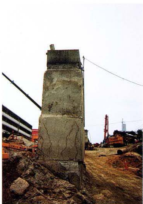
換気塔の側面 上部が海側から山側へ移動
