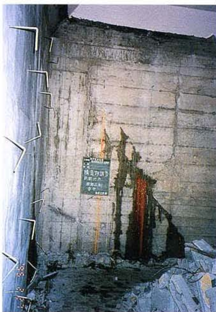
新開地側妻壁（山側）
