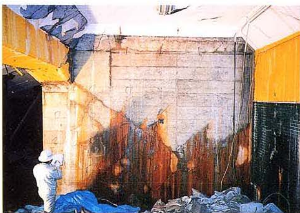
階段付近妻壁（山側）
