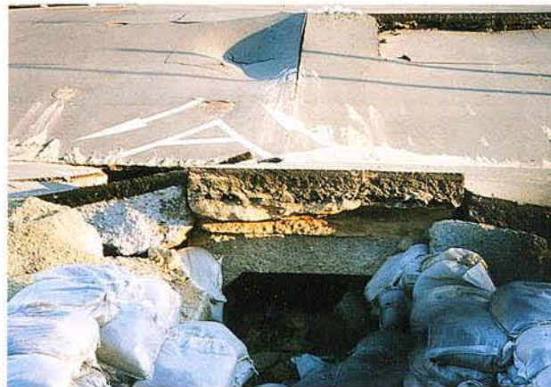
横断雨水管渠1.2m×1.2m
