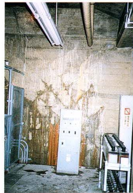
新開地側 側壁
