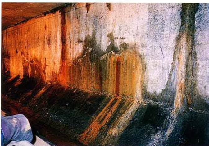
中柱②付近のプラットホーム下の側壁（海側）
