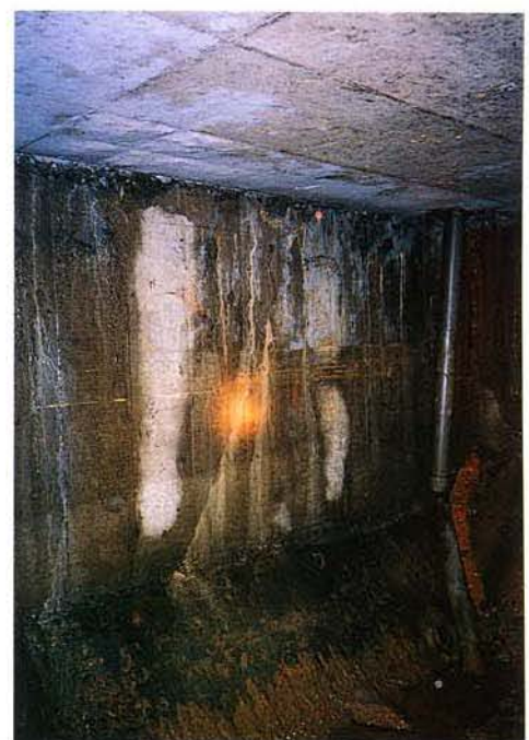
中柱①付近のプラットホーム下の側壁（海側）
