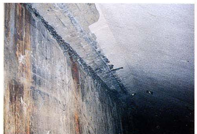
側壁上部ハンチ部（海側）
