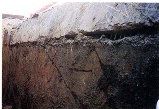
側壁外側（海側）
