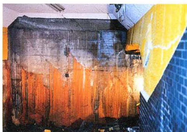
階段付近妻壁（海側）
