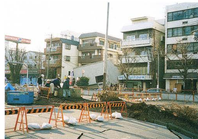
新開地側換気口付近（山側）
