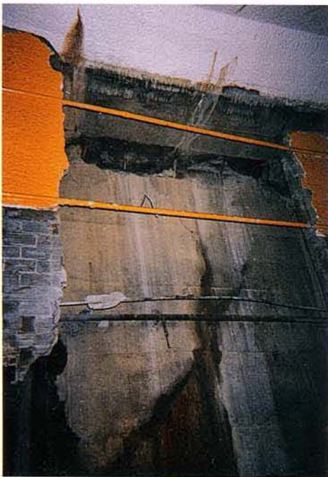
中柱 ④ 海側
