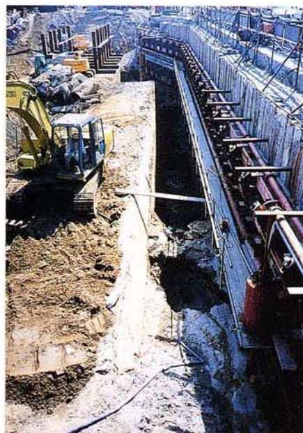
高速長田側端部付近（山側）
