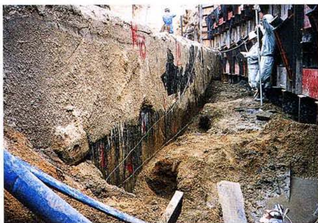
新開地側端付近の側壁外面（海側）
