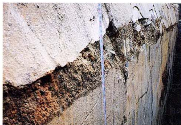
側壁外側（山側）
