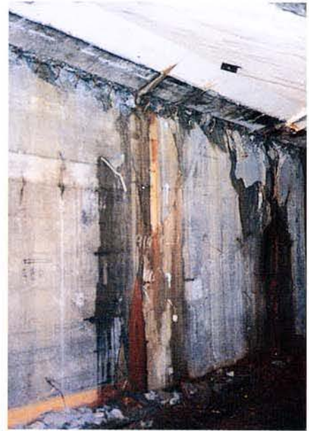
中柱⑭付近の側壁（海側）
