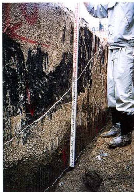
新開地側端付近の側壁外面（海側）
