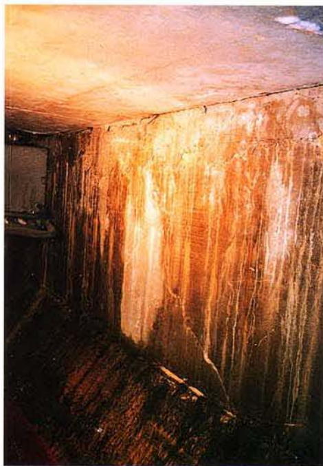
中柱①付近のプラットホーム下の側壁（山側）
