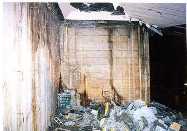
高速長田側妻壁（海側）
