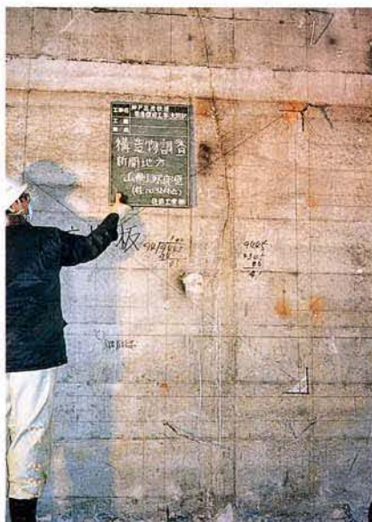
新開地側の側壁（山側）
