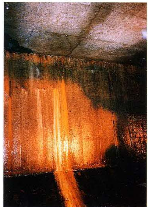
中柱②付近のプラットホーム下の側壁（海側）
