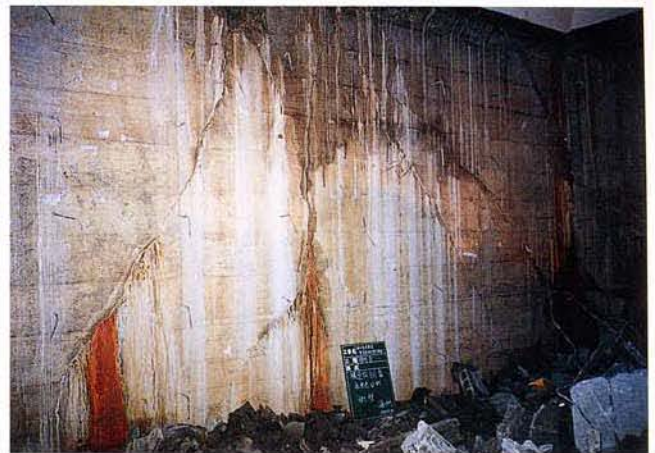
高速長田側妻壁付近の側壁（海側）
