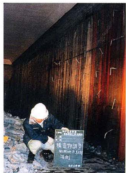
新開地側の側壁（海側）
