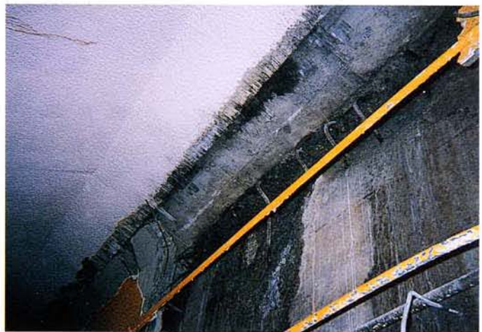
中柱 ⑨ 海側
