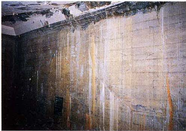
高速長田側妻壁付近の側壁（山側）
