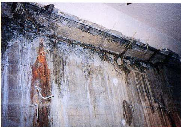
側壁上部ハンチ部（山側）
