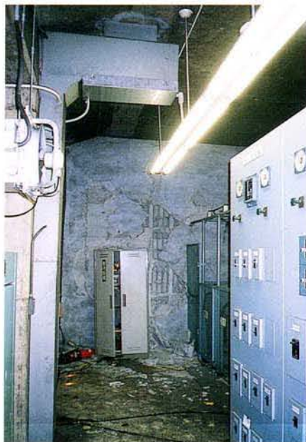
新開地側 隔壁
