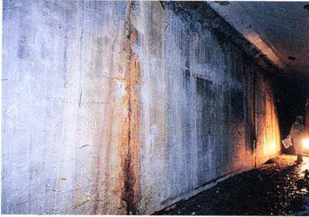
中柱⑫付近の側壁（山側）
