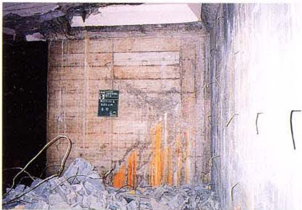
高速長田側妻壁（山側）
