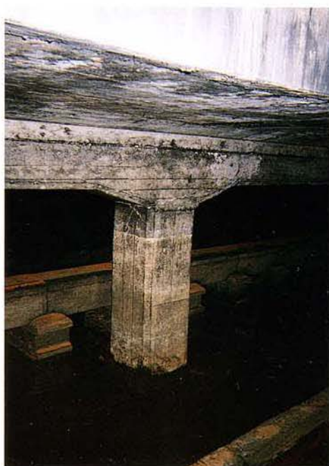
プラットホームの支柱
