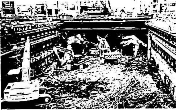
写真-1 躯体の取壊し状況
