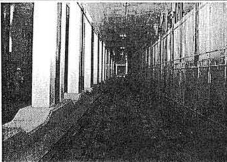
一辺45センチのRC鋼管柱3本を結合した中間柱がしっかりと大開駅を支える。13日から電車が走り、直近でホーム、駅舎の復旧が続けられる (佐藤工業)
