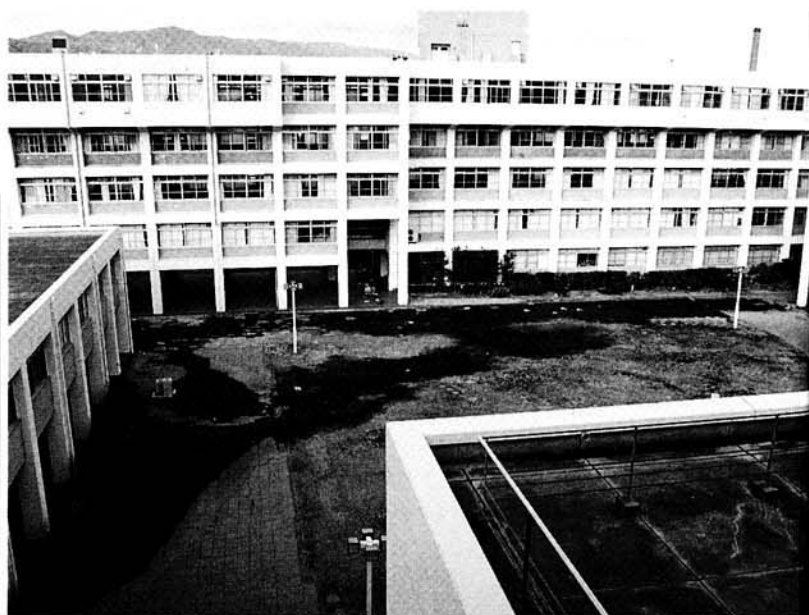
液状化により黒い水の噴出した中庭
