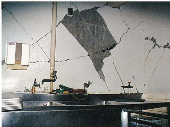
第一病棟 1階調理場南側トイレ壁等の損壊
