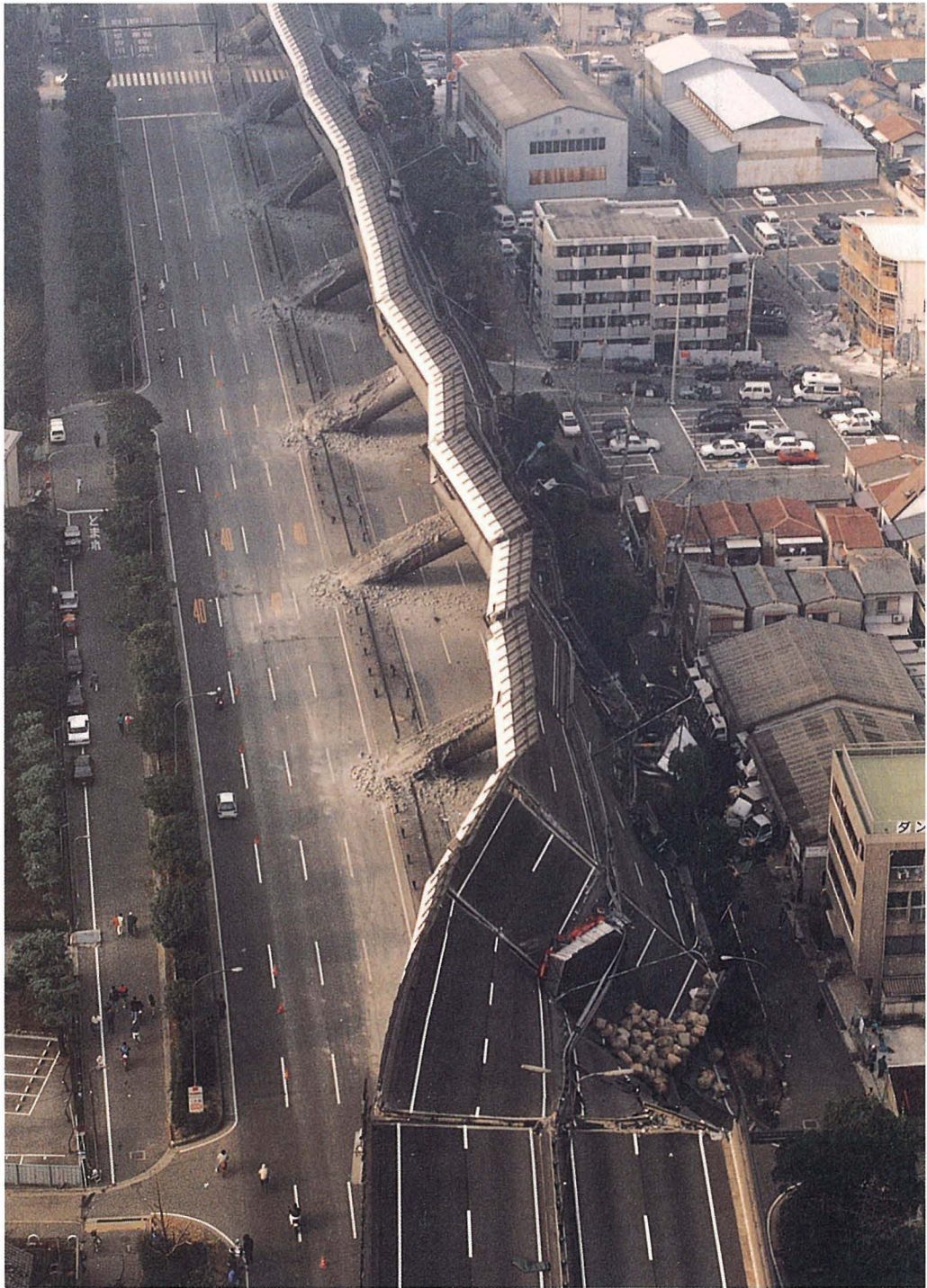
高速道路の損壊（神戸新聞社提供）
