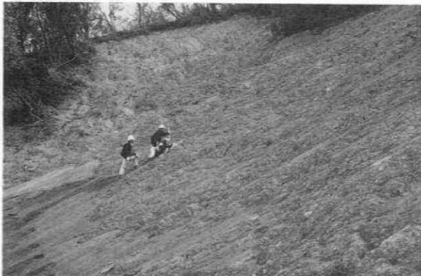
写真 4.1-71 崩壊頭部付近の状況
