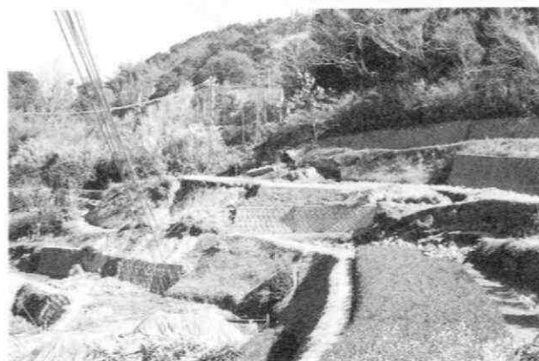
写真 4.1-44 断層運動による田畑の変状と撤去された鉄塔
