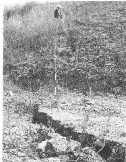
写真 4.1-55 すべり破壊の側部亀裂
