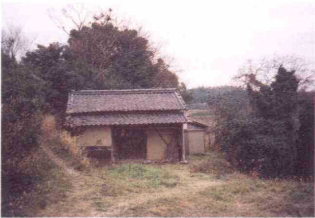
写真4.3-3 津名町志筑地区 丘陵地に残る古い家屋
