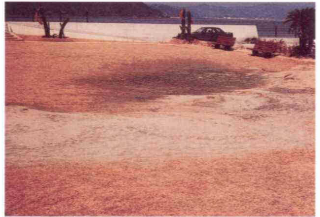
写真 4.1-30 洲本市塩屋埋立地における噴砂
