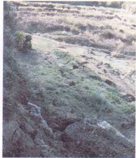
写真 4.1-9 断層運動による田畑の開口クラック (野島大川地区)
