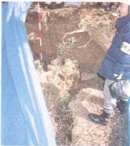
写真 4.1-10 断層運動により斜面中腹に生じた 開口クラック (野島轟木地区)
