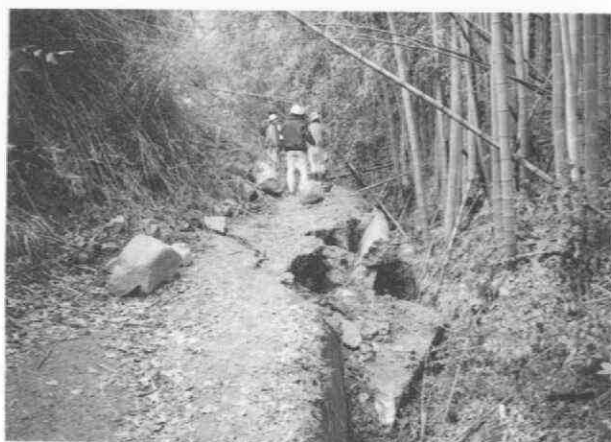
写真 4.1-77 野島断層の交差する山道の変状
