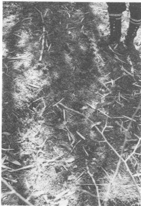
写真 4.1-88 コンクリート法枠工上方の 自然地山に生じた亀裂
