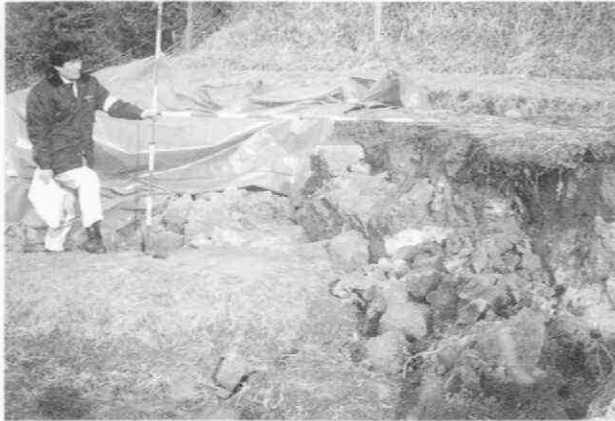
写真 4.1-46 野島断層の縦ずれ(約120cm)
