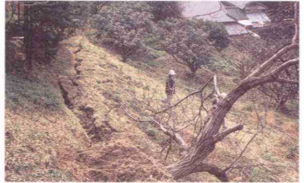
写真 4.1-15 民家上方の断層運動による開口クラック（野島養ノ浦）
