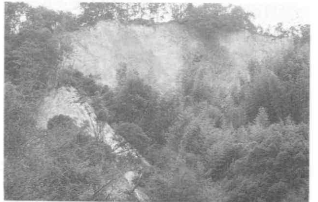
写真 4.1-87 簡保保養センター周辺部 における斜面崩壊
