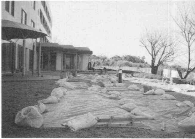
写真 4.1-90 簡保保養センター北側の庭に発生したクラック
