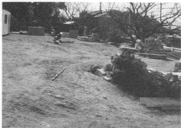
写真 4.1-74 八幡神社倒壊跡 (整地されてクラックは不明瞭)
