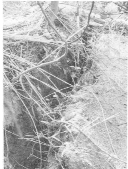
写真 4.1-36 野島断層沿いの開口クラック
