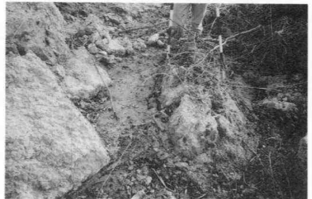
写真 4.1-105 変状跡に残された液状化による噴砂
