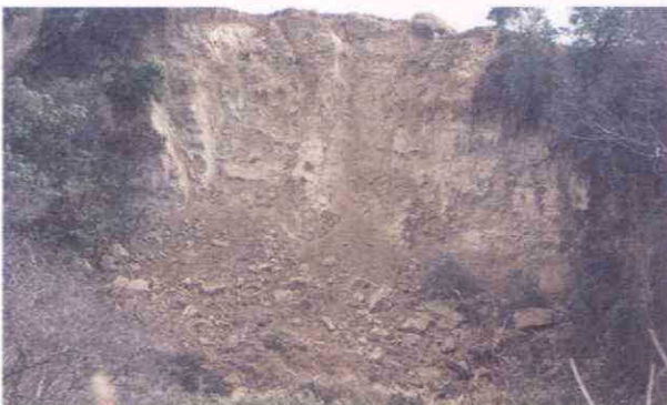
写真 4.1-20 簡保保養センター周辺部における斜面崩壊（富島地区）
