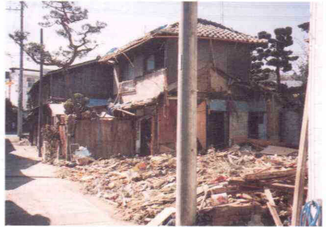
写真4.3-2 津名町志筑地区 ● 全壊家屋のそばに残る樹木
