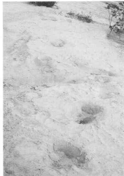
写真 4.1-114 SATY駐車場における 噴砂の痕跡
