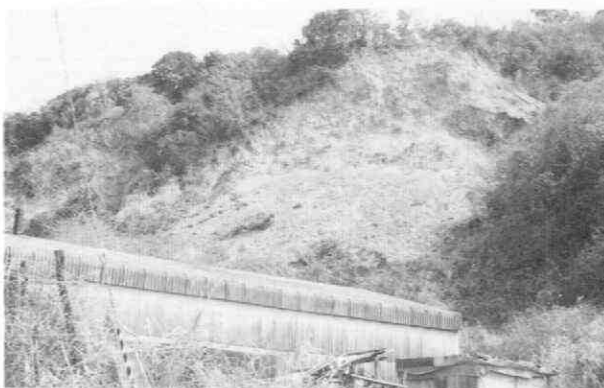
写真 4.1-39 周辺地山での表層崩壊
