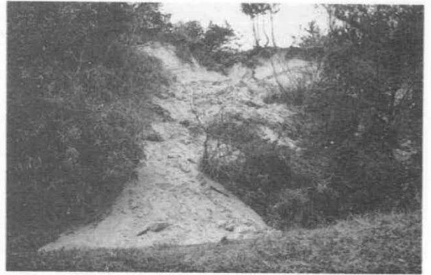
写真 4.1-85 簡保保養センター北西部 における斜面崩壊
