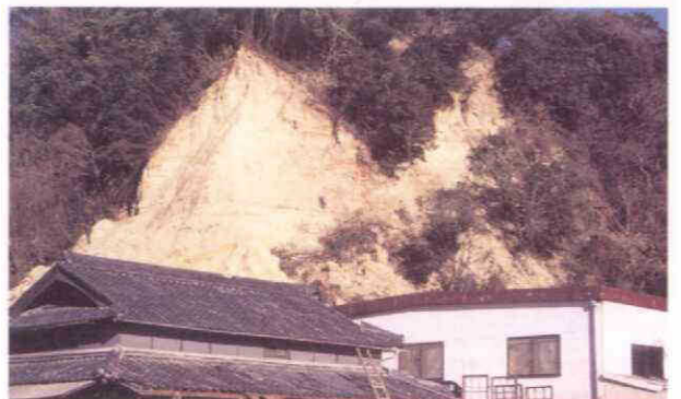
写真 4.1-21 民家背後の表層崩壊（育波地区）
