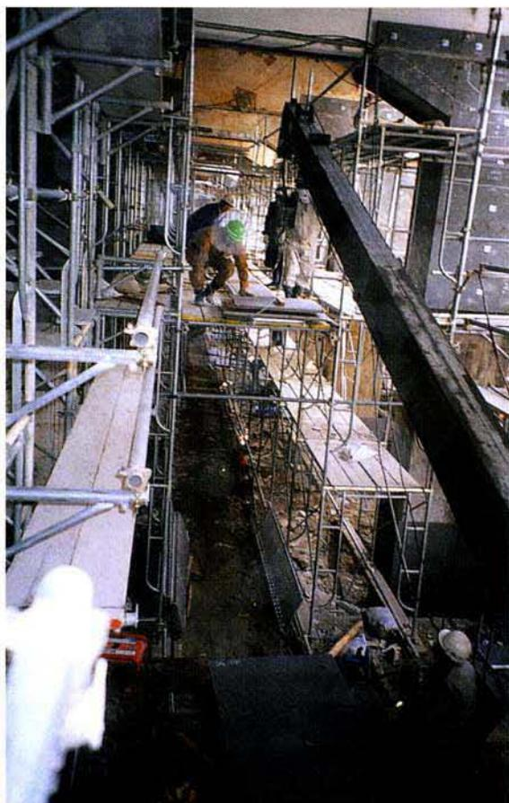
柱、鋼板巻施工中
