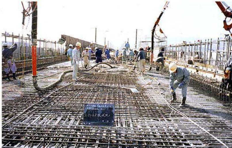
床版部のコンクリート打設中
