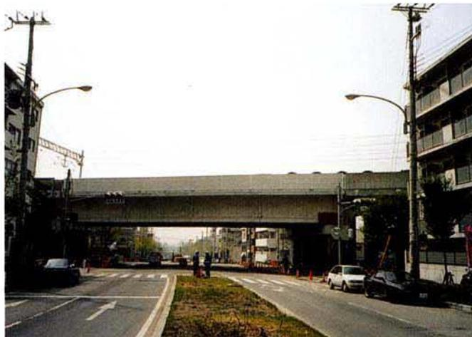
PC桁架設完了
