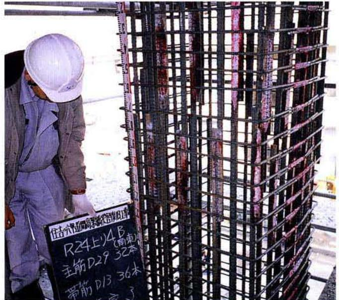
柱鉄筋の組立状況
