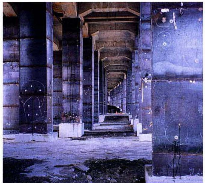
鋼板巻補強完了
