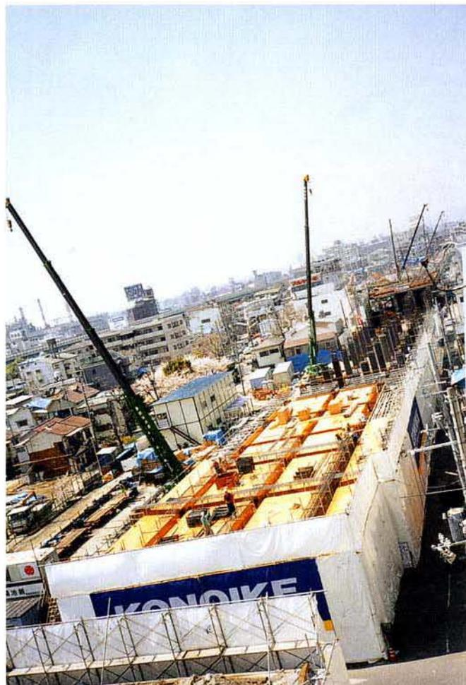
新設高架の鉄筋・型枠組立中
