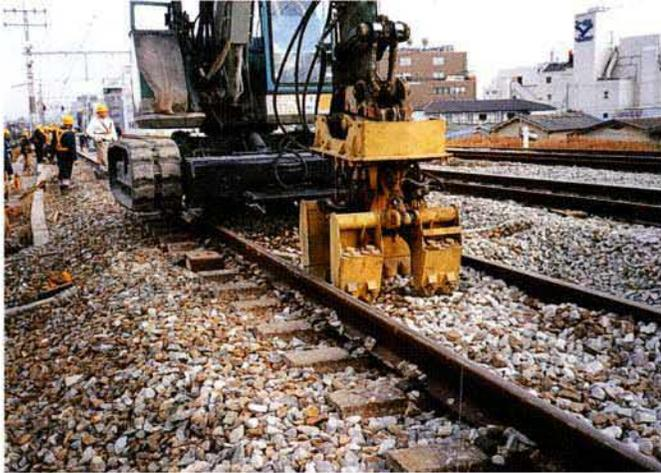
八頭油圧タイタンバーによるつき固め作業
