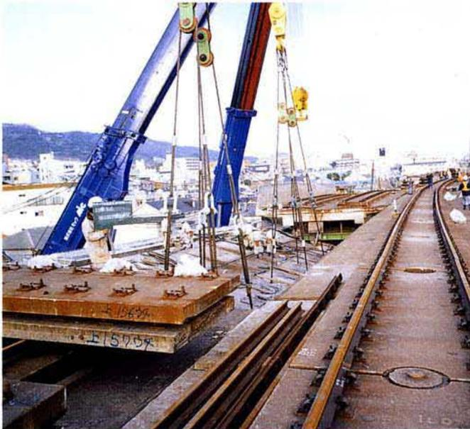
高架橋床版部の吊上げ（クレーン350トン吊）
