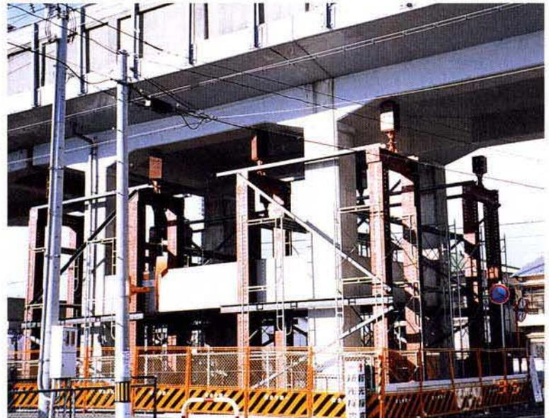
床版部を仮受け 柱の補修中
