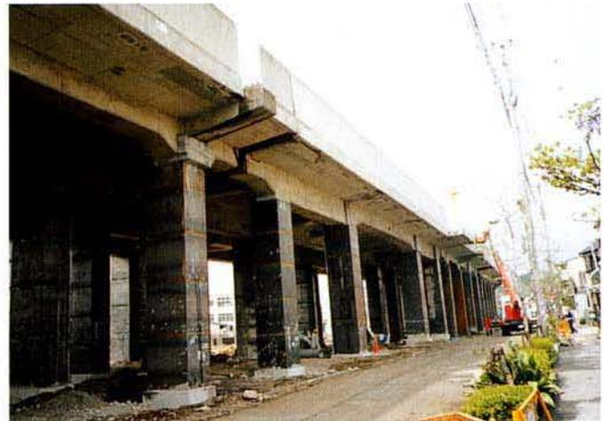
鋼板巻補強完了
