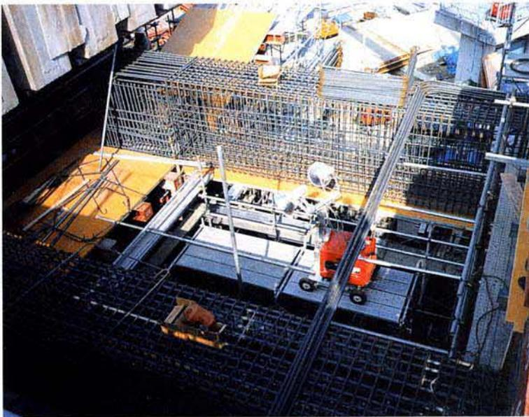
橋台復旧工事中（鉄筋組み）
