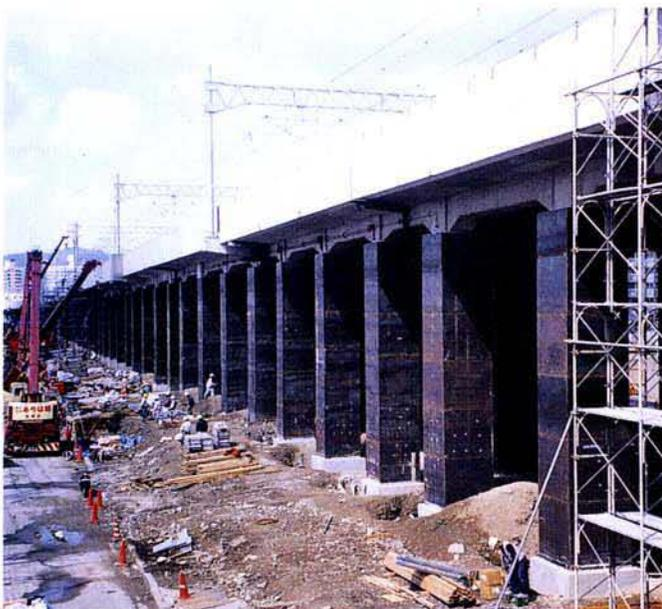
鋼板巻補強完了
