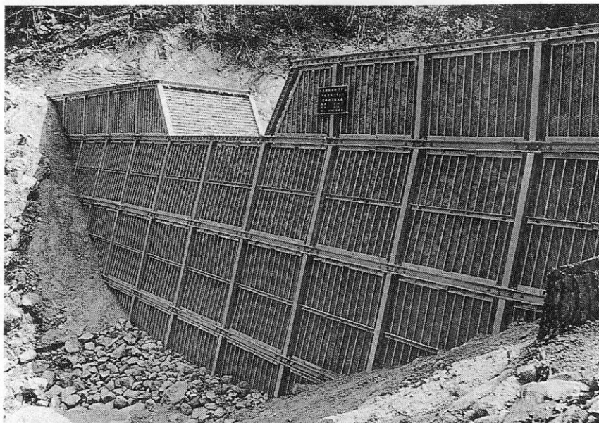
写真-2 鋼製堰堤の状況 8)
