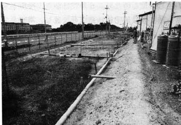
通路排水工事
