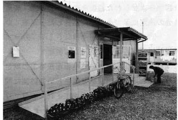
ふれあいセンター （仮設六甲アンランド第6住宅）
