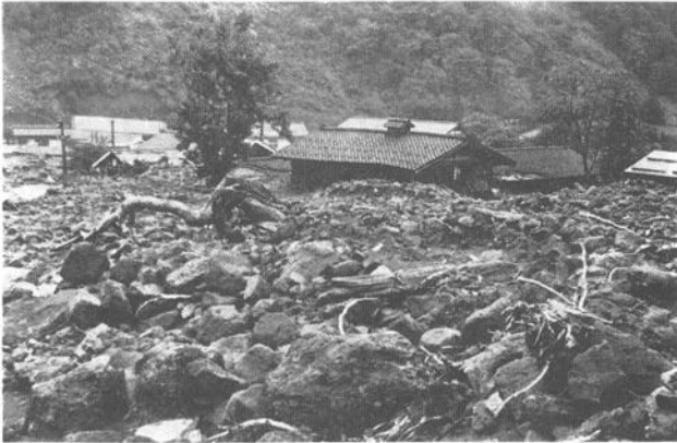
福井県奥越地方の大水害（旧西谷村）
