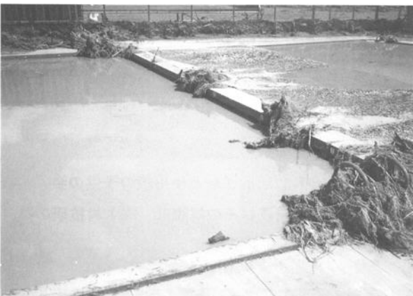
プールにも大水によって運ばれた土砂や流木等が流れ込んでいる。
