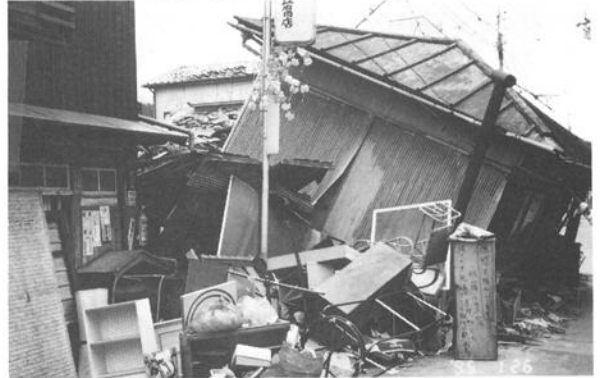
倒壊した民家（神戸市灘区内）
