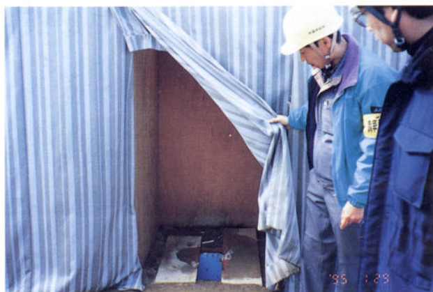
ポリバケツ埋込式仮設トイレ (小黒小学校校庭) (提供：静岡県環境整備事業協同組合)
