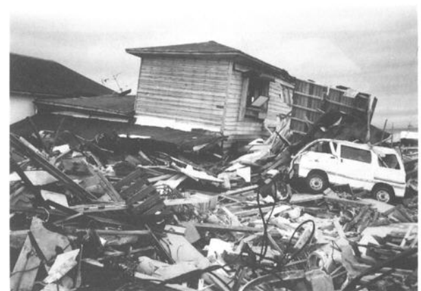
津波の爪痕。火災を免れたがほとんどの家屋が跡形もなく崩れ去っている。
