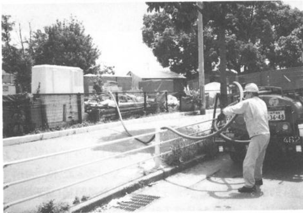
し尿処理作業風景 (提供：神戸市)
