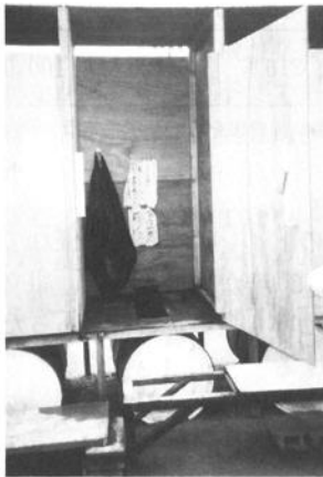
ドラム缶を便槽に手造りしたにわかトイレ (提供：神戸市)
