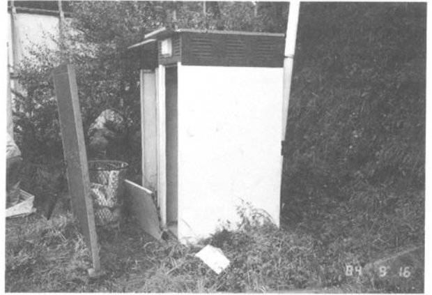
村の既設の汲取式公衆トイレもドアが壊されて使用不能になっている。
