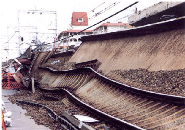
激震で崩落した鉄道線路 (提供：日本曹達株式会社 丸本柳太)
