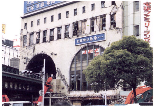
私鉄ステーションビルの崩壊（神戸市中央区三宮） (提供：同左)
