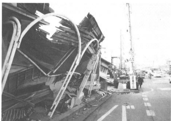
倒壊した民家に押しつぶされたバス停（神戸市長田区）
