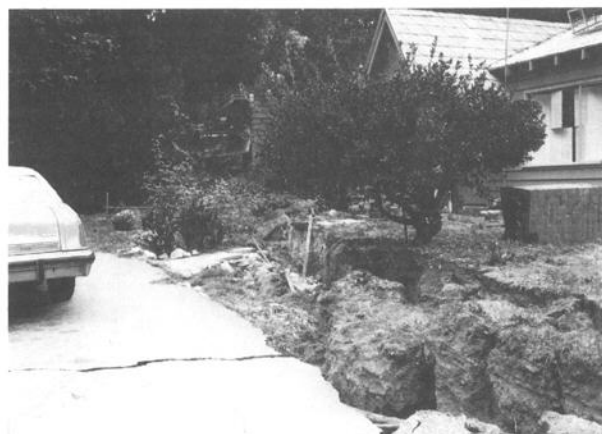
地割れにより大きな亀裂が生じている。家屋と道路の間が人間一人隠れてしまうほどの深さに亀裂して大きく隔たってしまった。
