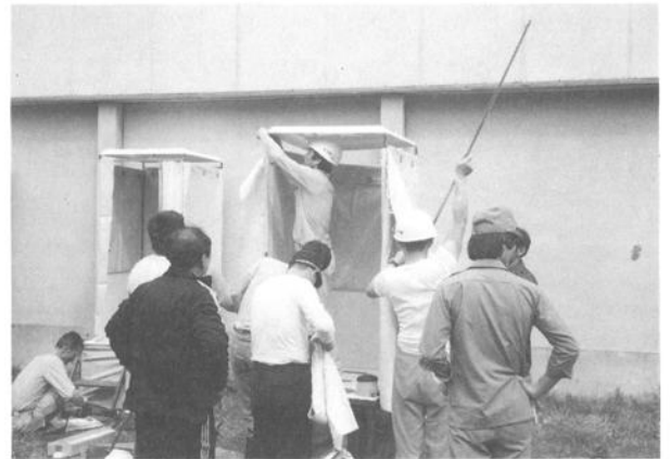
地元の住民や防災担当者による仮設トイレの設置作業風景。
