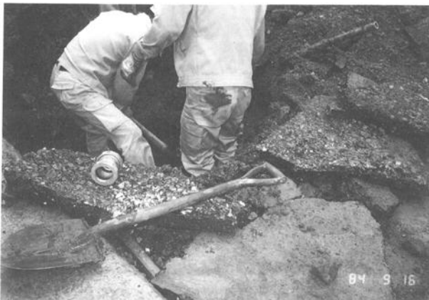
破損した水道管の復旧作業風景。
