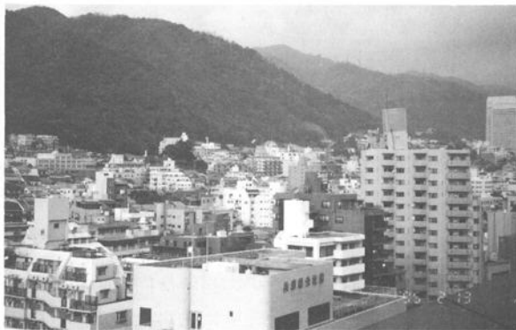
兵庫県庁の裏のマンション街、高架水槽が壊れている（平成7年2月）
