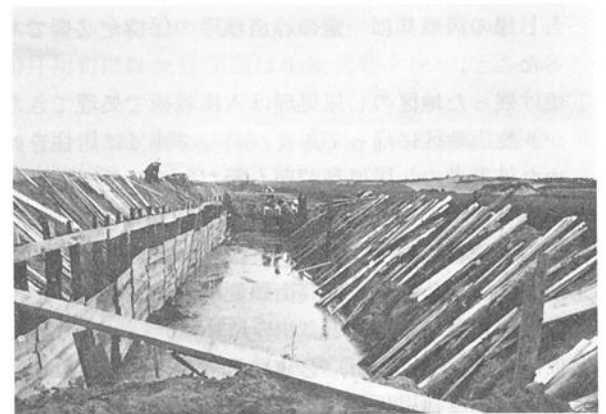
海岸砂丘に急設された簡易貯溜槽 （出典：「新潟地震誌」）
