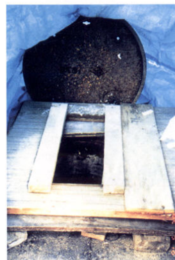
マンホール利用トイレ (提供：神戸国際 トイレトピアの会)
