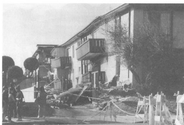
震央近くの木造3階建アパートの崩壊 (16名死亡)。
