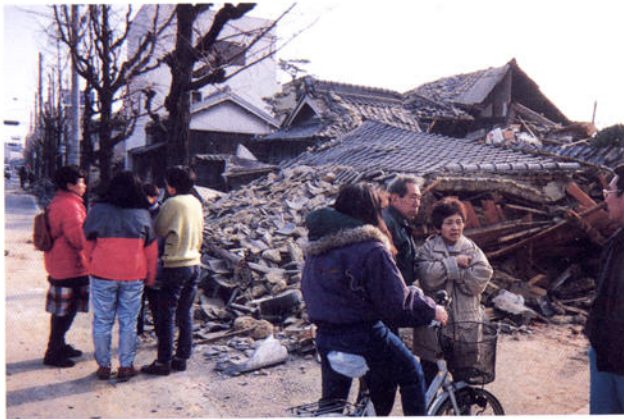
倒壊した民家と未救出者を気遣う近隣の人々 （平成7年1月17日朝） （提供：株優光社 山村武彦）
