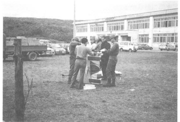
校庭で仮設トイレを組み立てる。
