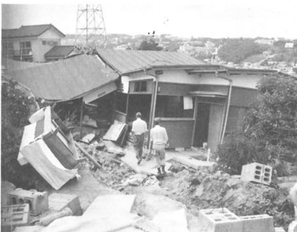
宮城県沖地震による被害
