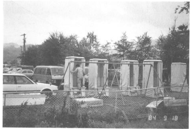
公園での仮設トイレの組立・設営風景。
