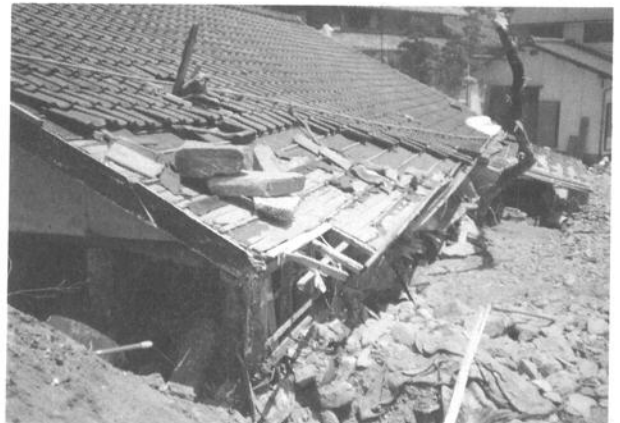
土砂によって倒壊した民家。被害は浸水だけでなく豪雨に伴う山崩れや眼鏡橋の決壊等に及んだ。
