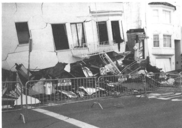
M7.1の烈震により大きく傾いた建物。一階部分は跡形もなく粉碎されている。
