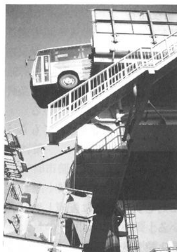
大地震で崩落した高速道路 (提供：日本曹達株 丸本柳太)
