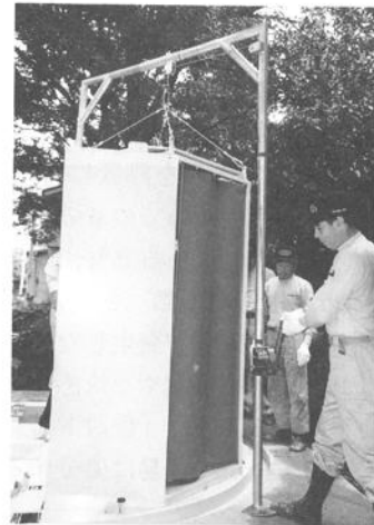
ウインチ引き上げ作業
