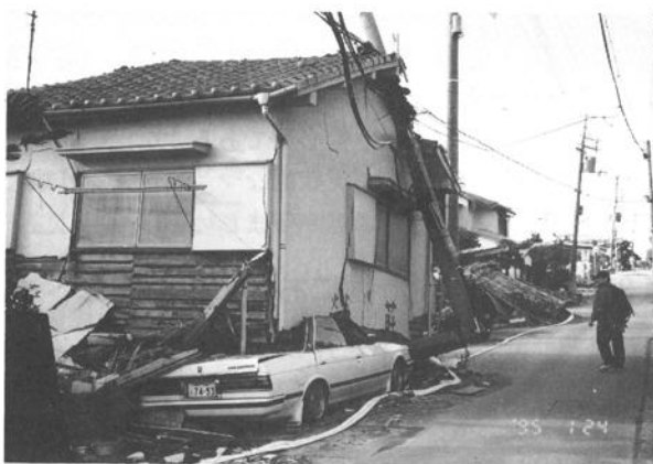
1階が座屈した民家（提供：日本曹達株式会社 丸本柳太）
