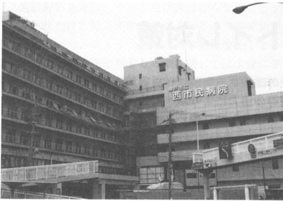
神戸市立西市民病院の座屈 (平成7年1月17日) (提供: 株式会社 山田武彦)
