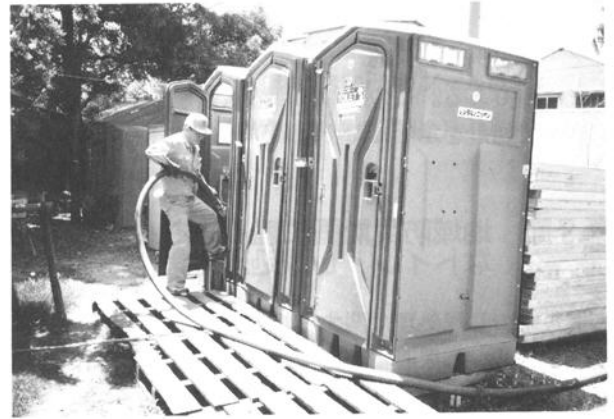
公園の仮設トイレからのし尿汲取り作業(提供：神戸市)
