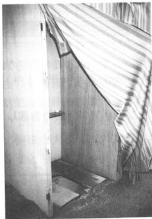
簡易なポリバケツ埋め込みトイレ (提供：神戸国際トイレトピアの会)
