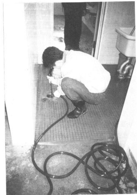
排水管清掃 (提供：同上)
