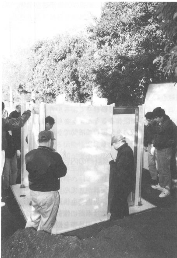
地下埋設型トイレの組立訓練（足立区栗島中学校にて）
