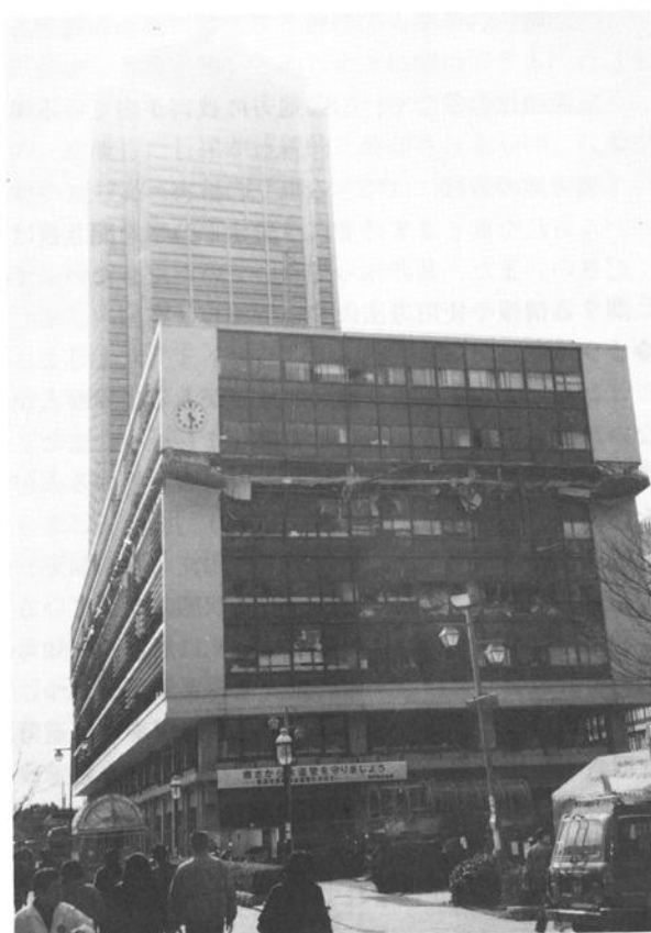
神戸市第2庁舎ビルの座屈
