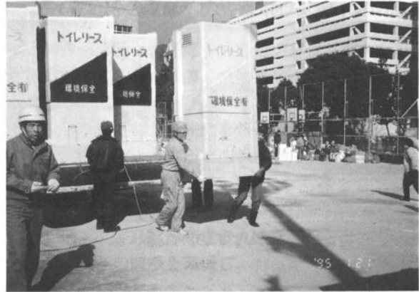
トイレ支援ボランティア団体による仮設トイレの搬入 （提供：静岡県環境整備事業協同組合 片淵弘佳）
