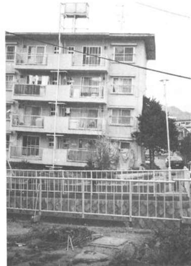
地震で傾いた公営住宅(神戸市西区)
