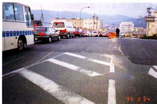
写真4.3.54 橋台背面の仮舗装
