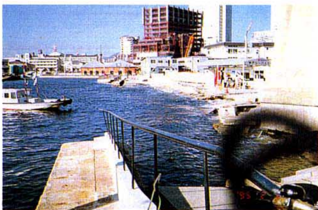
写真5.2.5 ケーソン及び背後エプロンの水没
