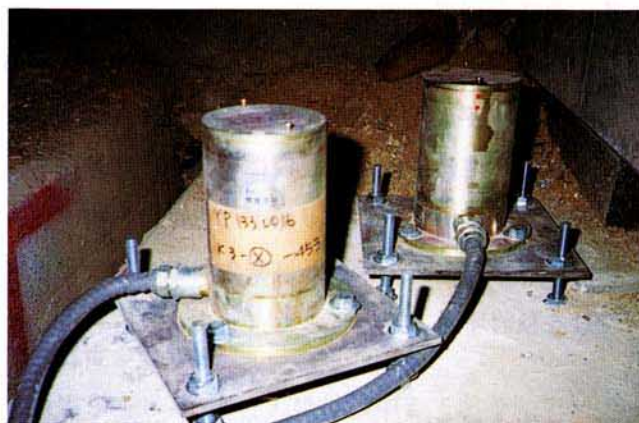
写真4.3.55 橋台に設置した傾斜計
