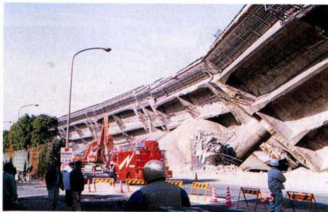
写真4.2.41 ピルツ式PCゲルバー桁橋の転倒
