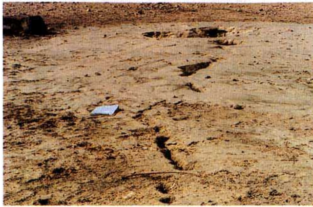
写真2.3.2 山地部河川敷の液状化の拡大写真
