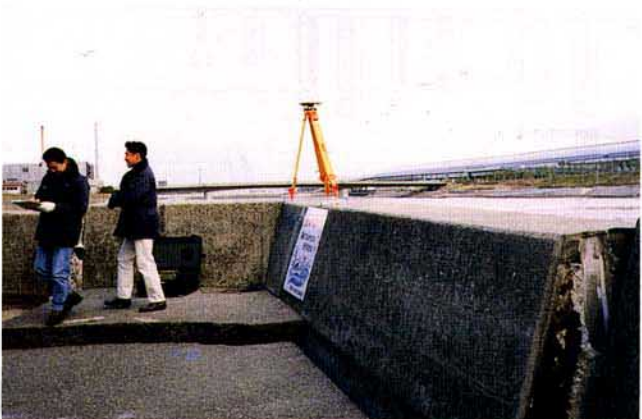
写真4.3.41 GPSによる橋梁全体系の測量
