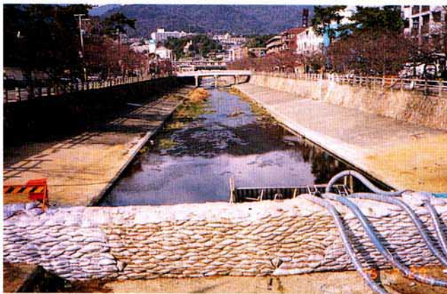
写真4.3.45 上流部に設けた堰
