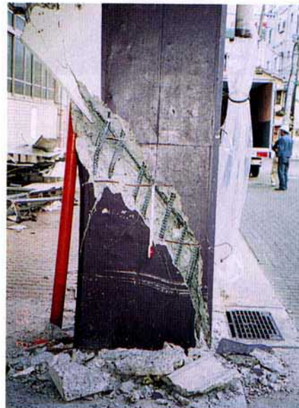
写真3.2.33 落下したラーメン高架橋
