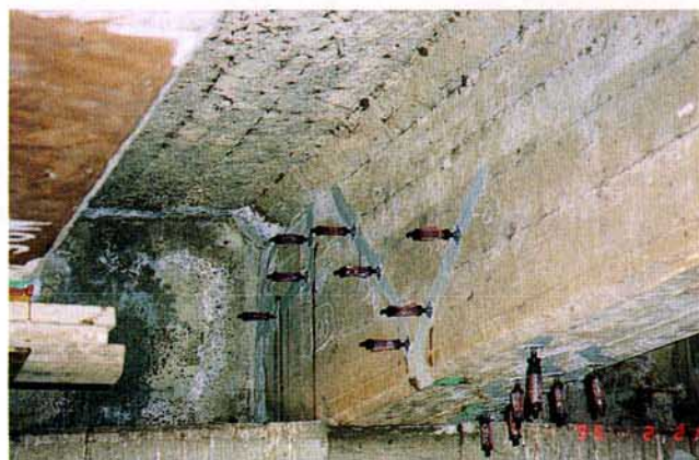
写真4. 3. 14 単径間橋梁の復旧例（中桁端部樹脂注入）
