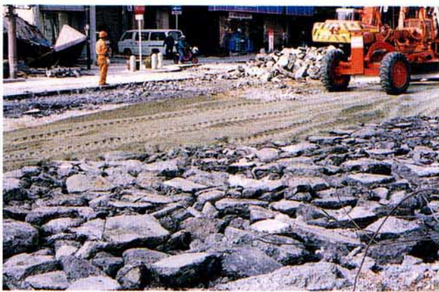
写真4.2.54 同上の復旧工事
