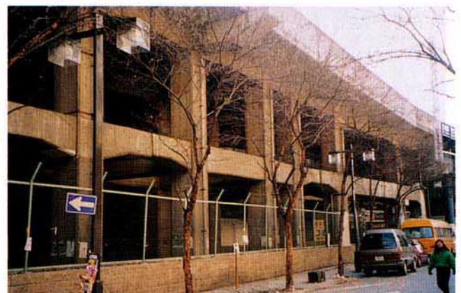
写真3.2.41 神戸高速鉄道 健全な阪急三宮駅構内 ラーメン高架橋
