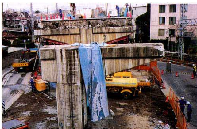
写真4.3.35 撤去工事中の橋脚
