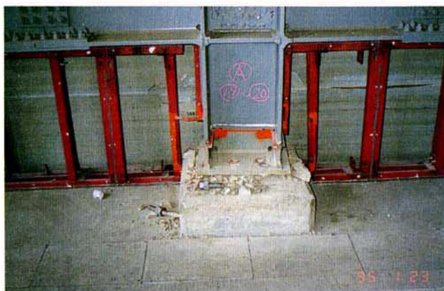
写真3.2.85 H型柱基礎の被害
