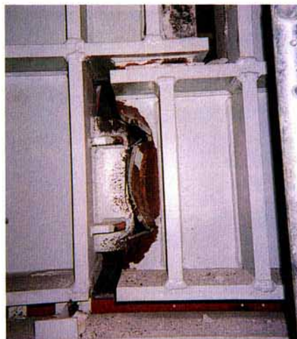
写真3.2.85 H型柱基礎の被害
