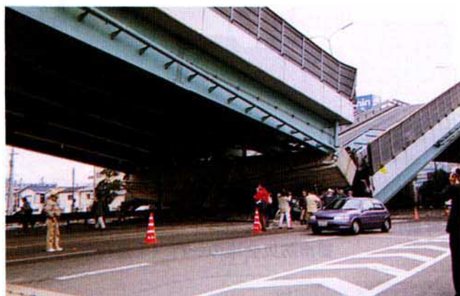
写真1.1.22 阪神高速道路（西宮市今津久寿川町付近）
