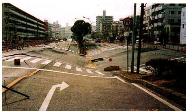
写真3.2.50 大開駅 地表面の道路陥没
