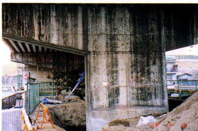
写真4.3.2 同上（橋脚試掘）
