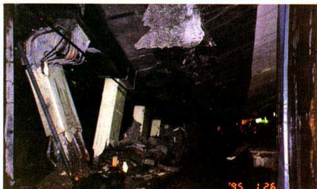
写真3.2.52 同 地下2階中柱の被害
