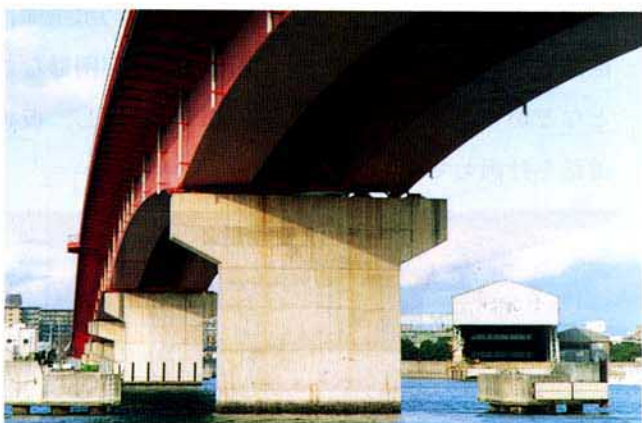
写真4.3.39 P 5 固定橋脚の支承と桁
