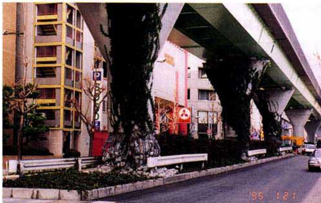
写真3.2.54 震災後の磯上通り 橋脚下端の破壊
