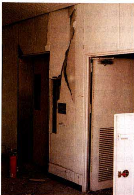
写真3.2.92 妻壁部変形による壁ブレースの破断 および座屈
