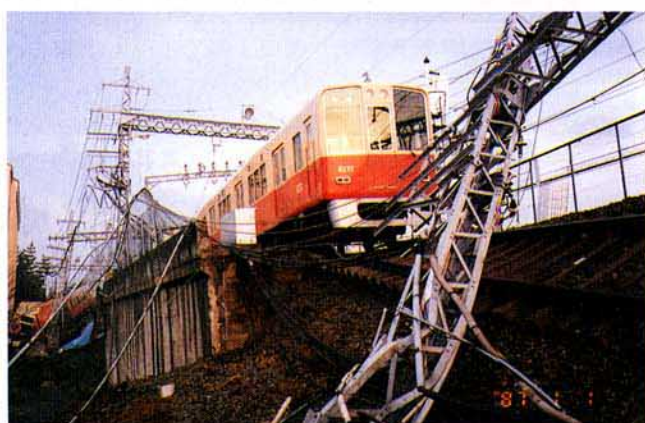
写真3.2.74 擁壁の崩壊
