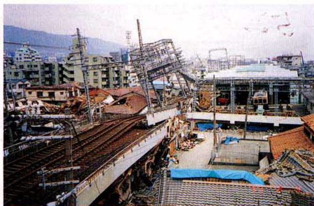
写真3.2.37 車庫 検車場付近の被害
