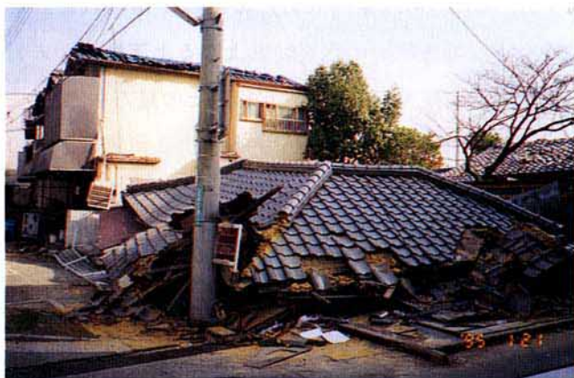
写真1.1.9 全壊し、屋根が地面についた木造民家 (西宮市上田市付近)
