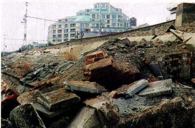
写真3.2.69 法面下部の土留擁壁の転倒と法面ブロックの崩壊
