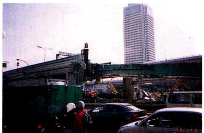
写真4.2.55 阪神高速道路の被害
