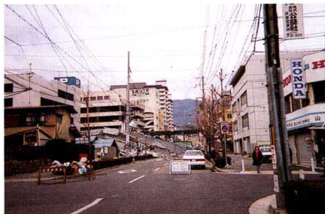
写真1.1.6 駐車ビルが道路上に崩れ落ち，通行止めとなる（JR芦屋駅南側）
