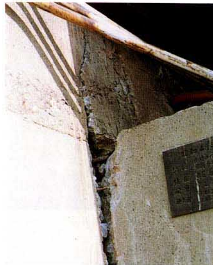
写真4.3.56 桁衝突によるパラペットのコンクリート剝離・鉄筋露出
