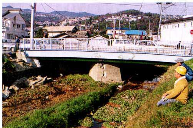
写真4.2.27 橋脚の亀裂
