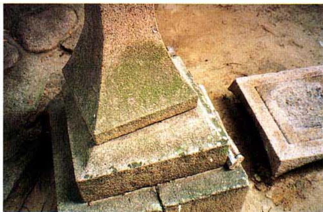
写真2.3.15 台座の回転（反時計回り）
