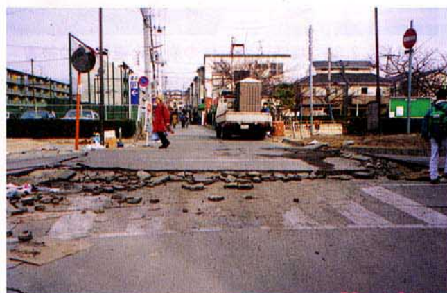
写真4. 2. 31 車道部の段差
