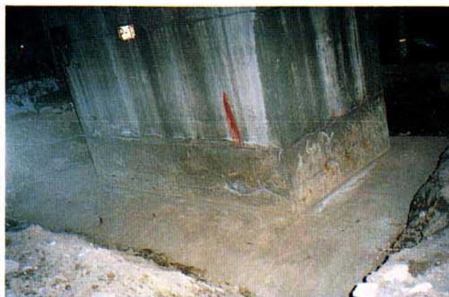
写真4.3.1 高架橋の復旧工事（橋脚試掘）
