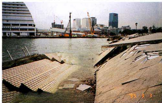
写真1.1.23 海中に没したハーバーランド南側の階段 式護岸
