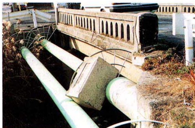
写真4.2.26 親柱破損
