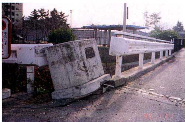
写真4.2.25 親柱の損壊
