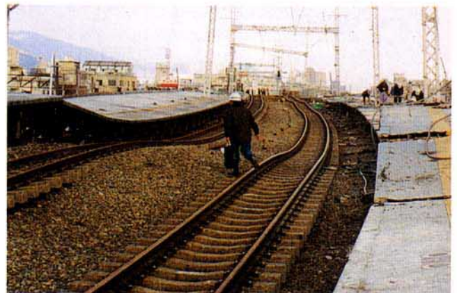
写真3.2.70 JR新長田駅 復旧工事でホーム上家を撤去
