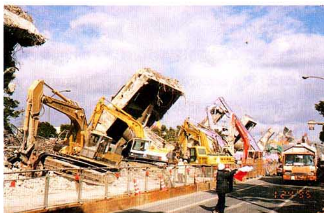
写真4. 3. 24 解体中のピルツ式PCゲルバー桁高架橋
