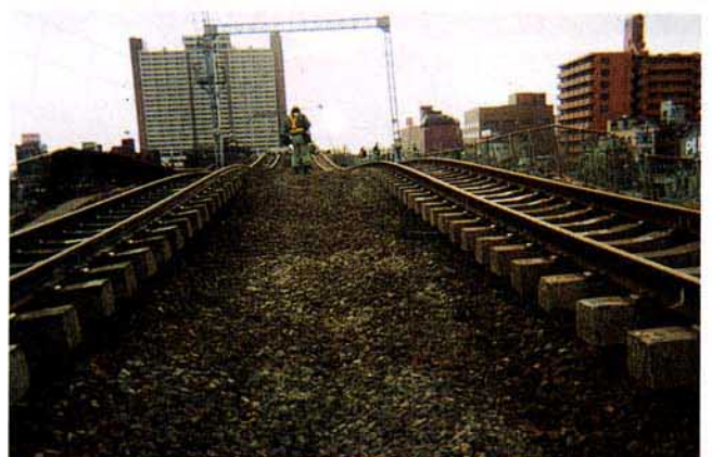
写真3.2.71 ホーム付近の土留擁壁の被害
