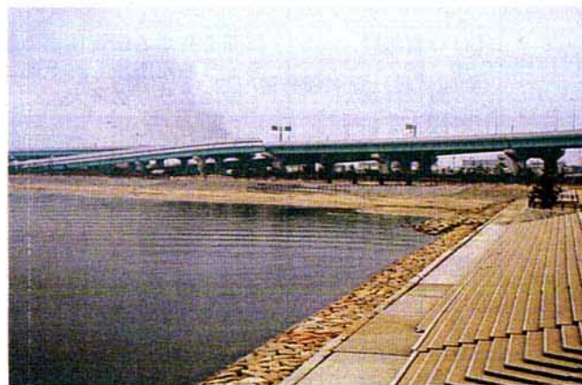
写真5. 2. 13 傾斜護岸の目違いと被害の小さい石積護岸
