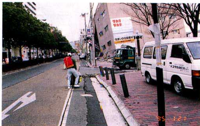
写真4.2.45 平面道路の被害と歩道を塞ぐ倒壊建物
