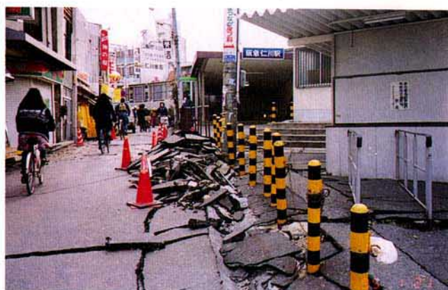
写真4.2.20 歩道部の隆起と撤去されたアスファルト
