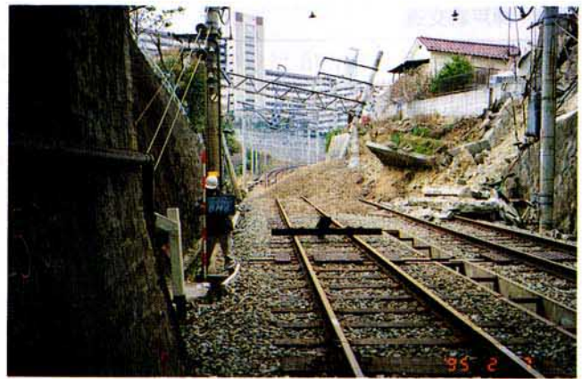
写真3.3.3 神戸電鉄湊川・長田間災害復旧調査
