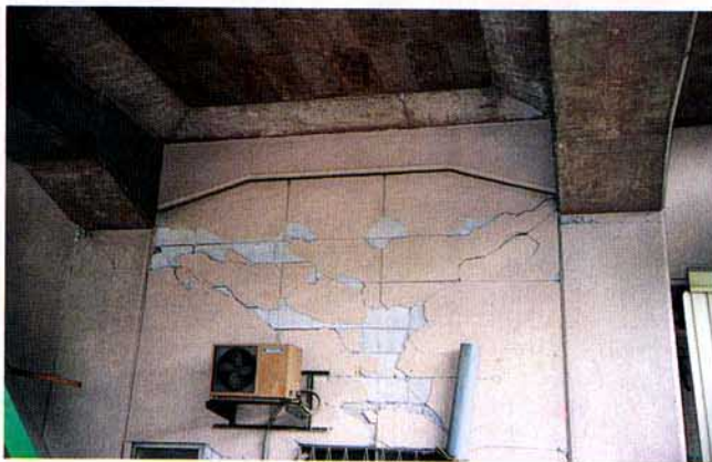
写真3.2.30 壁が設置されているため、被害の軽微な高架橋
