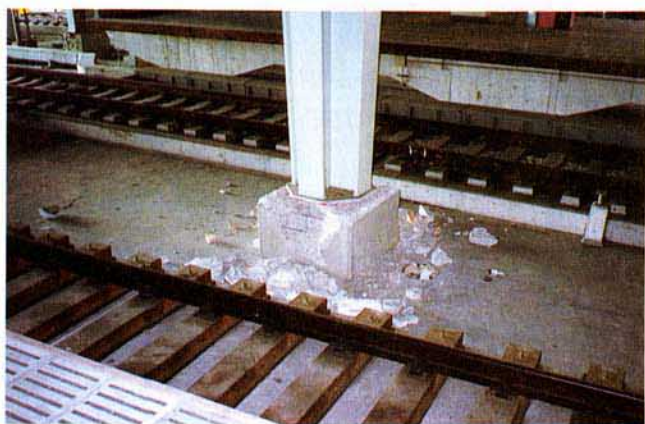
写真3.2.82 基礎の被害
