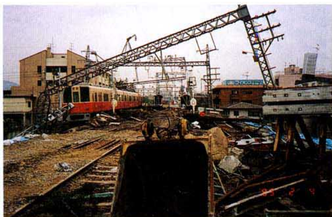
写真3.2.73 阪神電鉄 石屋川駅付近線路内の倒壊
