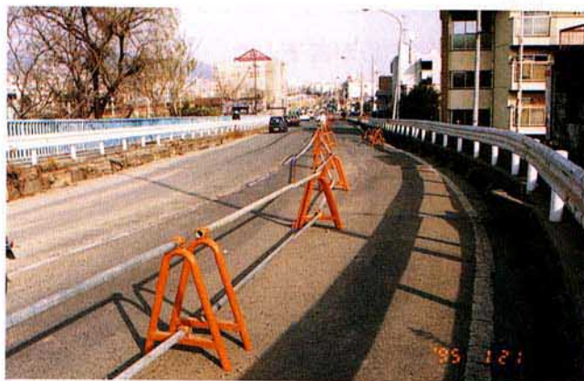
写真4.2.43 平面道路の被害
