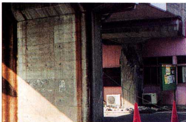
写真3.2.13 健全な壁式橋脚
