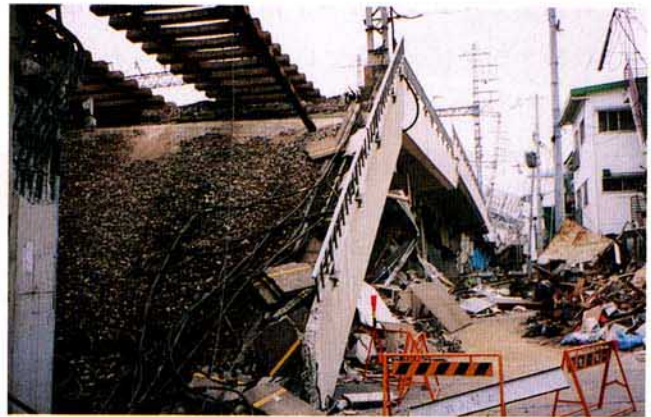
写真3.2.33 落下したラーメン高架橋
