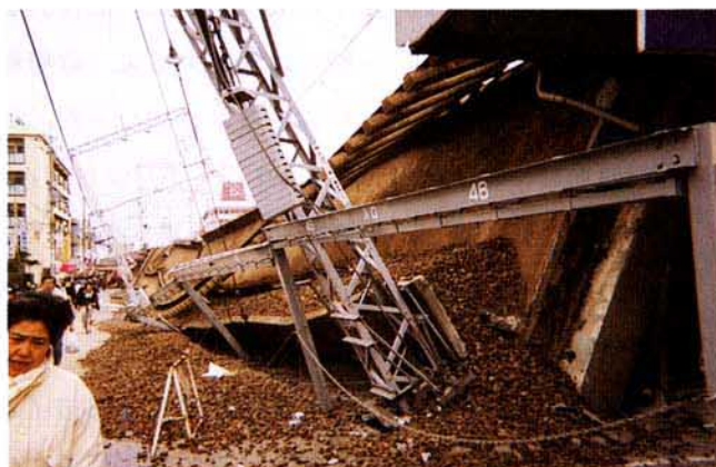
写真1.1.2 横転した阪急電鉄高架橋（西宮北口・夙川間）
