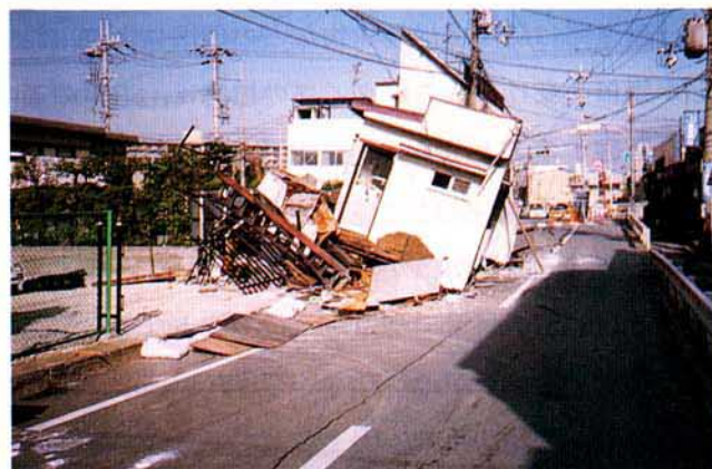
写真4.2.4 歩道上に崩壊した沿道民家
