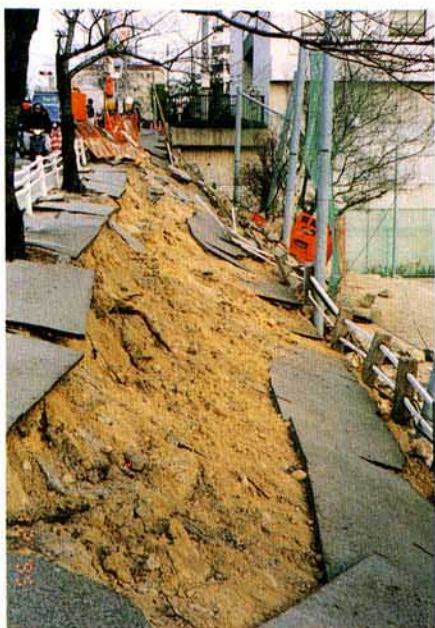
写真4. 2. 29 地盤沈下による 地すべり
