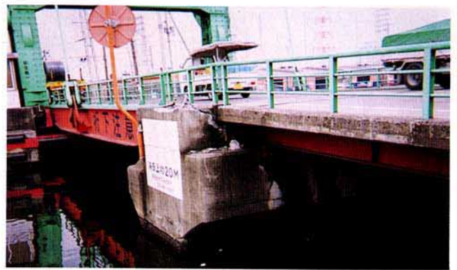
写真4.3.56 桁衝突によるパラペットのコンクリート剝離・鉄筋露出
