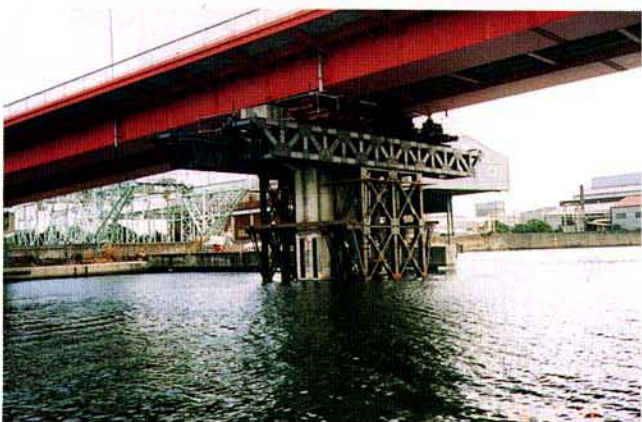
写真4.3.40 P 3 可動橋脚の仮設ペント
