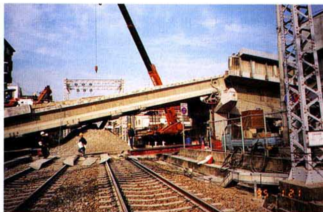
写真1.1.19 阪急今津線上に落下した山陽新幹線
