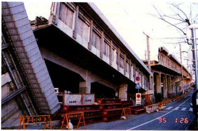
写真3.3.1 六甲トンネル付近高架橋水準測量
