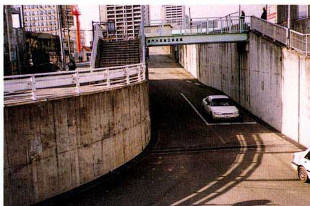
写真4.2.15 健全なアンダーパス
