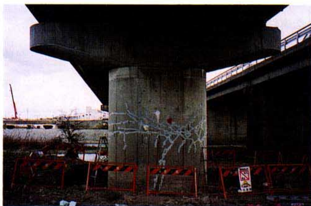
写真4.3.3 同上（樹脂注入）
