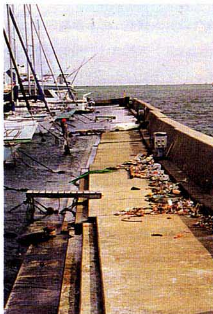
写真5.2.6 ケーソンの沈下，滑動に伴うズレ
