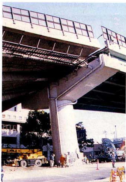
写真4.2.41 ピルツ式PCゲルバー桁橋の転倒
