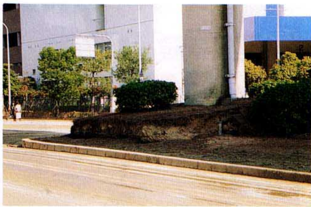
写真4.2.52 ポートアイランド内の道路
