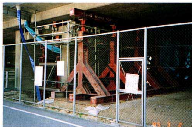
写真4.3.36 応急復旧状況
