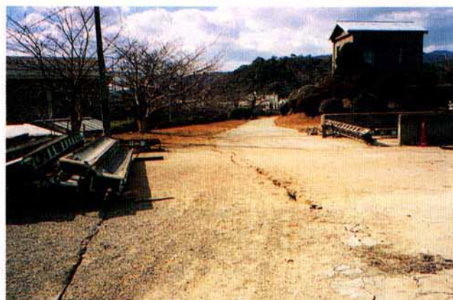
写真2.3.8 活断層に沿う亀裂
