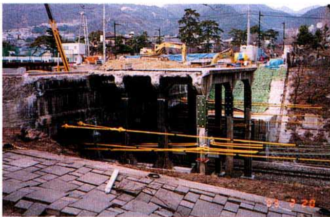
写真4.3.46 撤去された道路部
