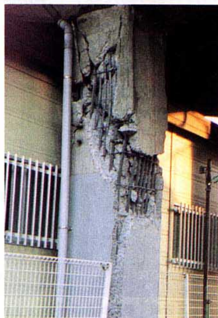
写真3.2.18 せん断破壊
