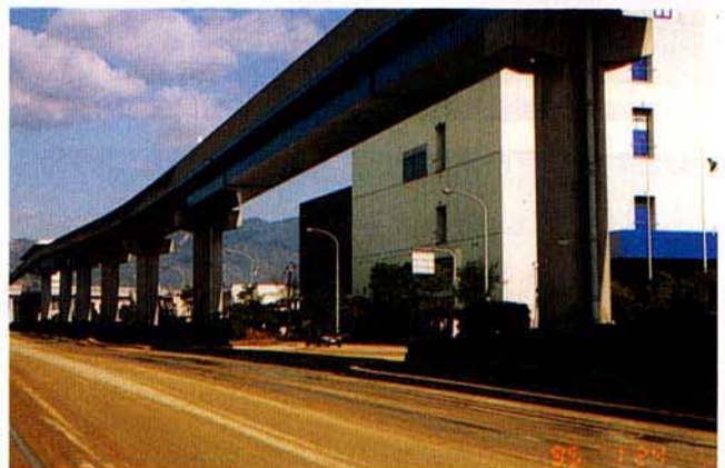
写真4.2.51 ポートアイランド内の道路
