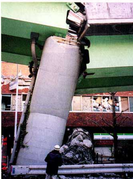
写真3.2.54 震災後の磯上通り 橋脚下端の破壊
