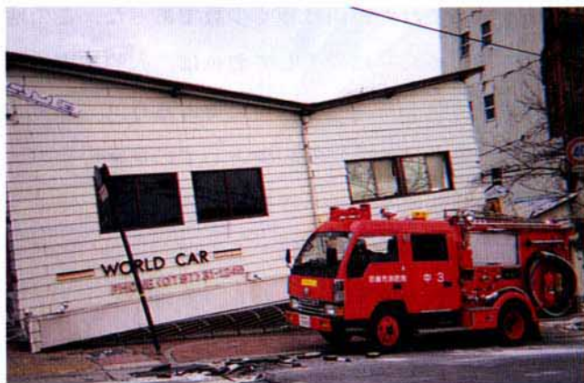
写真1.1.11 1階駐車場部が全壊した木造商店
