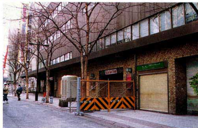
写真3.2.20 三宮駅 健全な西館ビル
