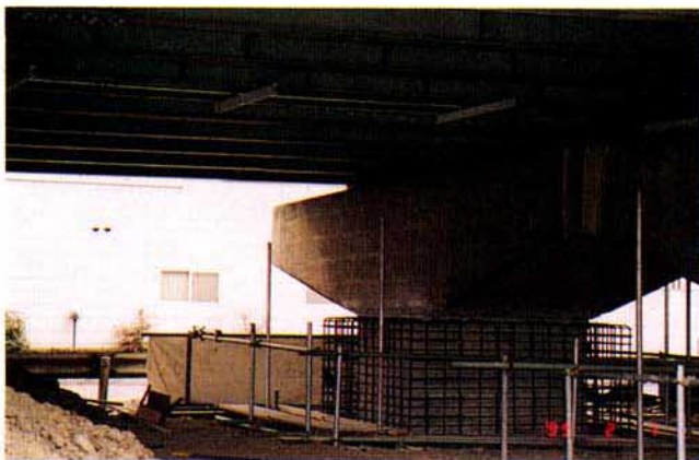
写真4.3.4 同上（コンクリート増厚）
