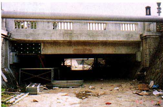
写真4.3.10 単径間橋梁の復旧例（桁端部鋼板接着）
