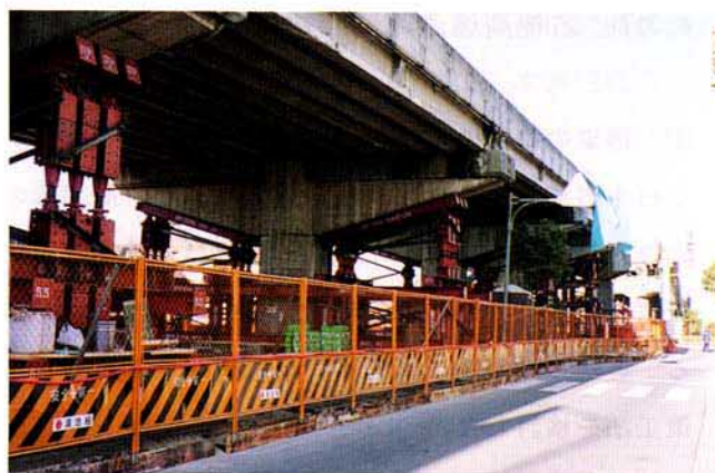
写真4.3.34 支保工の設置状況
