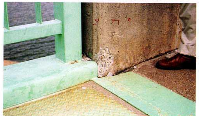
写真4.3.59 側径間と中央径間の衝突
