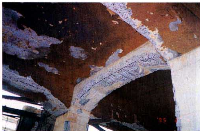
写真3.2.36 同上 スラブ部
