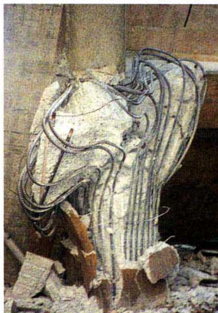
写真3.2.19 支柱の破壊
