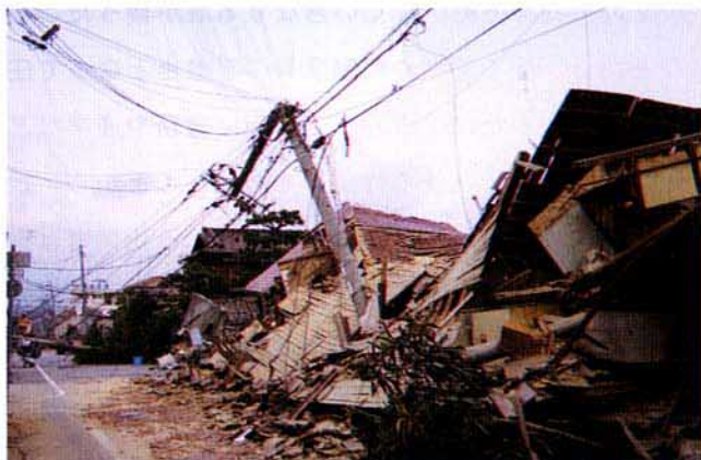
写真1.1.10 木造民家が倒壊し、電柱も破損 (西宮市昭和町付近)
