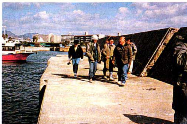
写真5.2.6 ケーソンの沈下，滑動に伴うズレ
