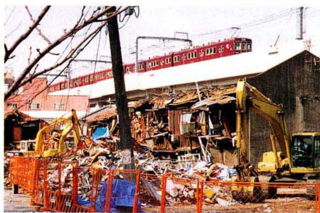
写真3.1.1 全・半壊した住宅と健全な高架橋
