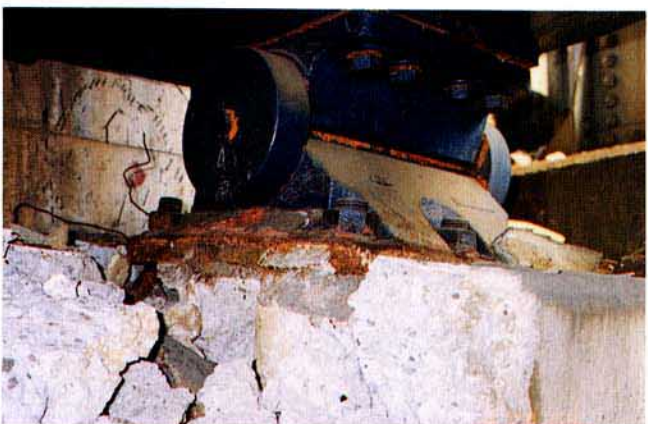
写真3.2.45 しゅう座面の被害
