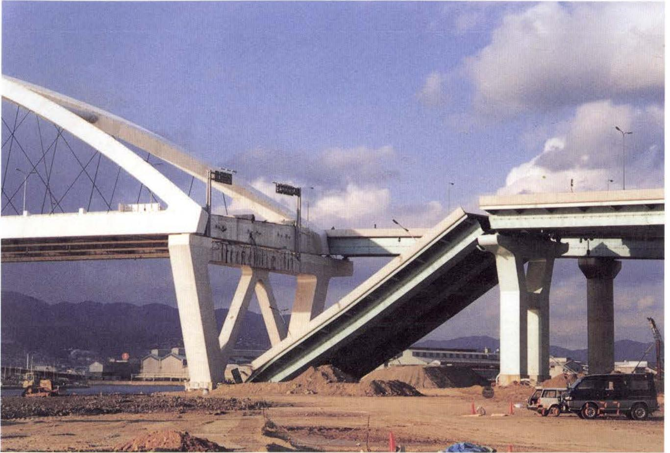
落橋した阪神高速5号湾岸線 西宮港大橋隣接鋼箱桁=西宮市内
