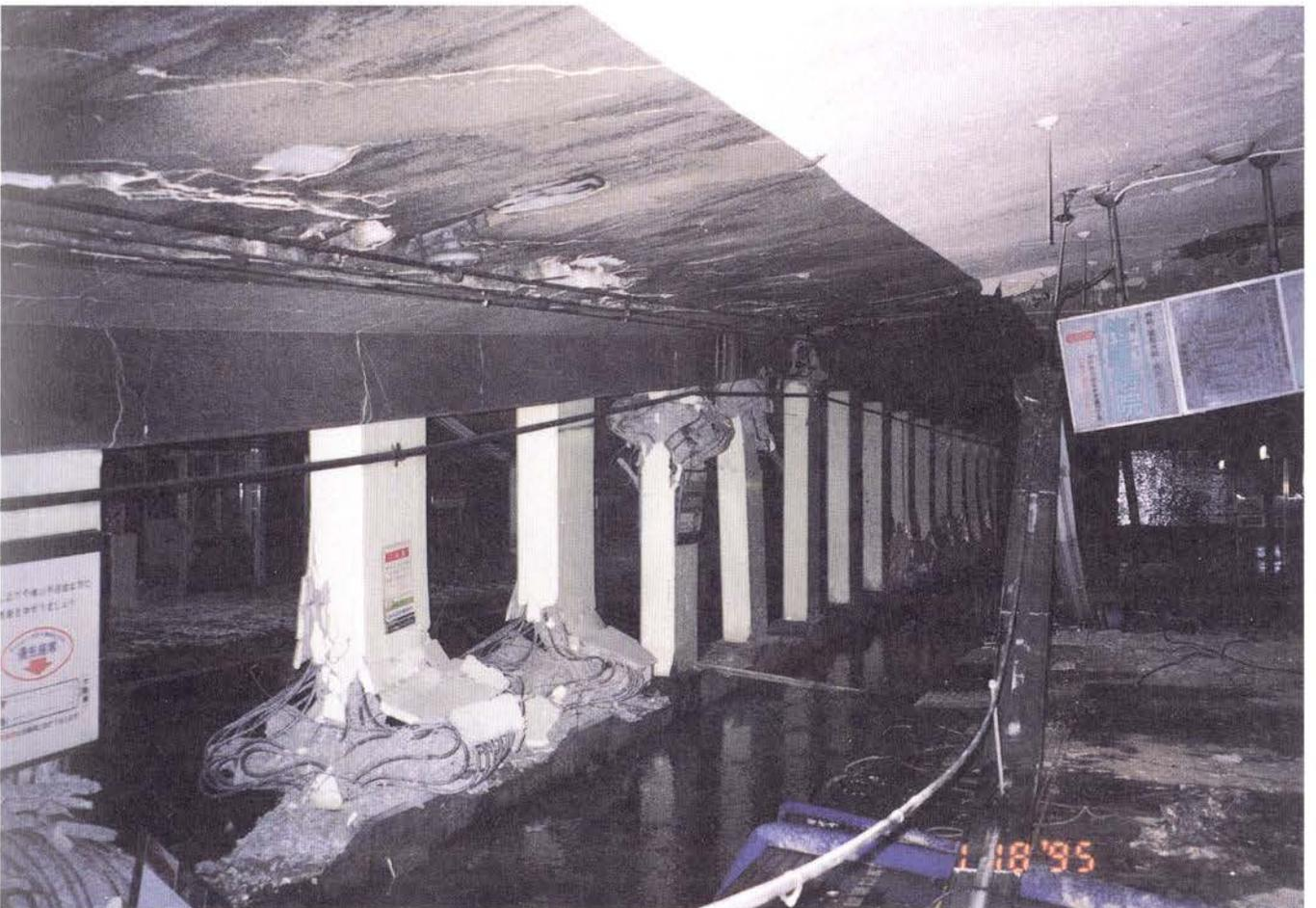
地下の神戸高速大開駅では、開削トンネルの中柱が座屈した＝神戸市兵庫区
