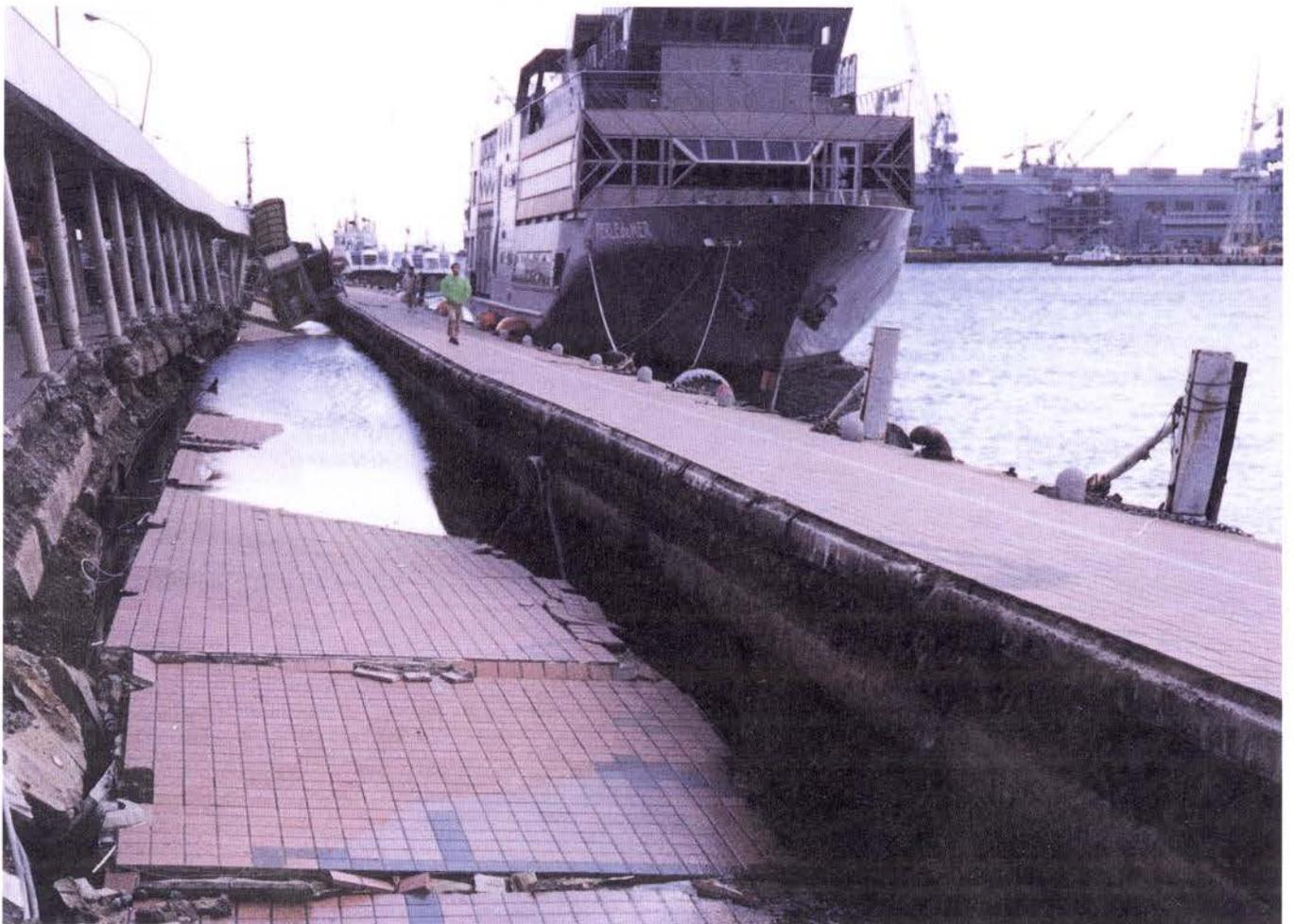
神戸港中突堤では船着き場が陥没し、水没した＝神戸市中央区
