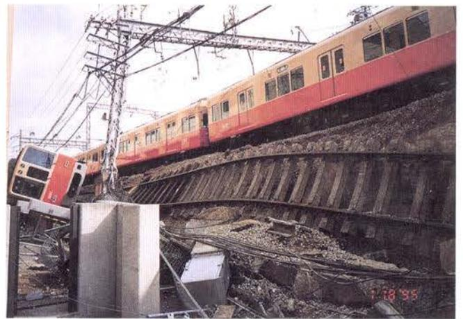
路盤が崩壊し、横転した列車＝阪神電気鉄道御影留置線
