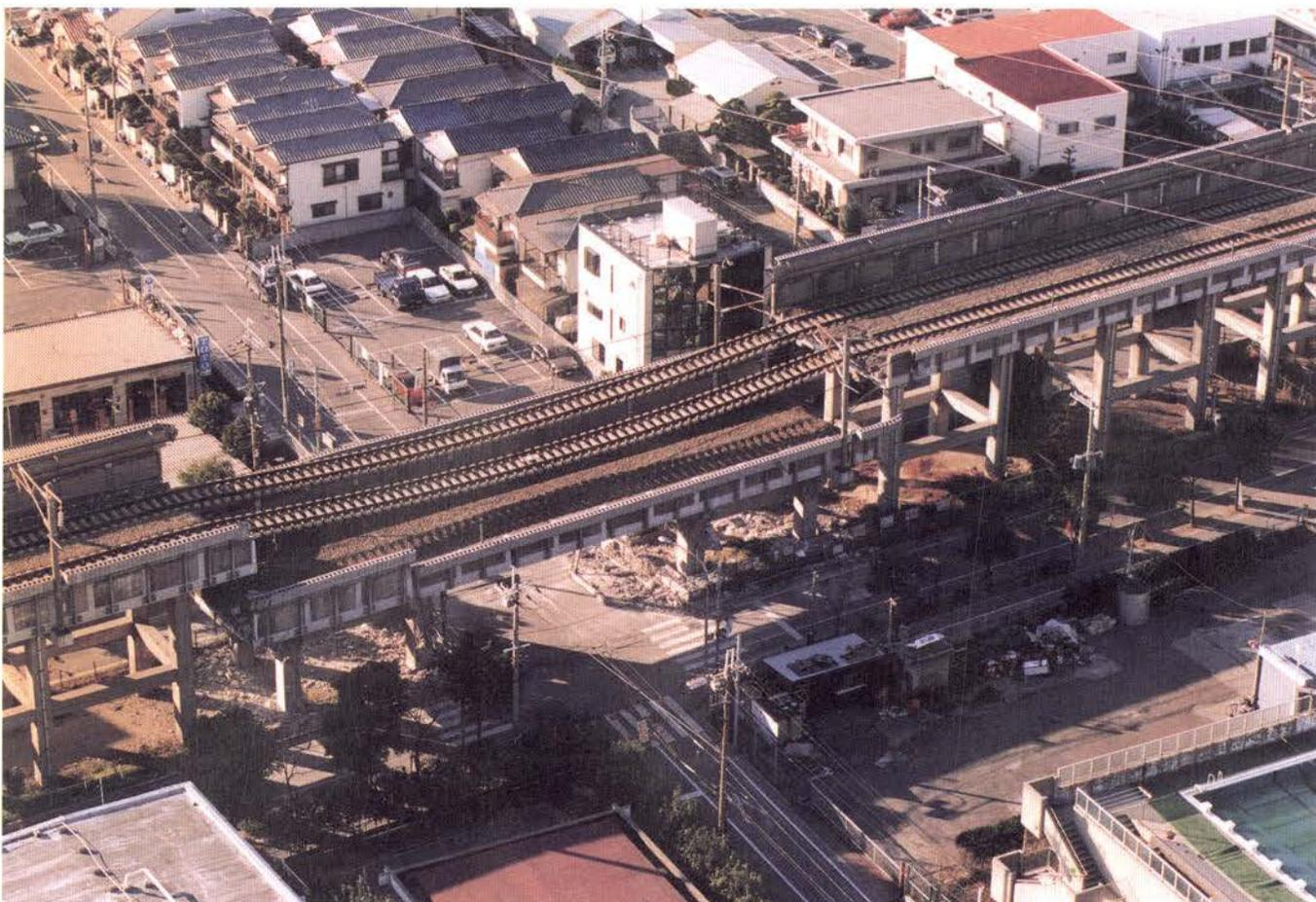
ラーメン高架橋の破壊により、線路がぶら下がっている山陽新幹線＝尼崎市内
