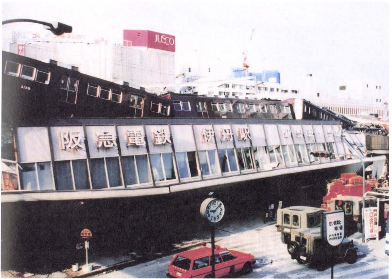
大きく崩れ落ちた駅舎と脱線した電車＝阪急電鉄伊丹駅
