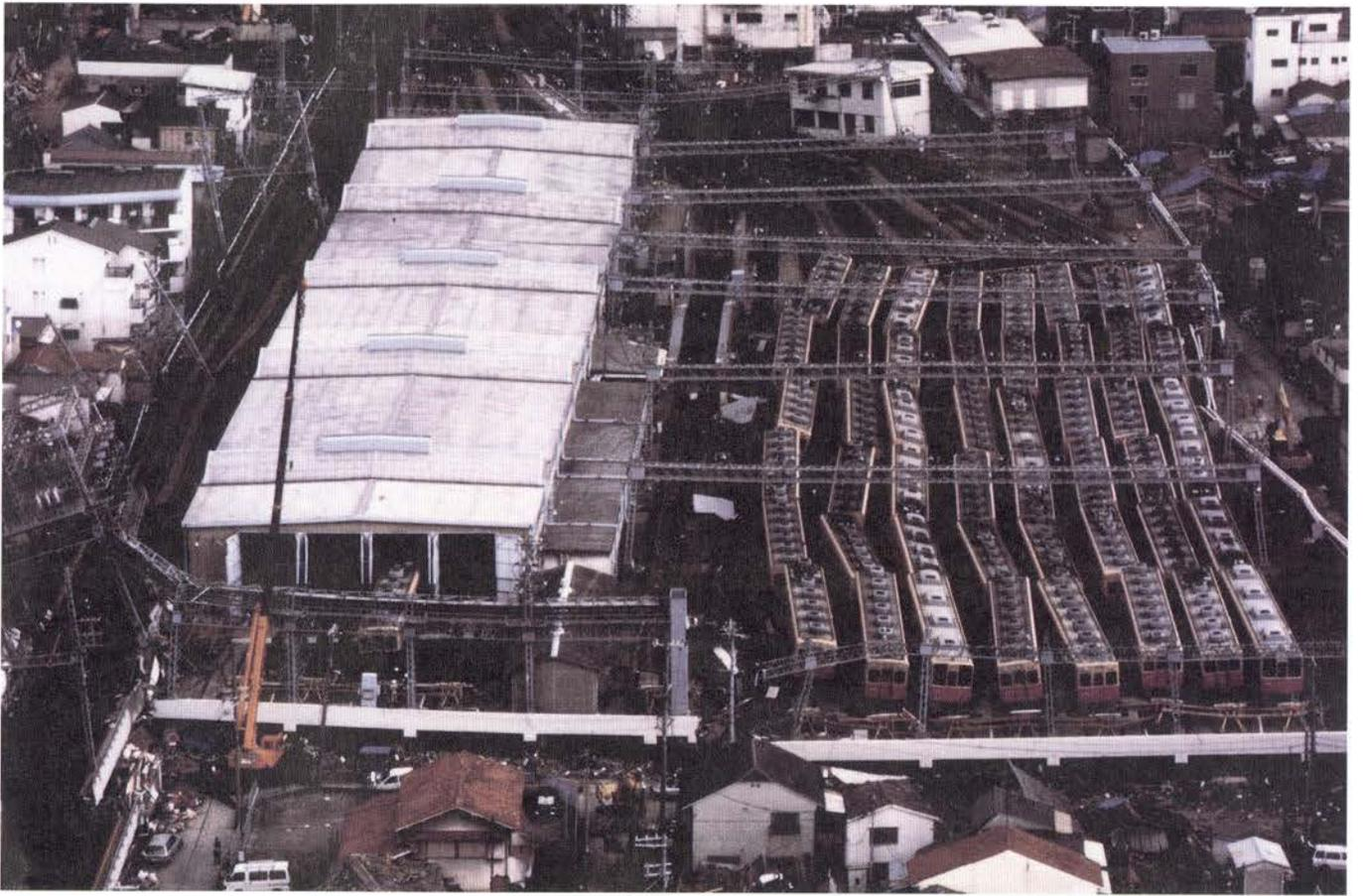
高架車庫が圧壊し、脱線・破損した車両＝阪神電気鉄道 石屋川車庫
