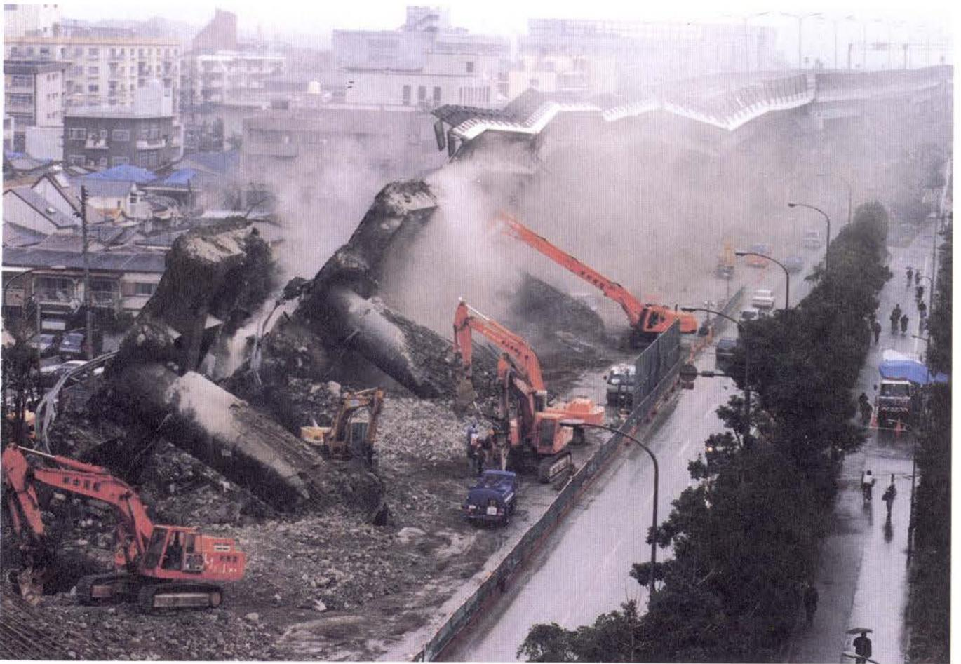
急ピッチで進められる倒壊した高架道路の撤去＝阪神高速3号神戸線（1月23日）
