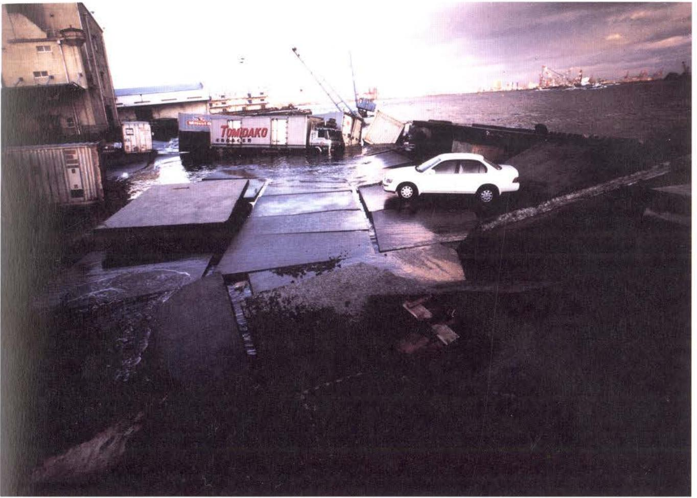
岸壁が崩壊し、海水に飲み込まれる神戸港 = 神戸市中央区小野浜町第5突堤
