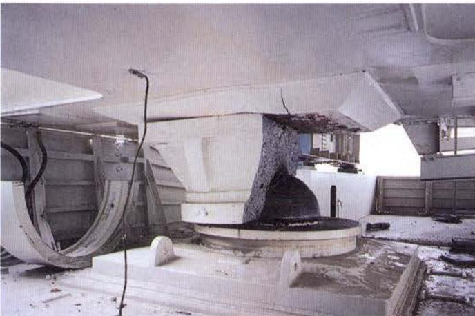
鉛直方向に破断された固定支承の上咨
