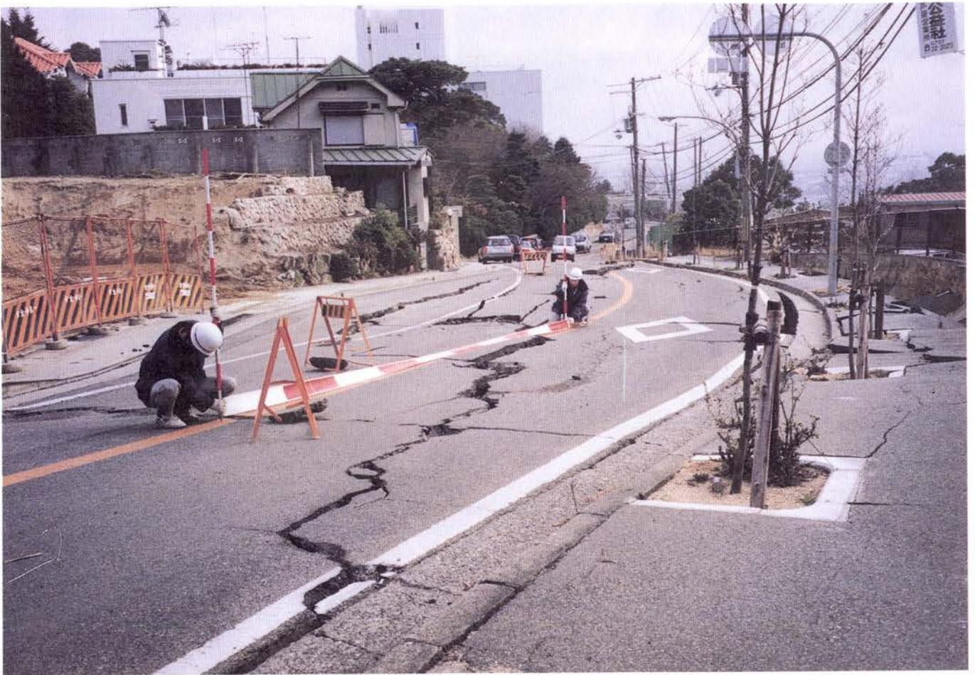
一般道路でも多数の箇所では路面に亀裂・段差等が生じた＝(一)奥山精道線（芦屋市内）
