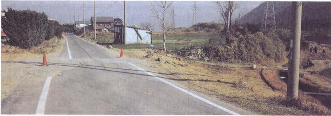
写真-I.4.1 断層運動（右横ずれ）によってずれた道路（淡路島北淡町）
