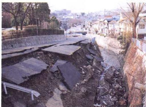
写真-Ⅱ. 2. 42 護岸の倒壊による河川の閉そく
