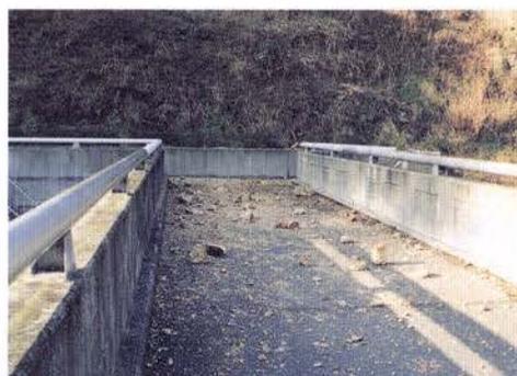
写真-II.2.77 右岸天端への落石
