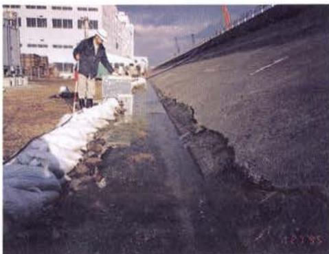
写真-Ⅱ. 2. 40 川裏法尻漏水状況 (中島川)
