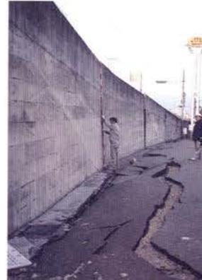
写真-Ⅱ.2.4 盛土部擁壁の側方移動・不等沈下
