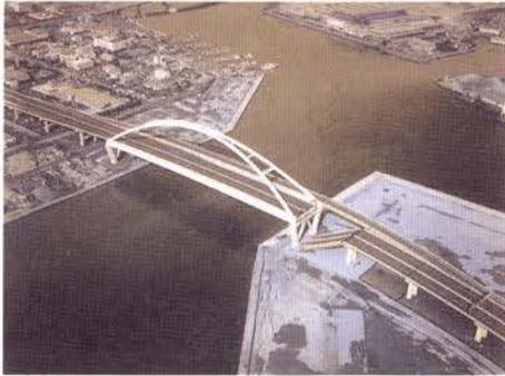
写真-Ⅱ. 2. 30 西宮港大橋隣接桁の落橋
