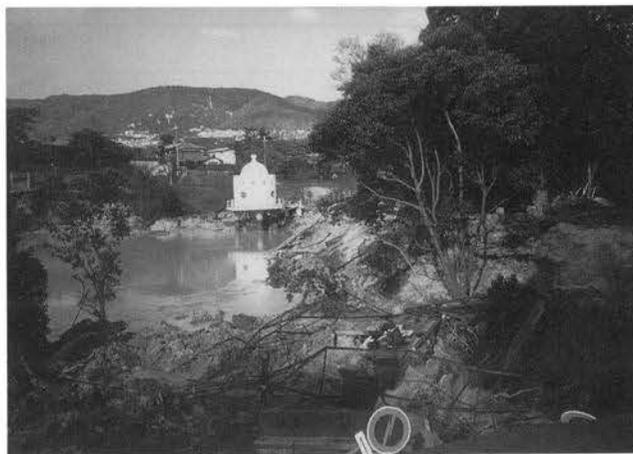
写真-Ⅱ.3.5 西宮市ニテコ池貯水池(中池)堤体の崩壊
