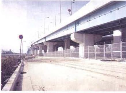
写真-Ⅱ.2.1 液状化による噴砂の堆積
