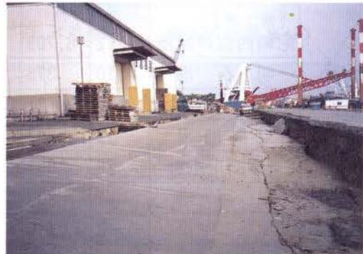
写真-Ⅱ. 2. 57 ケーソンの沈下、滑動による
