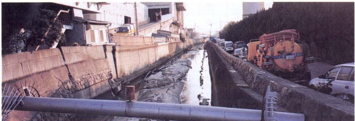
写真-Ⅱ.2.47 六湛寺川雨水幹線の側壁破損、河床隆起（西宮市公共下水道）
