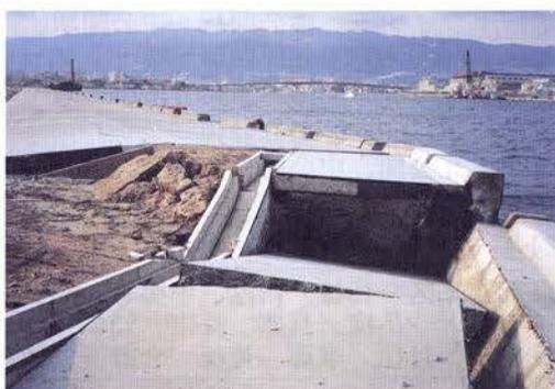
写真-Ⅱ. 2. 62 前面ブロックの傾斜による
