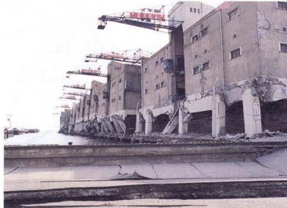
写真-Ⅱ.2.68 新港第8突堤西側の被災状況
