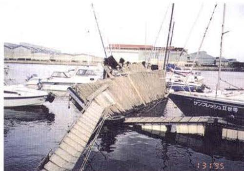
写真-Ⅱ. 2. 61 杭、係留船舶との衝突による
