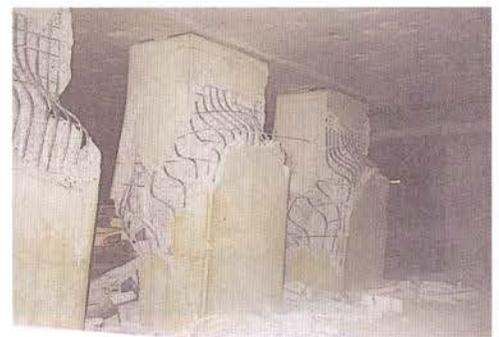
写真-Ⅱ.2.23 固定橋脚の損傷
