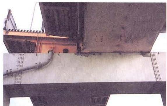
写真－Ⅱ. 2. 19 主桁の横方向移動
