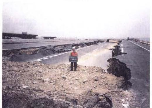
写真-Ⅱ. 2. 72 前面ゲソン沈下による背後エプロンの陥没（六甲アイランド）
