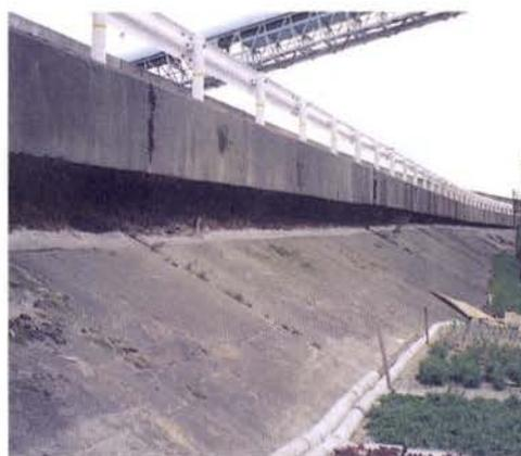
写真-Ⅱ. 2. 41 堤体沈下状況 (中島川)
