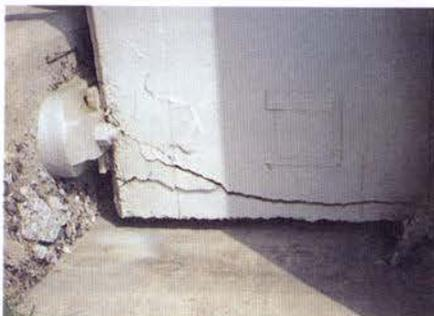
写真-Ⅱ. 2. 15 桁端部のクラック
