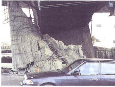
写真-Ⅱ. 2. 28 梁と柱の付根からの崩壊
