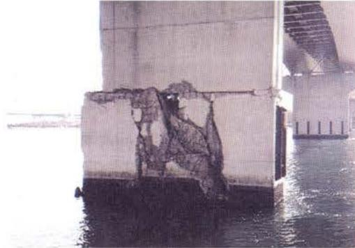
写真-Ⅱ. 2. 55 強い水平力によるせん断破壊
