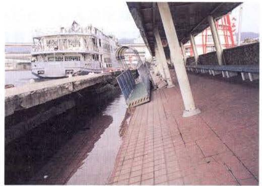
写真-Ⅱ. 2. 70 中突堤旅客ターミナルの被災状況
