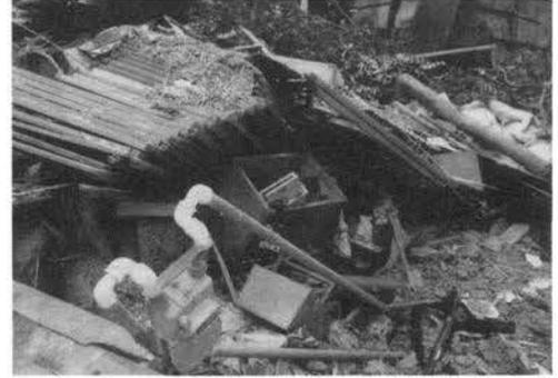
写真-II.3.4 ガス導管の被害
