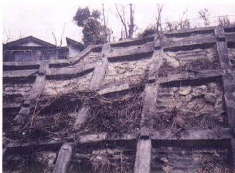
写真-Ⅱ.2.48 法枠の亀裂
