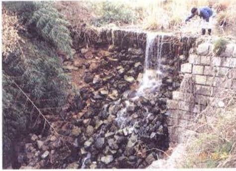
写真-Ⅱ.2.50 石積み堰堤の崩壊
