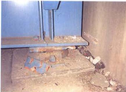
写真-Ⅱ. 2. 11 橋脚上部支承の破損
