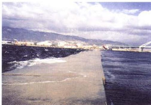
写真-Ⅱ. 2. 60 ケーソンの沈下による水没
