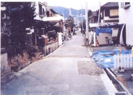
写真-Ⅱ.2.7 路面の亀裂及び側溝の屈曲
