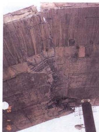
写真-Ⅱ.2.25 中空床版の損傷
