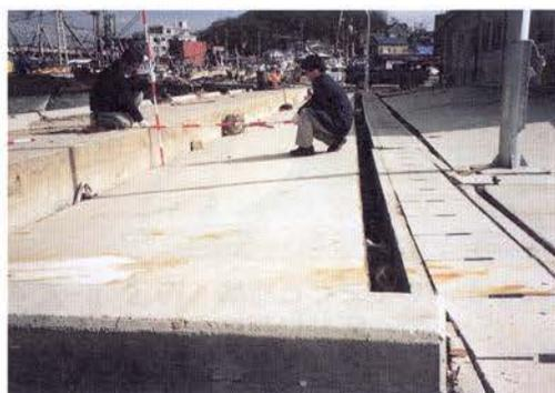
写真-Ⅱ. 2. 65 背後エプロンの沈下
