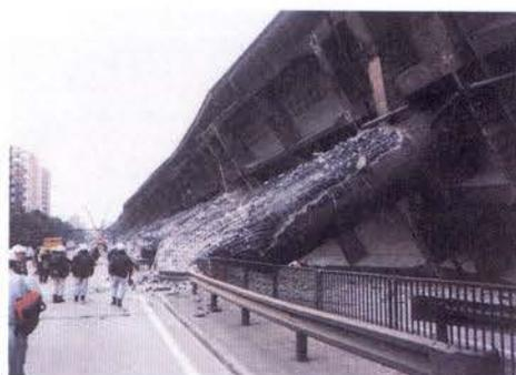
写真-Ⅱ.2.27 ピルツ橋の倒壊
