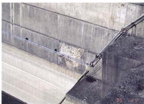
写真-II.2.76 上流面補修モルタルの剥離
