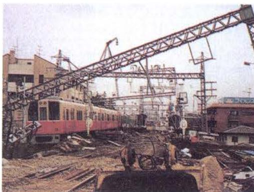
写真-II.2.73 線路内倒壊状況
