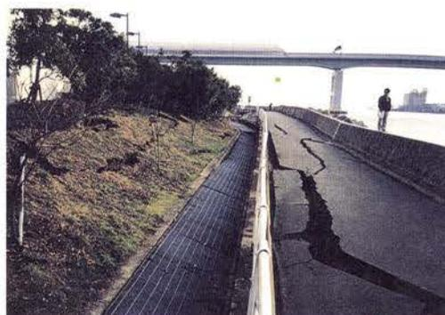
写真-Ⅱ. 2. 63 護岸本体の沈下
