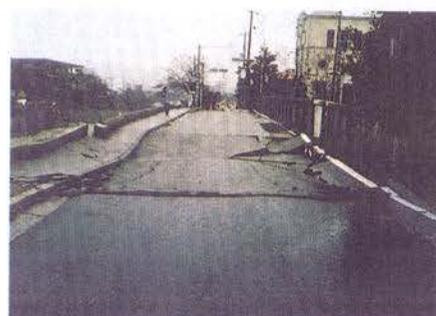
写真-Ⅱ. 2. 16 橋台背面の陥没
