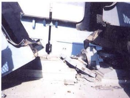
写真-Ⅱ. 2. 32 西宮港大橋隣接桁の落橋
