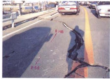
写真-Ⅱ.2.2 路面の亀裂・陥没
