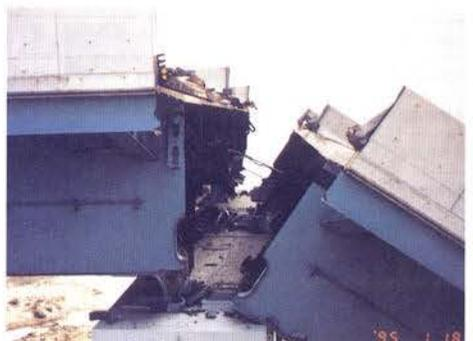
写真-Ⅱ. 2. 33 西宮港大橋隣接桁の落橋
