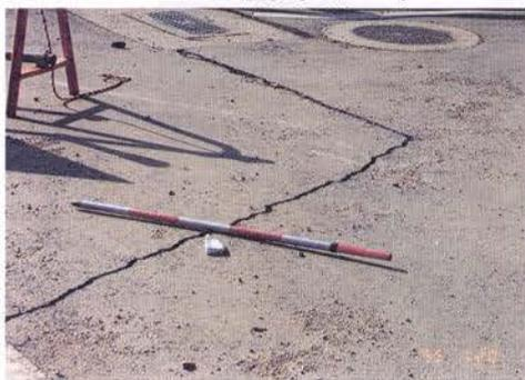
写真-II.2.78 天端舗装面のクラック
