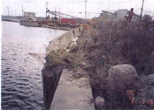
写真-Ⅱ. 2. 54 鋼矢板護岸の被災
