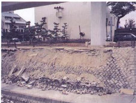
写真-Ⅱ.2.34 天端からの崩壊(住吉川)
