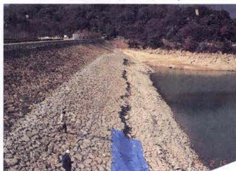
写真-II.2.79 第1ダム上流面張石の滑落
