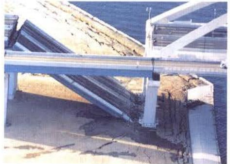
写真-Ⅱ. 2. 31 西宮港大橋隣接桁の落橋
