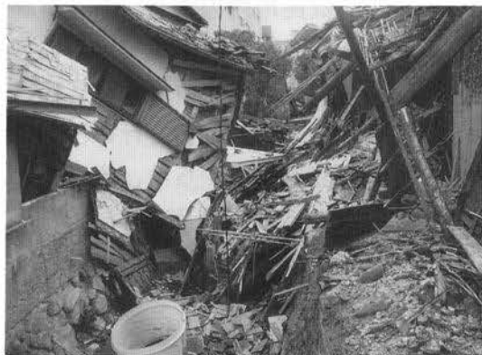
写真-Ⅲ.1.3 河川内に倒壊した家屋等
