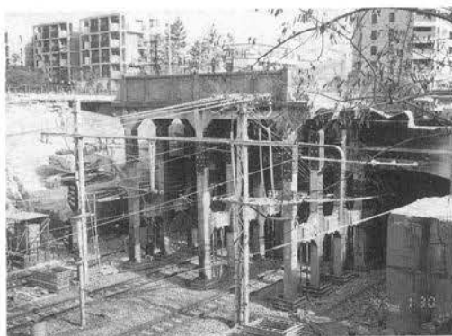
写真-Ⅲ.1.8 神戸線横断橋梁の取り壊し
