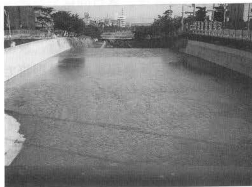
写真-Ⅲ.1.9 復旧完了
