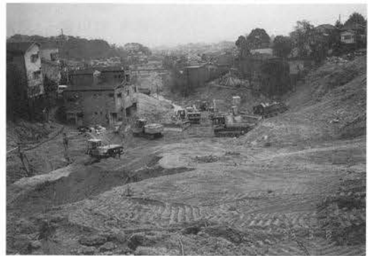
写真-Ⅲ.1.6 河道埋塞土砂掘削状況 (仁川百合野町地区)
