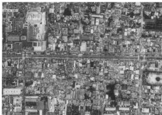
写真-IV.6.1 震災直後の国道2号の状況 (神戸市東灘区)
