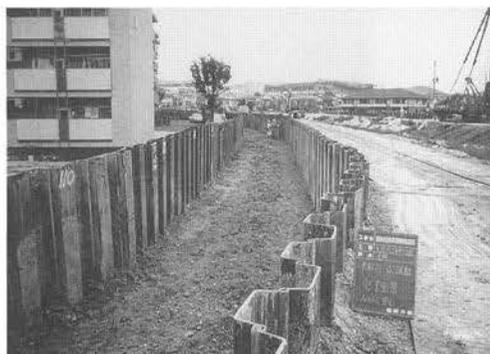
写真-V. 4.31 鋼矢板打設
