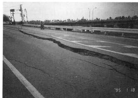
写真-V. 4. 36 堤体の円弧すべり
