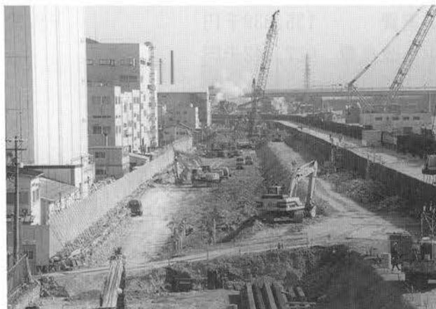
写真-V. 4. 24 現在の復旧状況 (二重締切完了後、既設堤防の掘削)
