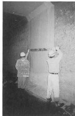
写真-V.4.11 復旧工事の完成（目地補修完成）
