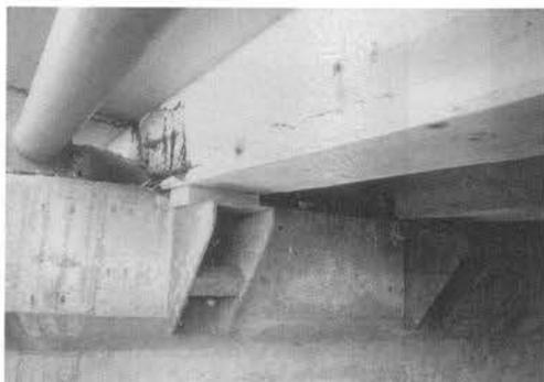
写真-V. 1.31 応急対策工法（沓座拡幅工）
