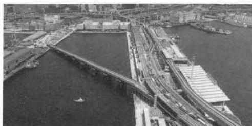
写真-V.7.16 神戸大橋に設置した仮道路
