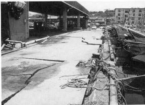
写真-V.7.7 上部工、本体工の被災
