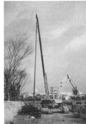
写真-V. 4. 48 施工状況 (H鋼杭打設)
