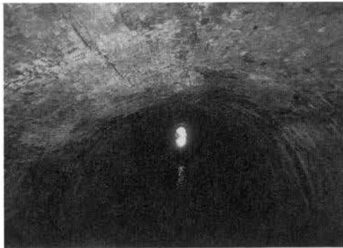
写真-V.4.12 トンネル上部の垂れ下がり状況
