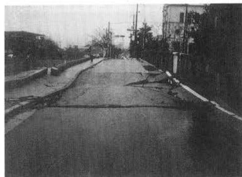
写真-V. 1. 35 橋台背面の陥没
