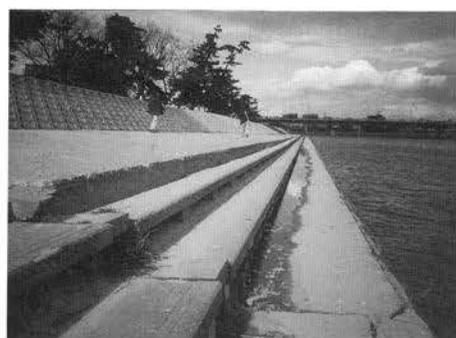
写真-V. 4. 38 堤水護岸の沈下
