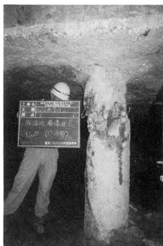
写真-V.5.8 事業着手前の状況（配管廊基礎杭の破損）
