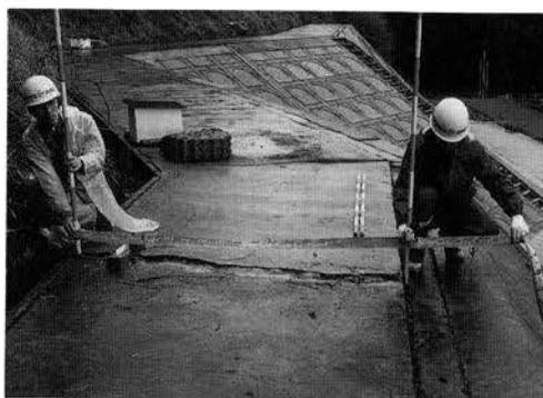
写真-V.6.5 プレキャスト法枠ブロックの変状
