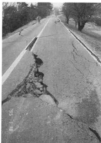
写真-V. 4. 35 堤体の亀裂・沈下
