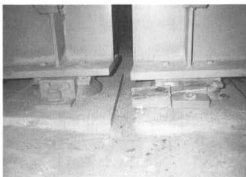
写真-V. 1. 22 橋脚上支承の損傷状況（P4）
