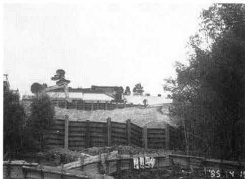
写真-V. 6. 24 仮設防護柵の設置状況
