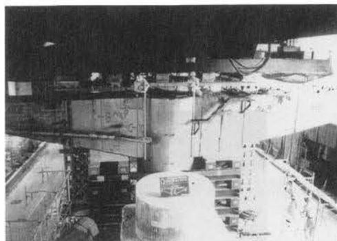
写真-V.3.6 梁部切断工
