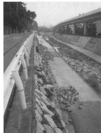
写真-V.4.4 被災状況（護岸のはらみ）
