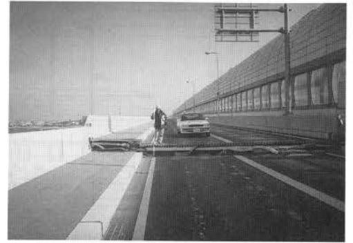
写真-V. 1. 25 橋面の段差 (P6橋脚)
