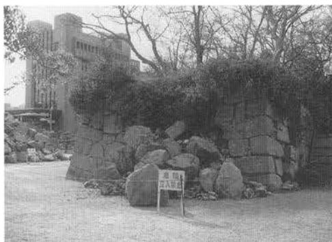
写真-V. 11. 5 石垣の被災状況
