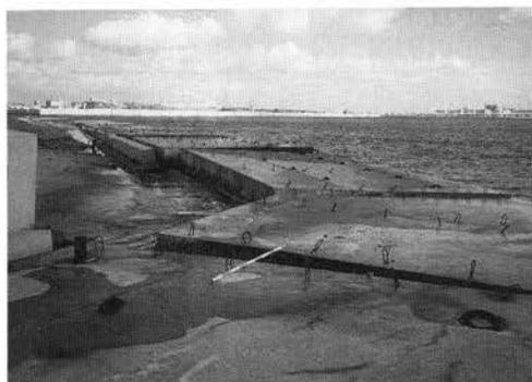
写真-V.7.12 ケーソンの沈下破損状況
