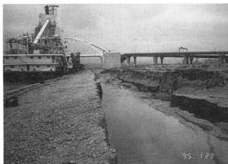
写真-V.7.4 岸壁ケーソンの滑動
