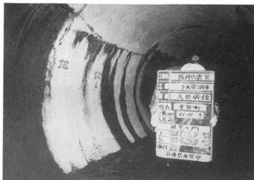
写真-V.5.6 事業着手前の状況（管体の破損、漏れ）
