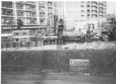
写真-V. 4. 28 土留用鋼矢板施工
