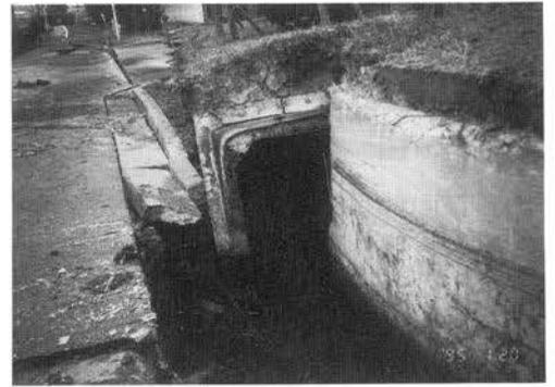
写真-V.5.4 導水渠継手の破壊
