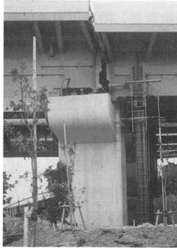
写真-V. 1. 24 橋脚の被災状況 (P6橋脚)
