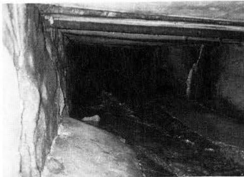
写真-V. 4. 16 インパートの浮き上がり及び側壁移動状況
