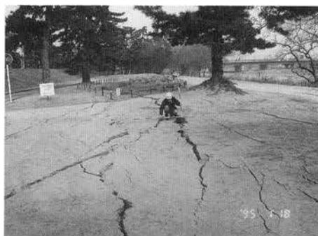
写真-V. 4. 37 高水敷の亀裂
