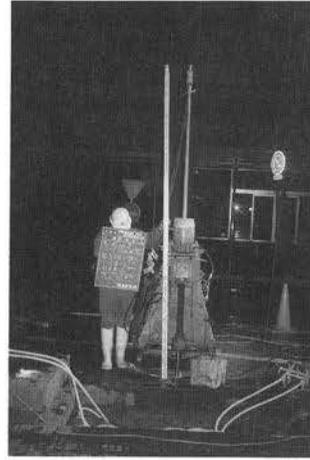
写真-V.4.9 薬液注入状況
