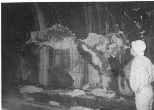
写真-V.1.61 盤滝トンネルの被災状況
