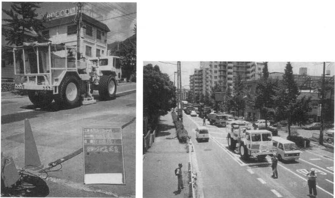
写真－1 反射法地震探査実施（バイブレーターによる人工地震発生）状況
