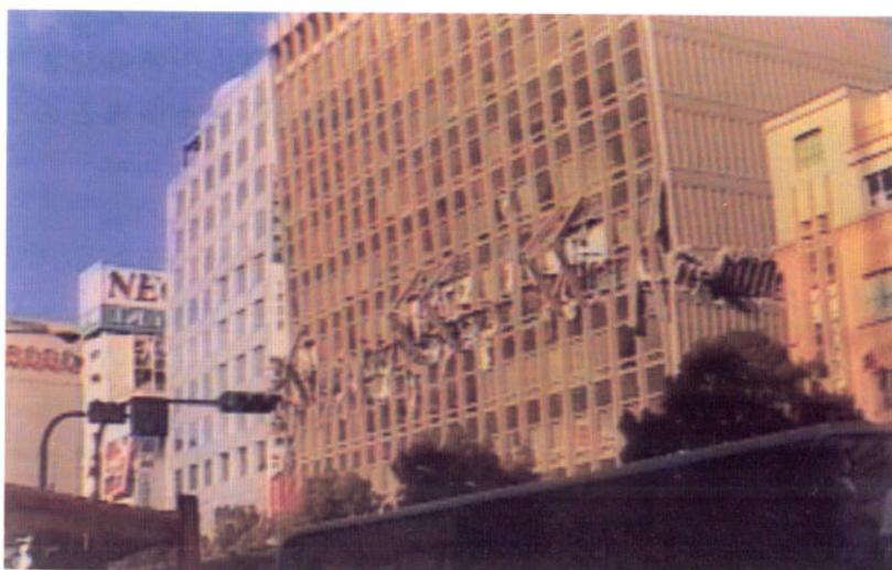
写真－6 ビルの倒壊状況
