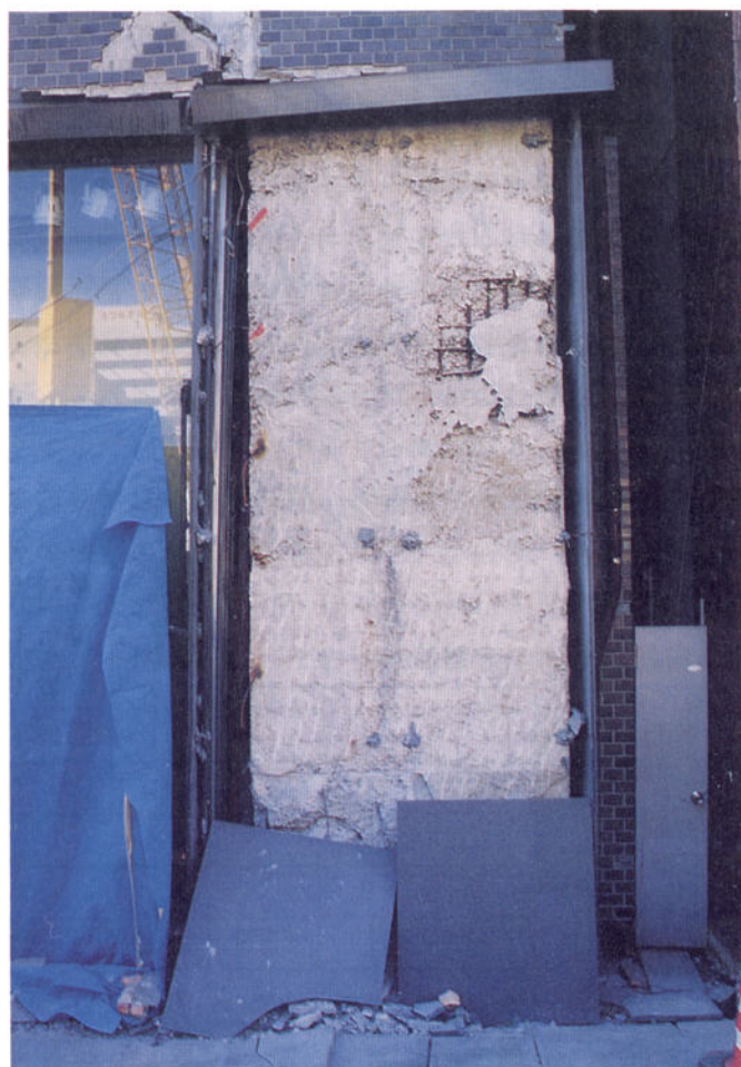
写真. 4-1 石 引き金物工法での剥離
