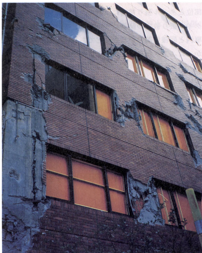
写真. 4-12 短柱の破壊
