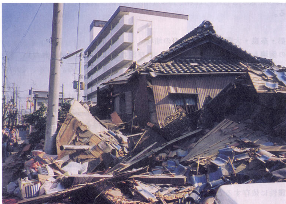
写真-4-20 西宮北口付近 古い和風住宅の倒壊、「土塗り壁・瓦屋根」 の最も倒壊の多い建物パターン
