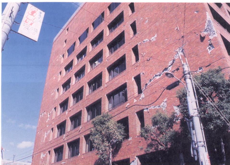
写真 3 - 3. C : 中破 (例)
