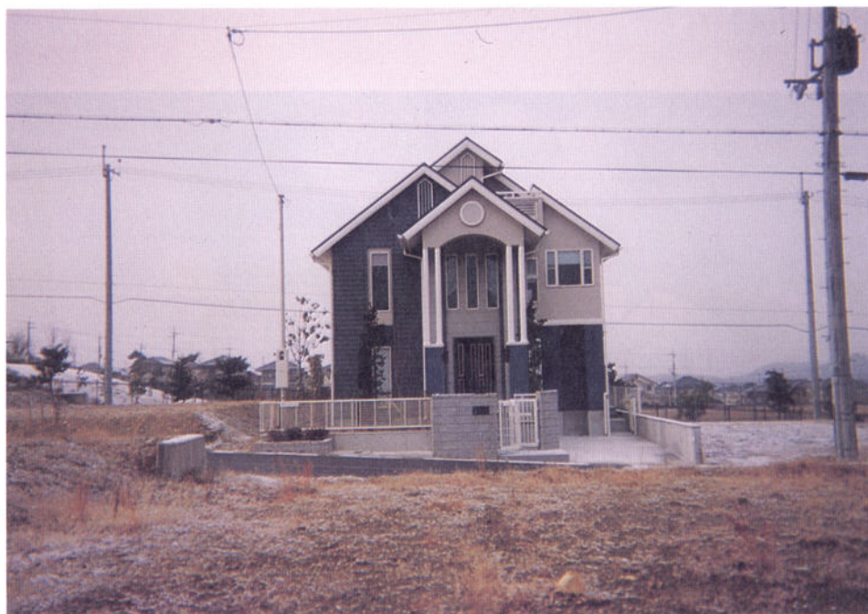
写真-4-36 三田市つつじヶ丘 金具留めサイディング、全く問題なし。
