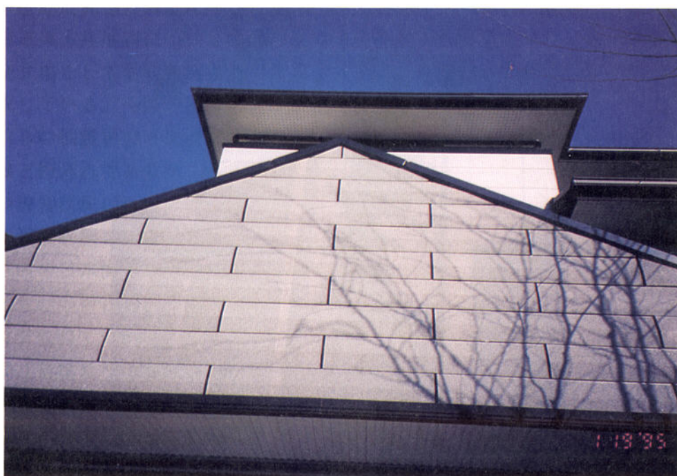
写真-4-35 西宮北口 金具留めサイディング、全く問題なし。
