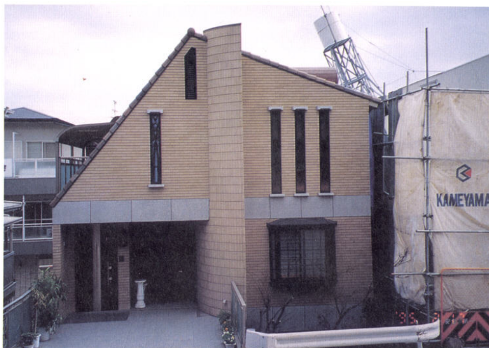
写真-4- 30 西宮市安井町 外観にはほとんど問題がない。
