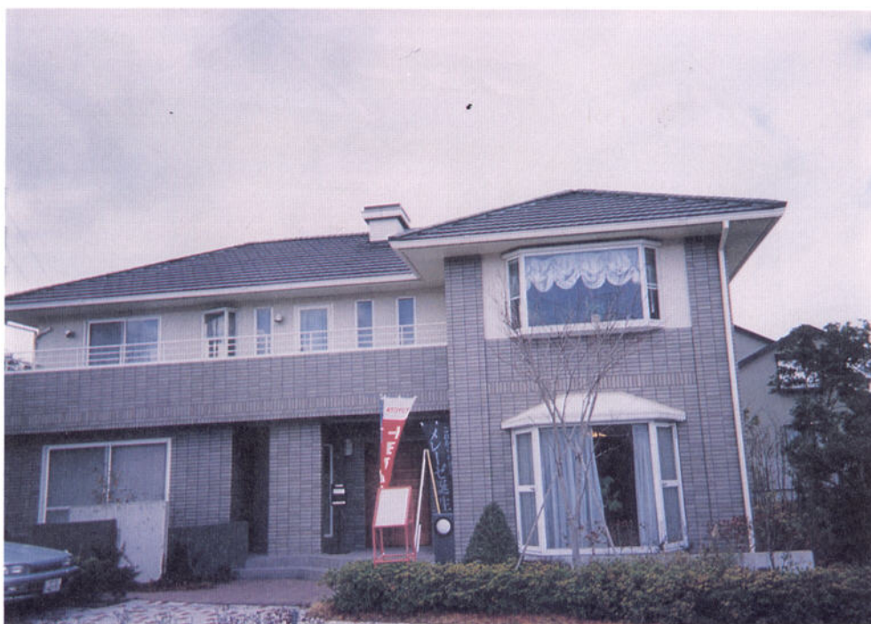
写真-4- 28 神戸市北町ハウジングコート 全体的には問題ない。
