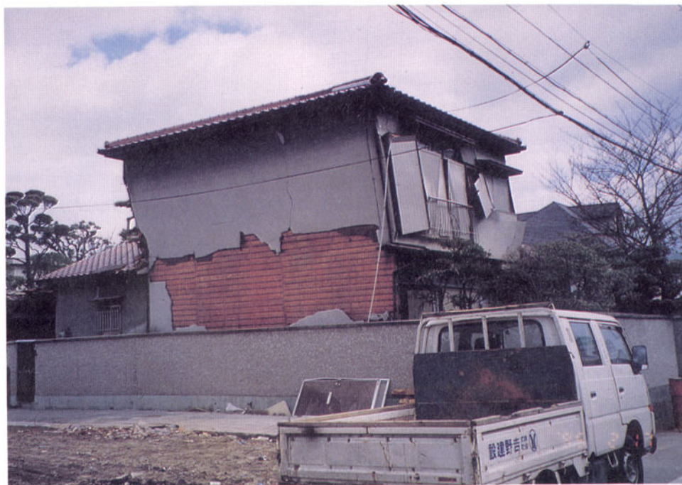
写真-4-23 阪神・西宮駅付近 ラス下地に吹付け、1 F 部分のラスが木ズリ部から落下。 建物も傾いている。
