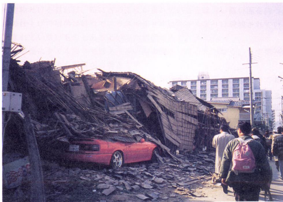
写真-4-21 同上 跡形もなく破壊。
