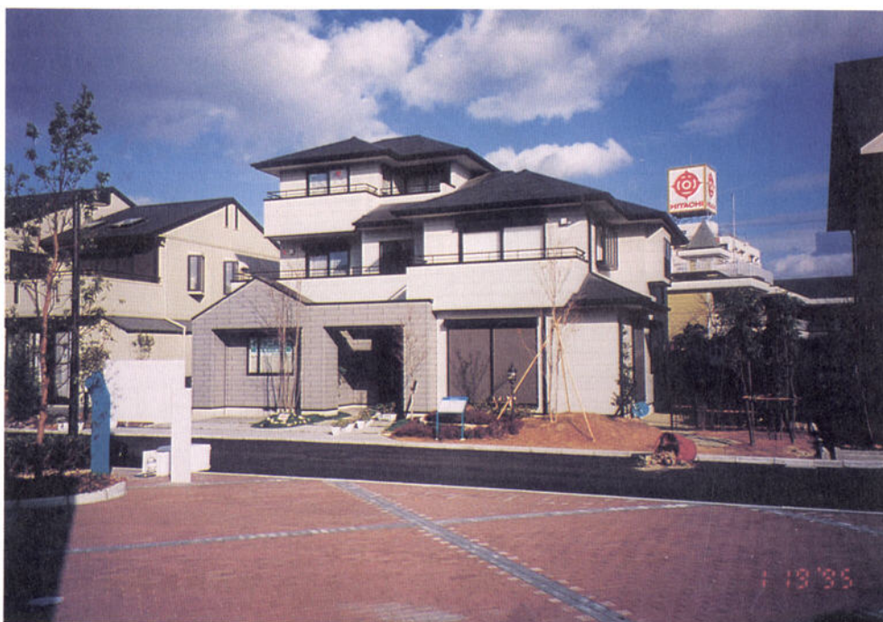
写真-4-34 西宮北口 玄関部分に金具留めサイディング、まったく問題なし。
