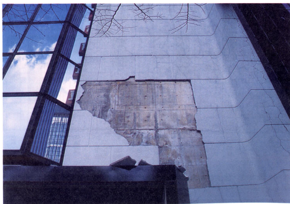
写真. 4-2 吹付け 剥離
