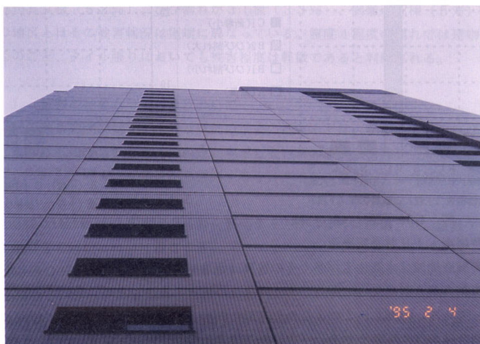
写真. 4-19 PC板のせり出し
