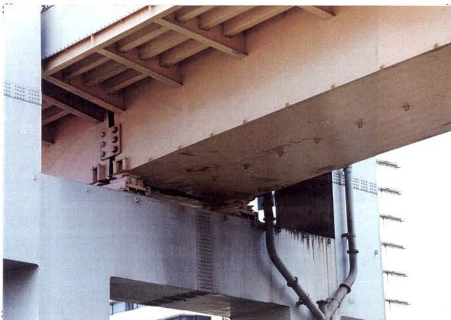
1. 12 e : P42 (下層桁) 一見、何も損傷はなさそう。山 側から見上げたとき。
