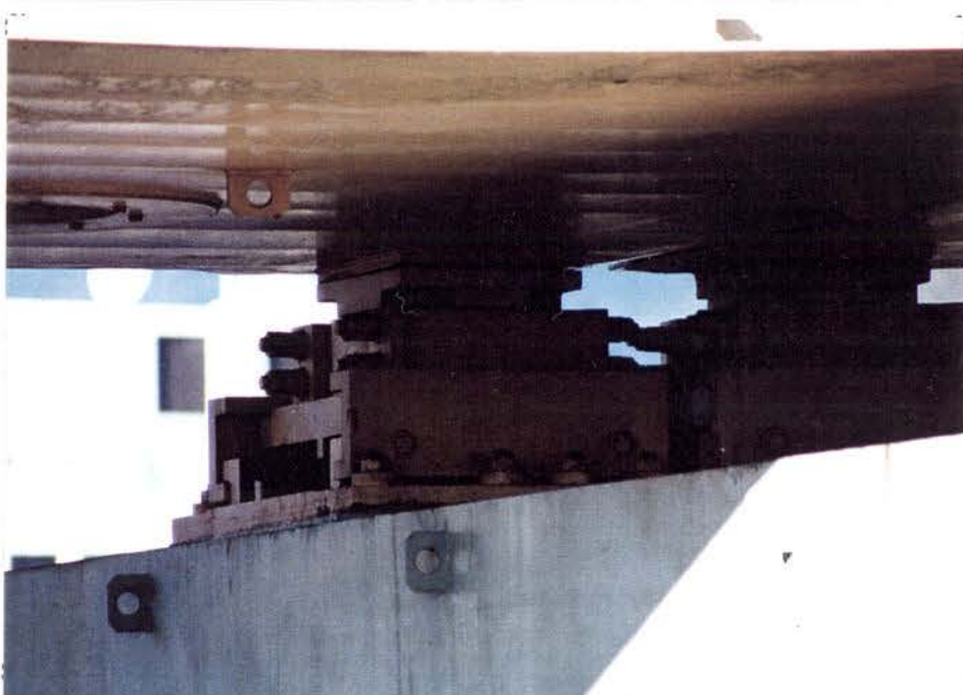
1. 12 d : P42 (上層桁) 同上。支承周辺。
