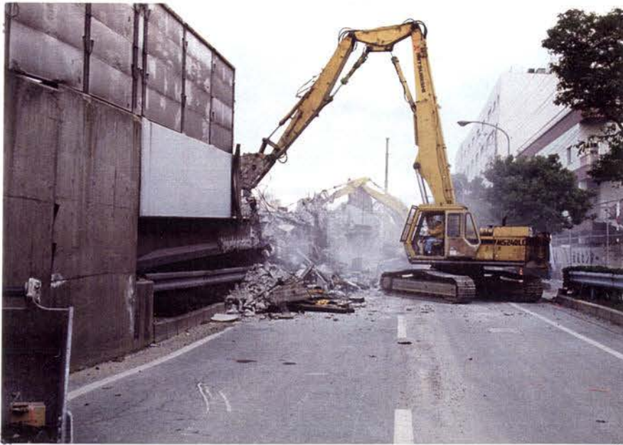
1. 24 a : 国道43号線 岩屋高架橋 RC下部工破損にともない、上 部工（プレテン桁）の撤去作業 中。
