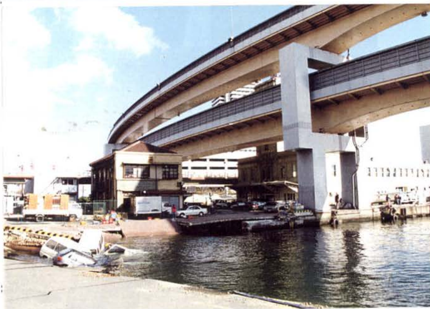
1. 1 b : 同上 岸壁が崩壊し、多くのバスや乗 用車が海に沈んでいる。
