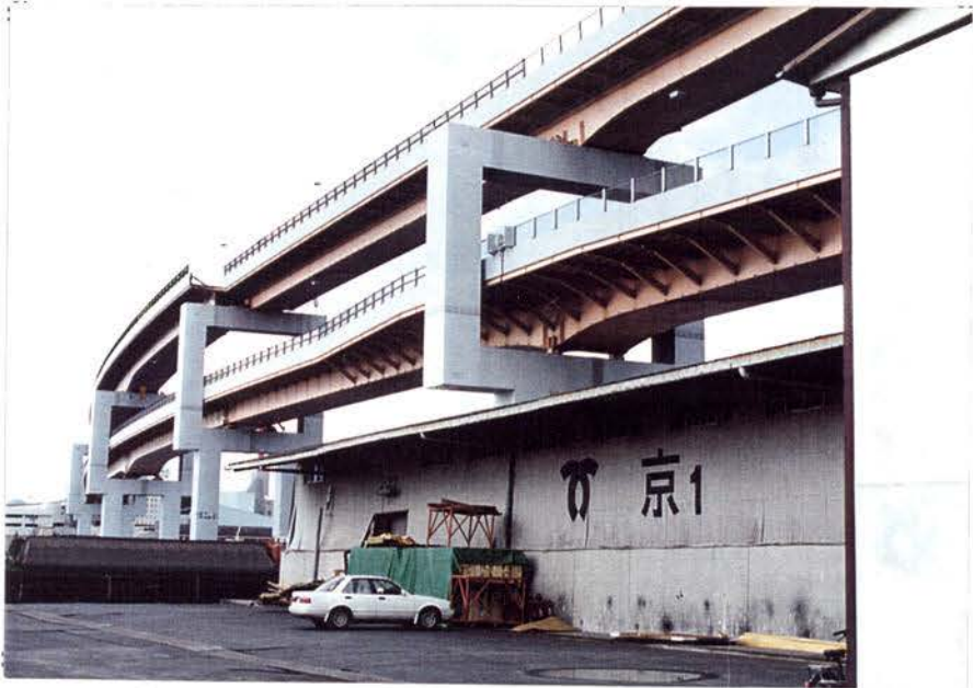
1. 3 : 新港町付近で 右から、P35、36・・・ P36上で上層桁が大きくずれている。
