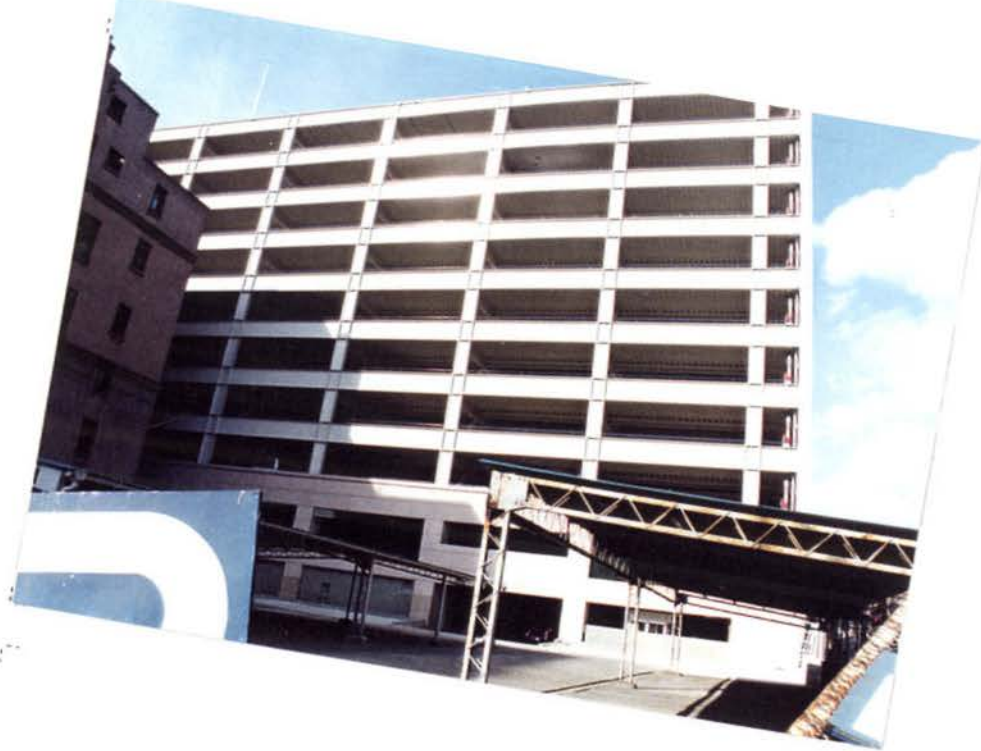
5.14: S造の駐車場 全く無傷。
