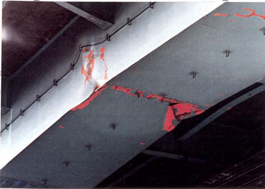
2-4.25p:同上 海側桁。
