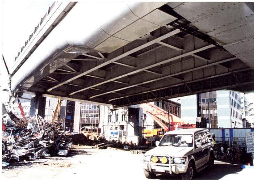
2-3.7:隣接の鋼桁部 海岸通り3丁目付近。
