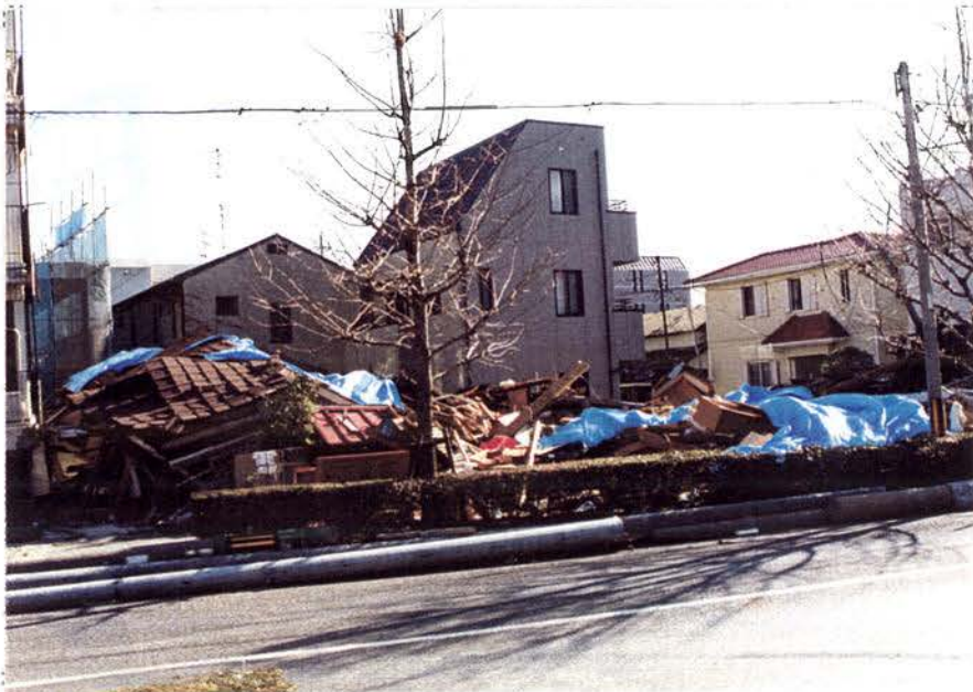
5.22：全壊した木造民家 このような風景はいたる所に見られる。木造の家は、何かしら被害を受けているが、そのような中にクラックひとつ全く無い無傷の民家がときどき残っているのが印象的である。
