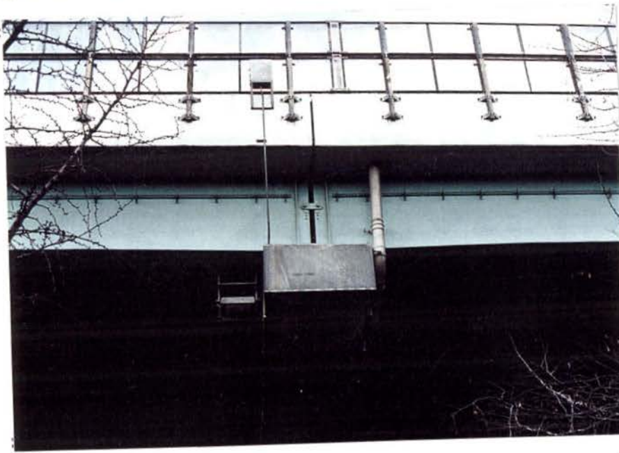
2-5.5: 同上 神155~159。 目立った損傷は見られない。
