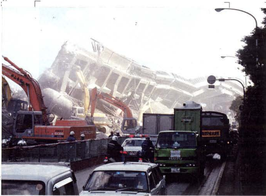
2-6. 1 : 倒壊したRC桁 深江地区のピルツ工法による RC脚と桁。通常は片側4車線 を1車線に規制し、撤去作業を 行っている。
