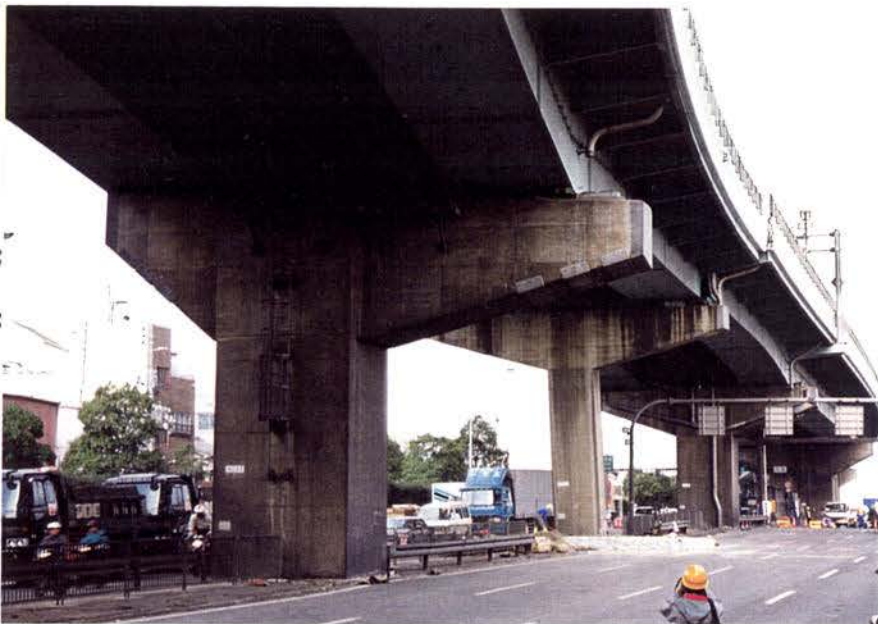
2-4.20b: 同上 神292から大阪よりでは、桁 は山側に移動している。
