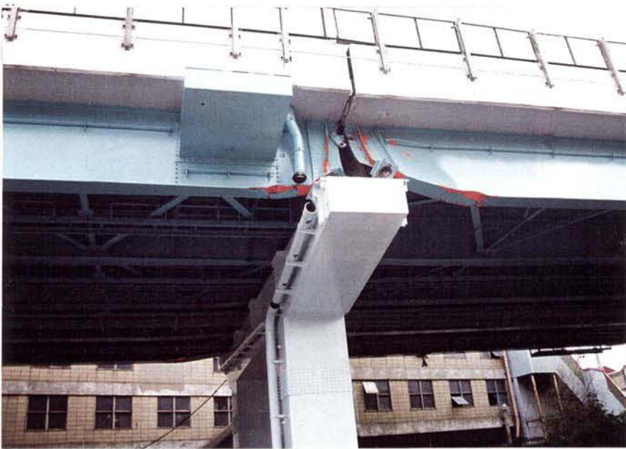
2-4.17b: 同上 隣の桁と同時に海側へ移動。
