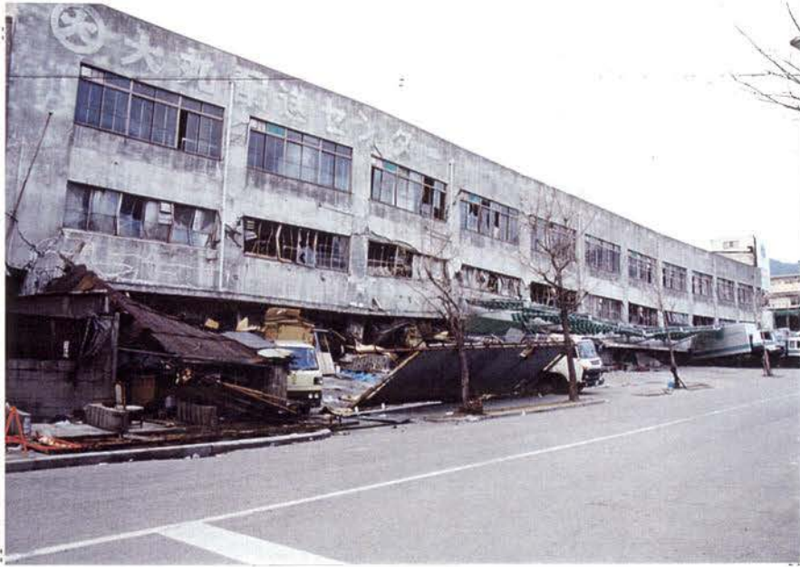
5.19：大和配送センター 1階部分が完全に崩壊したトラックターミナル。
