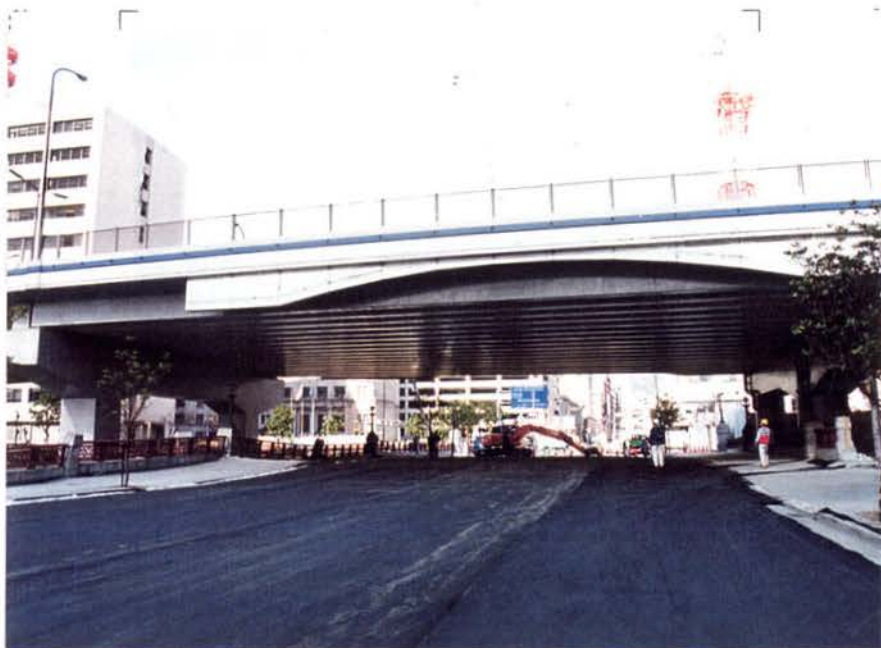
2-3. 1 a : 京橋付近 上下部ともに損傷はなさそう。
