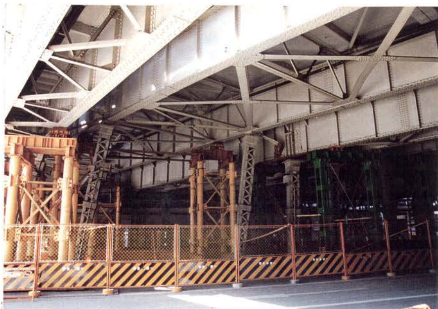
3.7 a : J R三宮駅ホーム桁 山側へ水平に移動。
