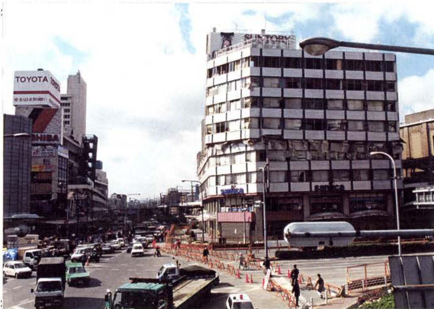
5. 7 : 三宮駅前2号線角 5階部分が崩壊。
