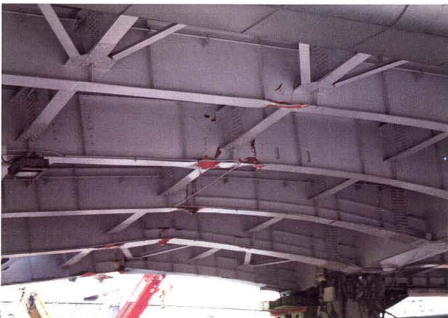
2-1.6 : 鋼I桁の曲げ座屈
