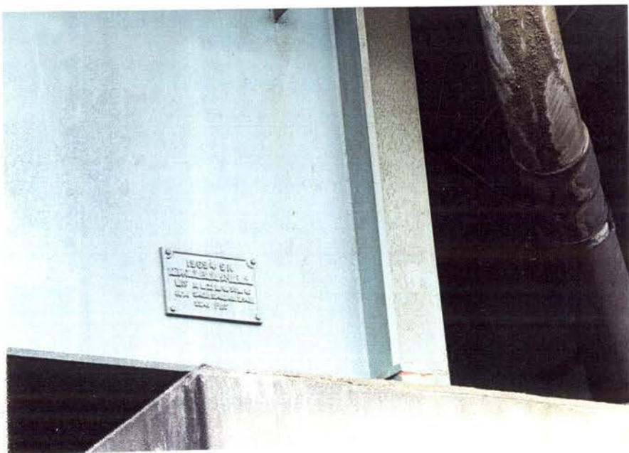
2-5.3 : 神154 当社施工の橋歴板。1969年 9月とある。
