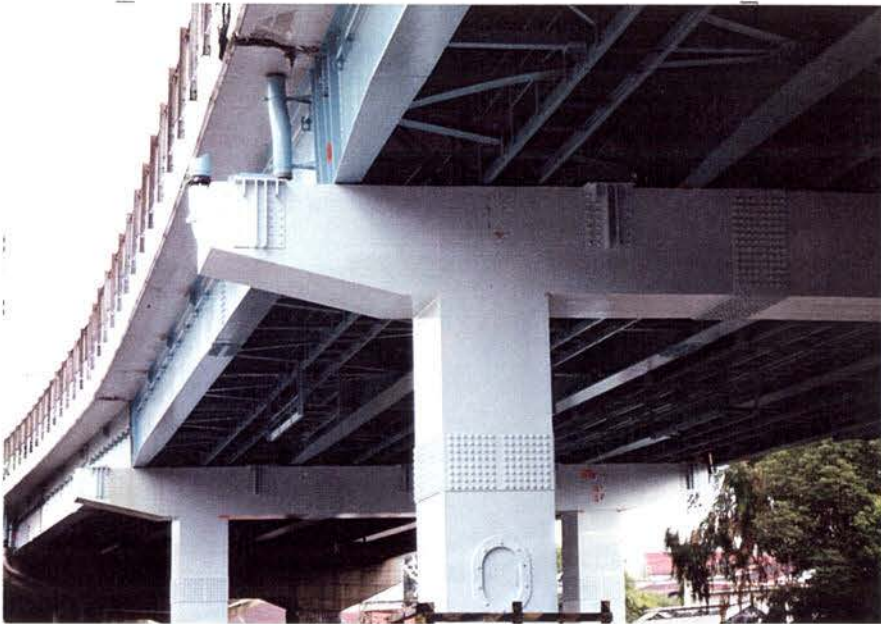
2-4.18: 神350~349 桁はねじれず、水平に移動。沓が余計な抵抗をしなかった。
