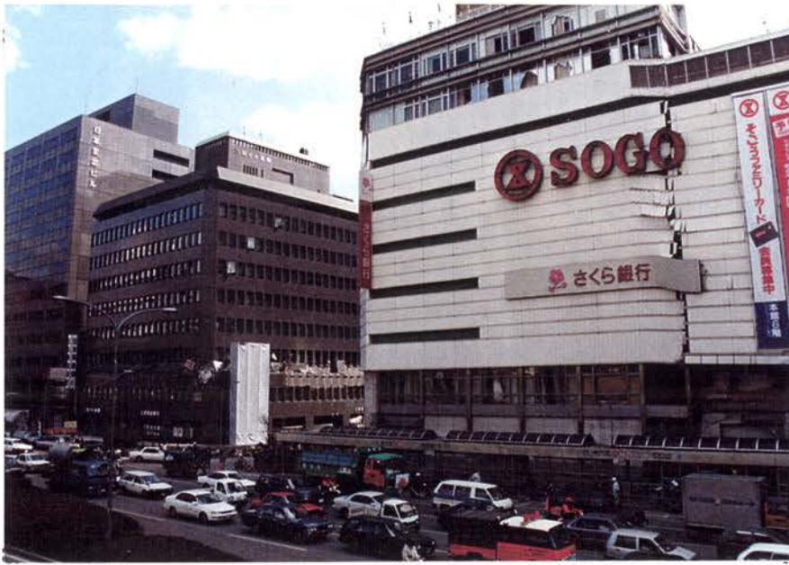
5. 6 : 三宮駅前 そごう。右半分の1階部分が崩 壊している。
