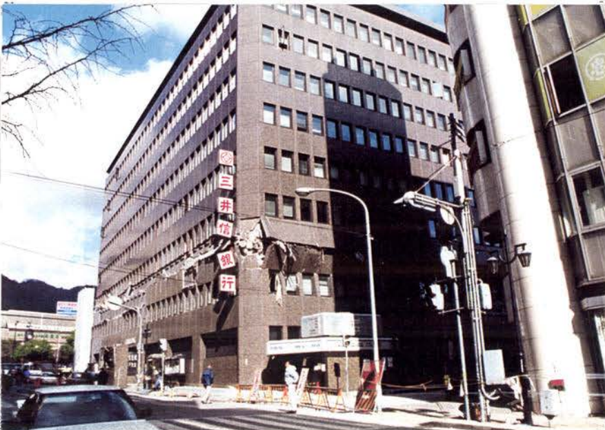
5. 8 : 三宮駅前三井信託銀行 3階部分が崩落。
