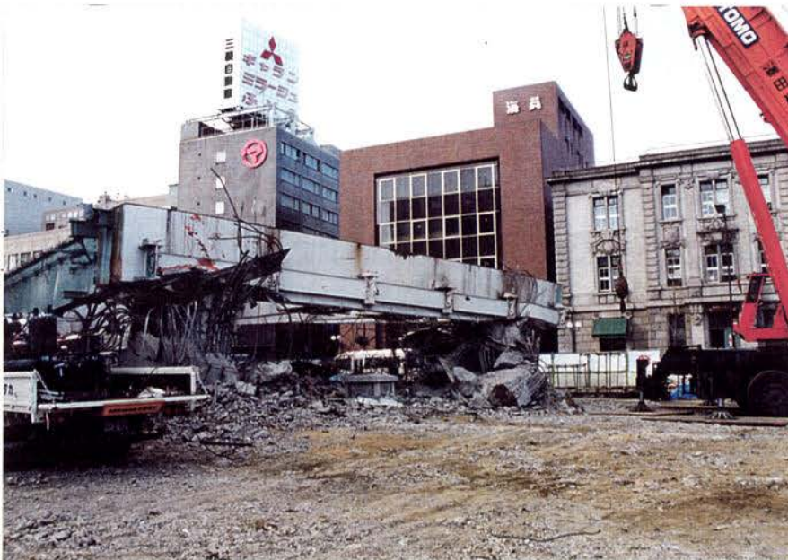
2-2.6a:神456 鋼桁の撤去が進む。
