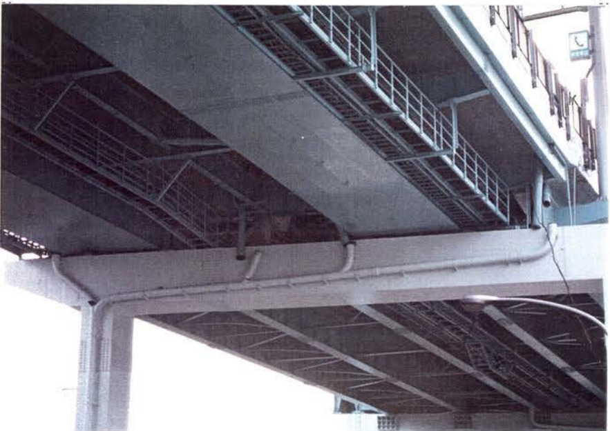
2-4.13c: 同上 隣の箱桁側。
