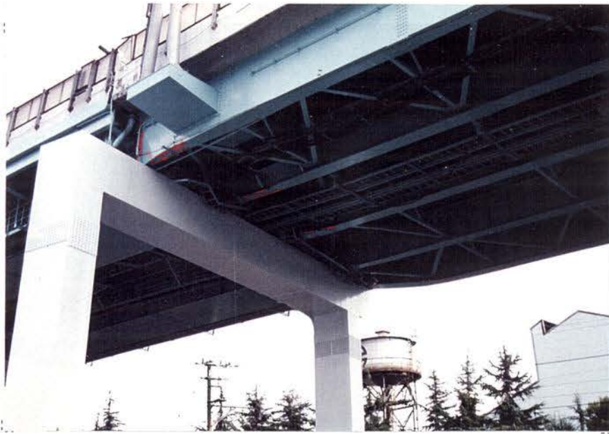
2-4.13a: 神370 隣接するI桁と箱桁が同時に海側へ移動。
