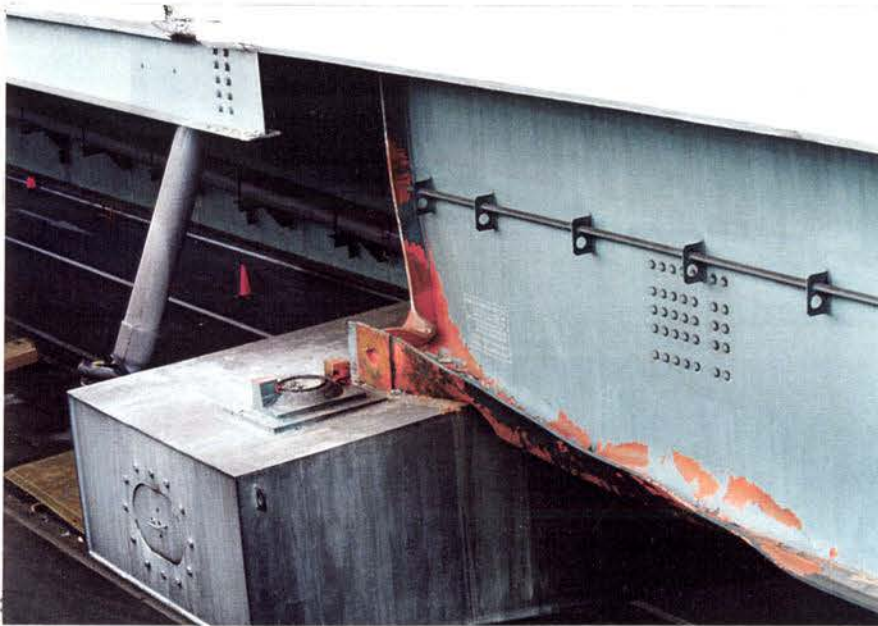
2-5.10a: 神170 BOX桁(左側)が山側へ移動し、I桁(右側)が引きずられてねじれ座屈。
