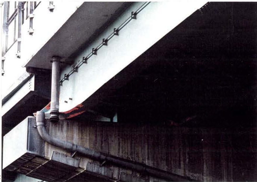
2-5.8a:神168 I桁のねじれ座屈。隣はBOX 桁。
