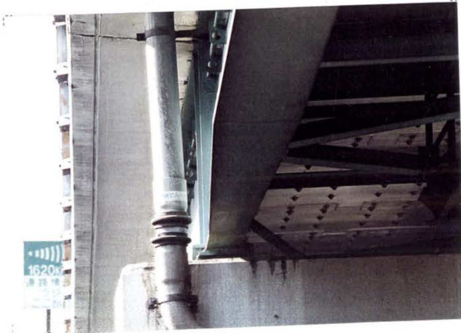
2-5.6: 神160 目立った損傷は見られない。
