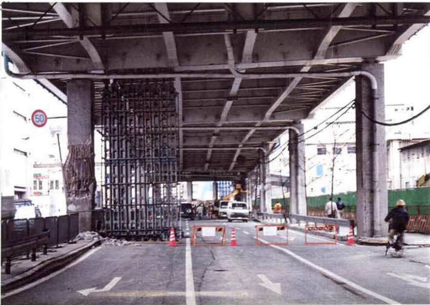
2-1.5 : 神475 左側（山側）に曲げ圧縮破壊。
