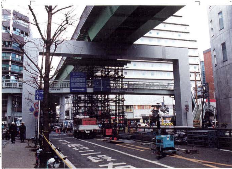
3.1: ポートライナー鋼箱桁 鋼製門型ラーメン脚上で支承か ら脱落 (三宮駅前)。
