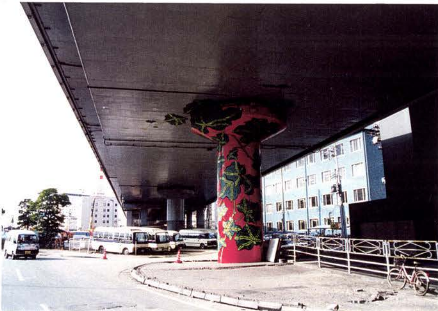
2-3. 3: コンクリートスラブ 桁とピルツ柱 全く損傷見られず。
