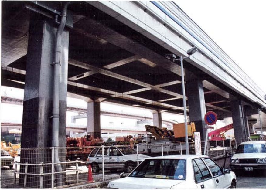
2-3.4:隣接のRCスラブ RC柱と一体であるが、殆ど問 題なし。
