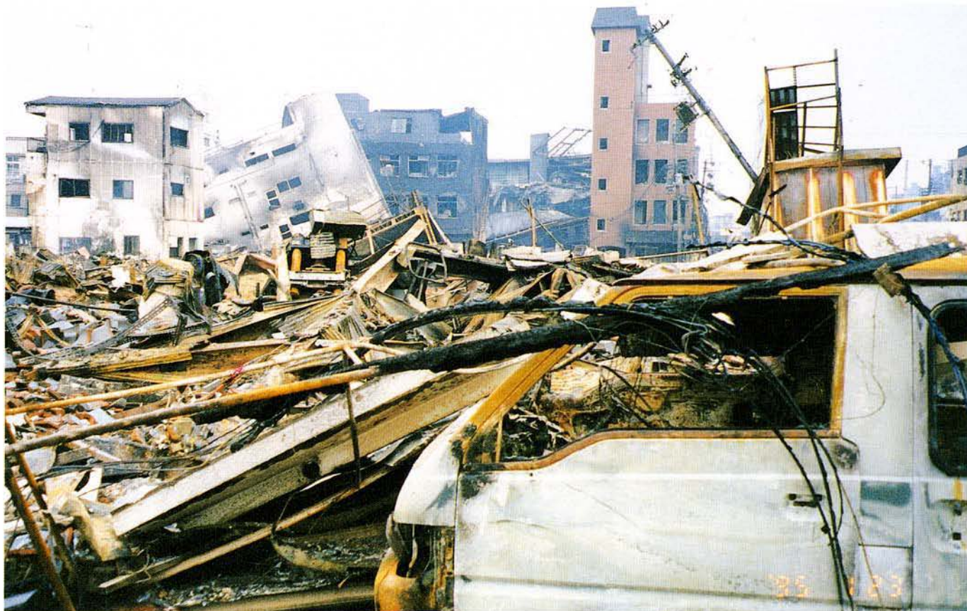
建築物の倒壊、焼失（神戸市長田区）
