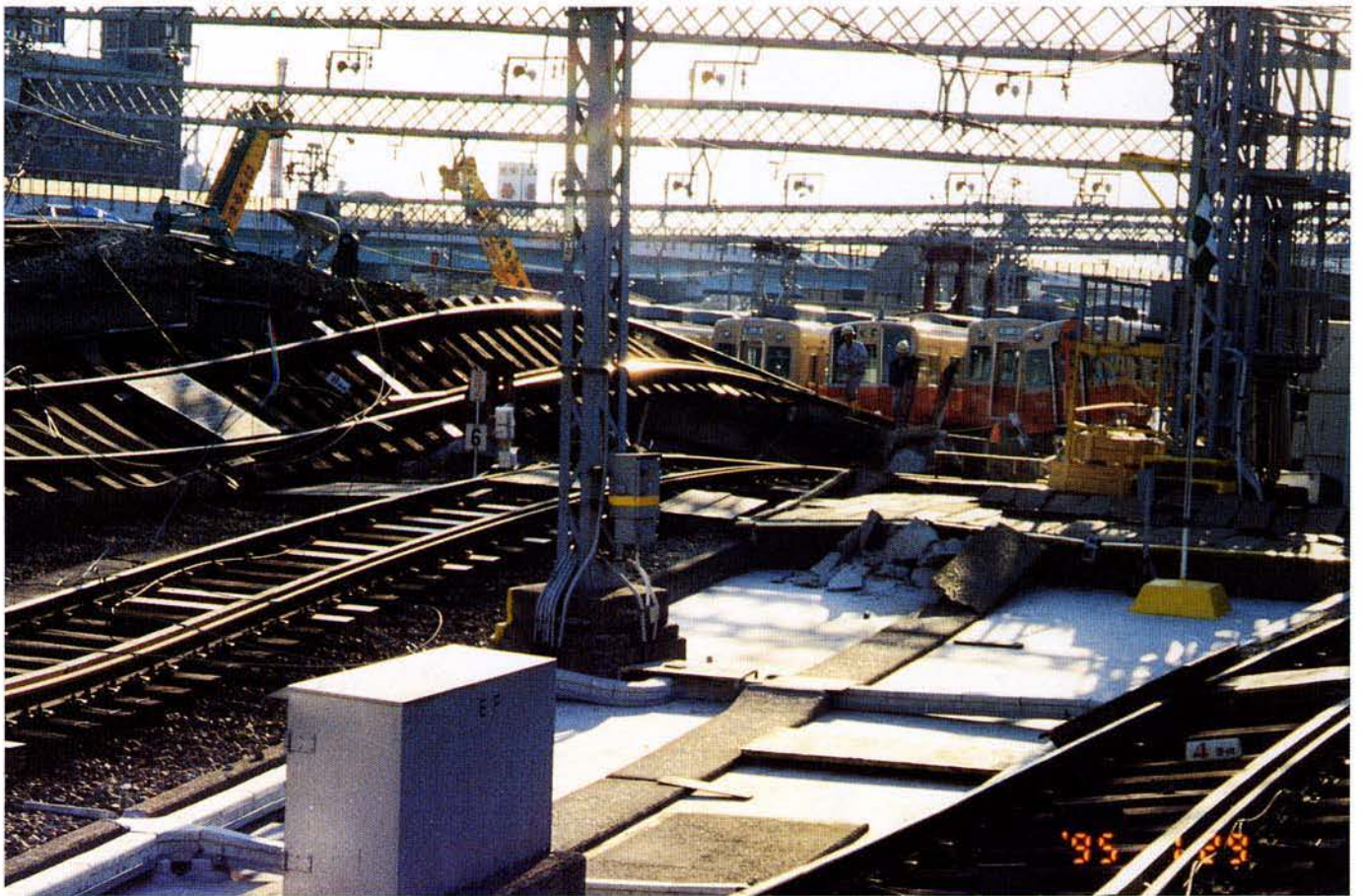
阪神電鉄軌道の被害（神戸市灘区）
