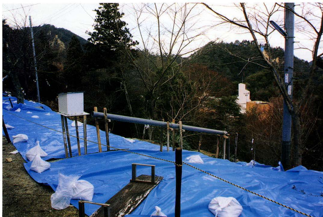
緊急応急対策としてのビニールシート被覆、伸縮計設置（神戸市北区）
