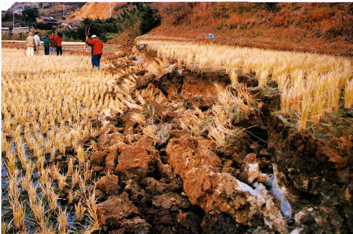
野島断層の亀裂（津名郡北淡町）
