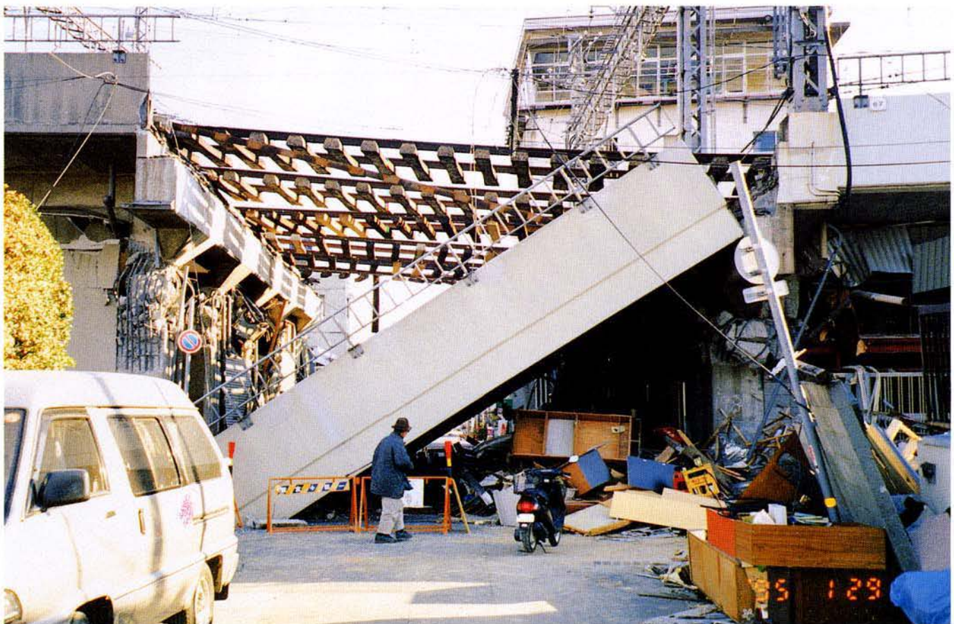
阪神電鉄高架橋の落下（神戸市灘区）
