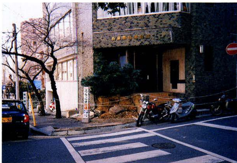
被災を受け使用不能となった林業会館
