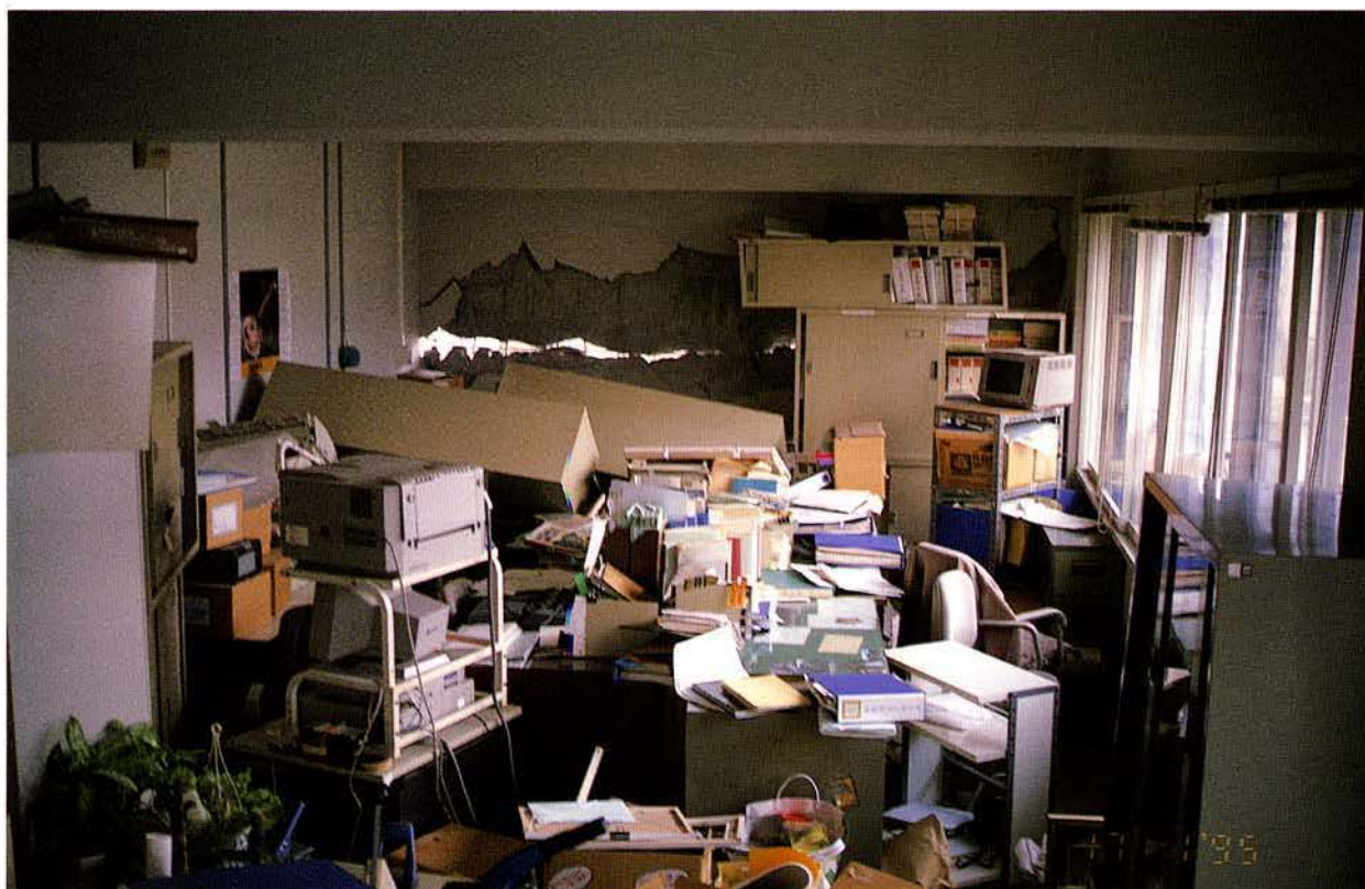
ロッカー、書類の散乱、壁の崩落（神戸市中央区 県庁6階・治山課）
