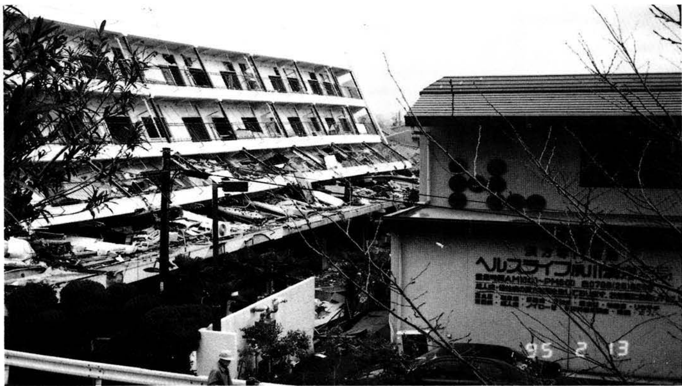
倒壊したマンション（西宮市）
