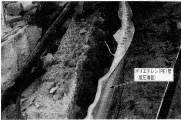
露出したがガス漏れのなかったポリエチレン管(東灘区)
