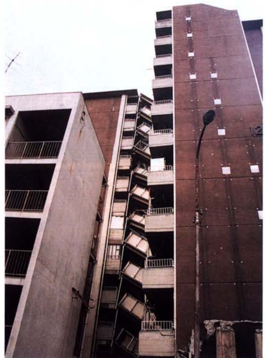
市営住宅の渡り廊下も1階ずつ下に(中央区)
