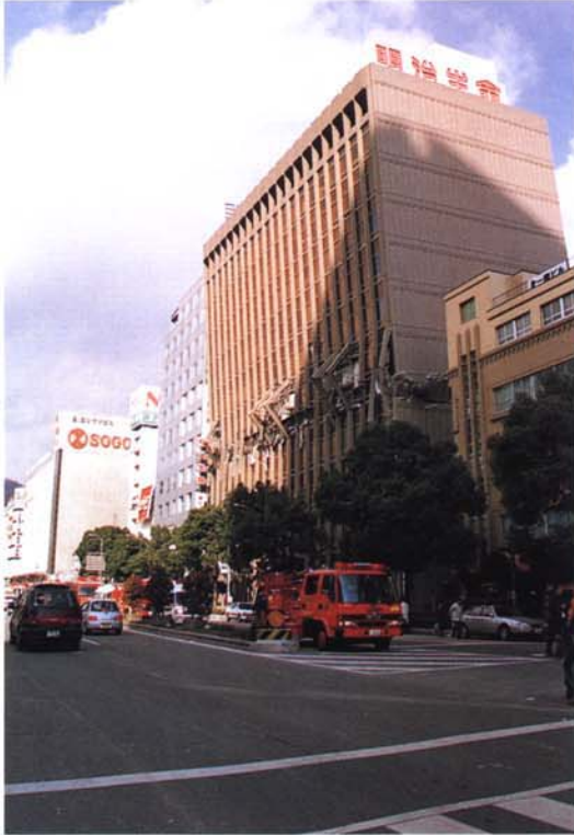
中間階が崩れた明治生命ビル
