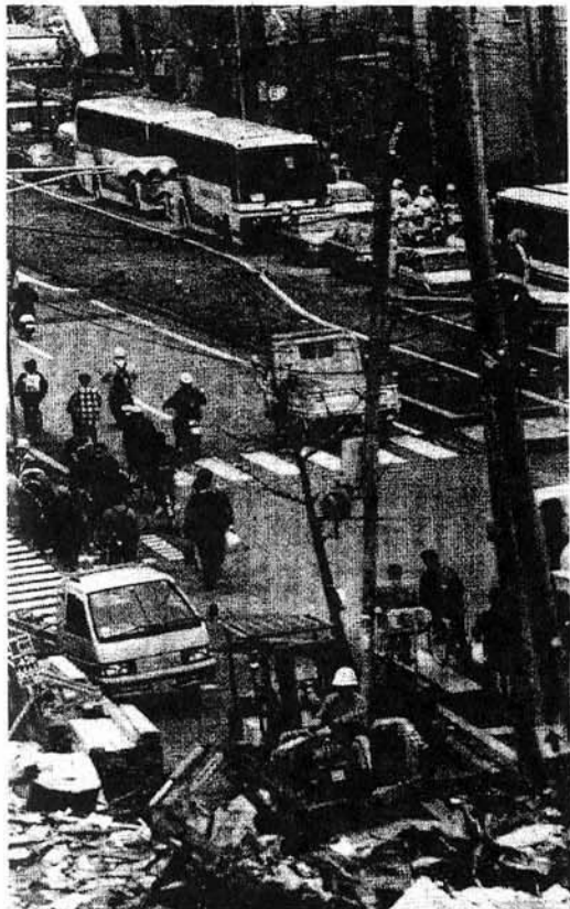
代客バスも運行され、復旧に動き出した街 23日午後3時30分、神戸市東灘区
