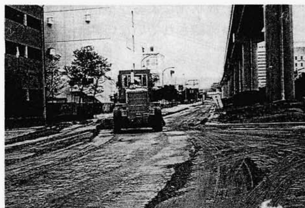
モーターグレーダーによる土砂撤去 （ポートアイランド）
