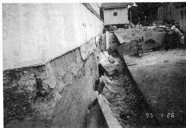
会下山配水池
