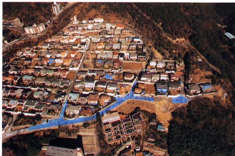
擁壁が崩れ避難勧告がでた造成地（東灘区）
