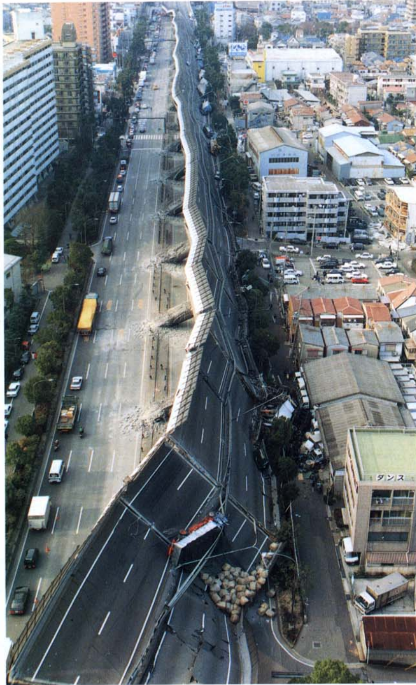
倒壊した阪神高速道路神戸線（東灘区）（読売新聞社提供）
