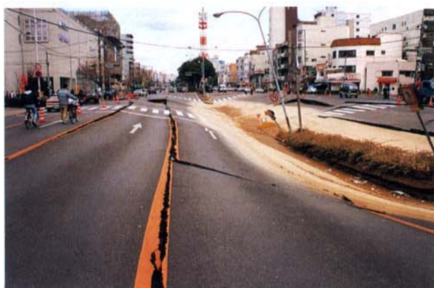
陥没した神戸高速大開駅
