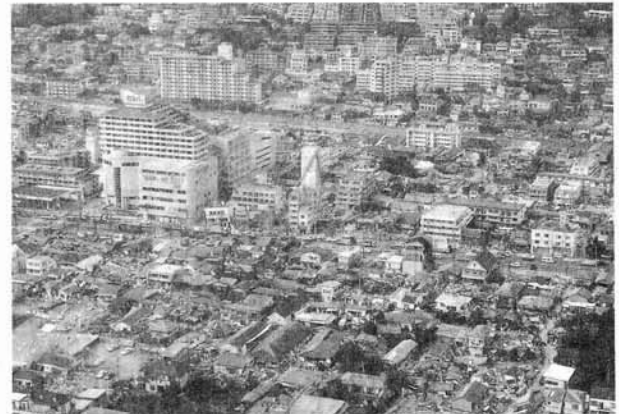
東灘区の倒壊地区
