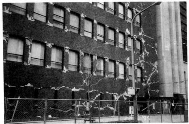
江戸町SKビル正面外壁
