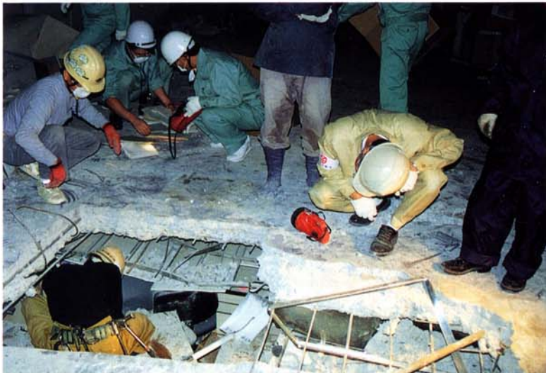
6階部分に穴を開け資料の搬出
