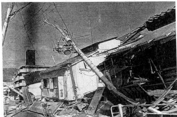
配電設備の被害（神戸市東灘区 1月20日）
