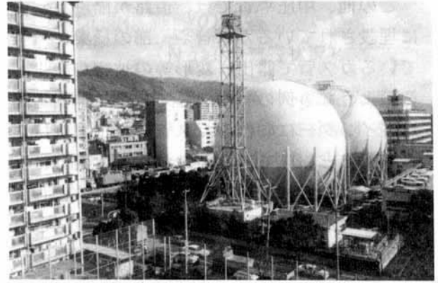
激震地区で被害の無かった葺合供給所のガスホルダー
