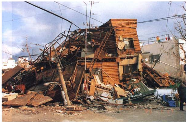
倒壊した木造家屋（灘区）
