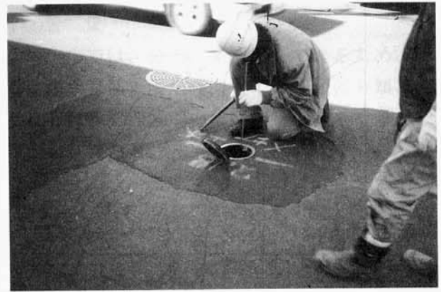
漏水調査（音聴）
