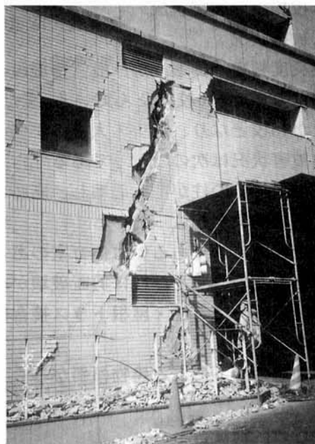
灘区民ホール南面外壁
