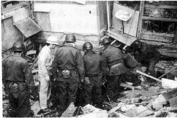
下敷きになっている人を激励しながらの救出活動
