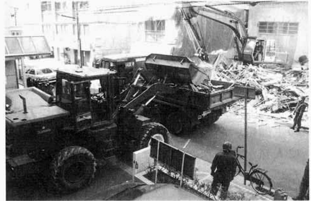
丁重に行った解体作業 中央区雲井通
