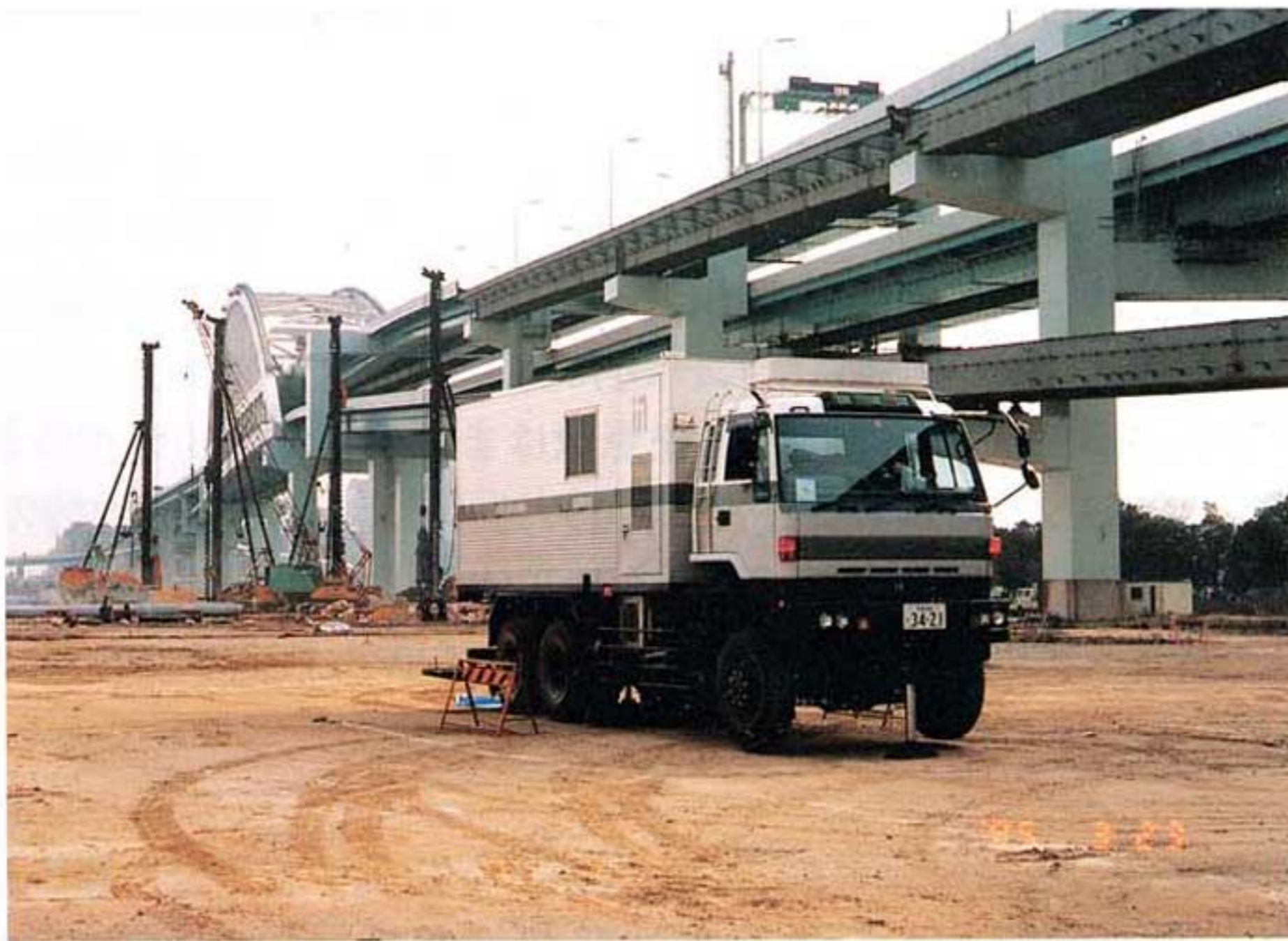
写真2.1-2 地盤調査車による調査風景（神戸市魚崎浜町）
