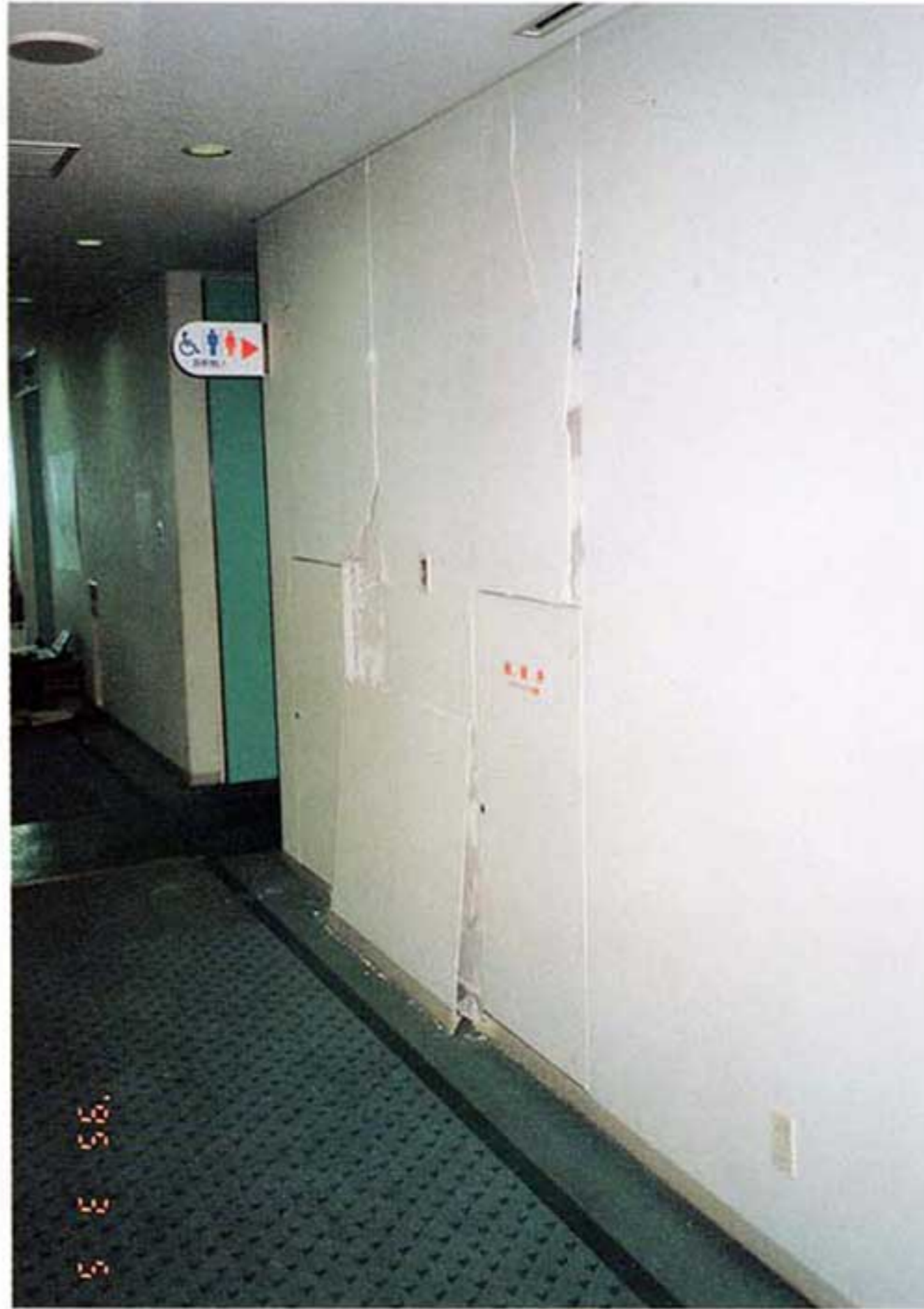
写真6.2-3 廊下の壁のボードの 状況
