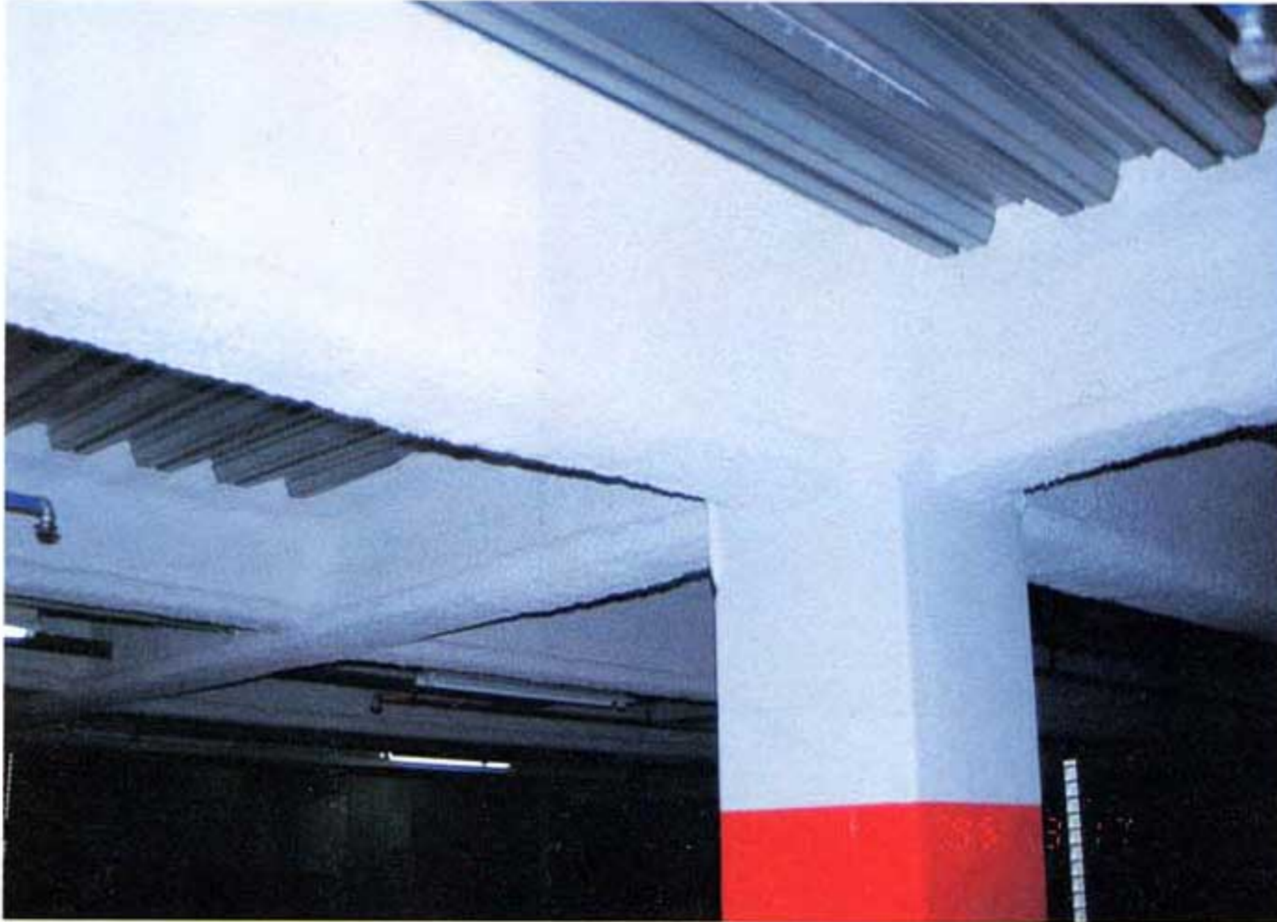
写真6.3-1 健全な耐火被覆材 (西宮市, E立体駐車場)
