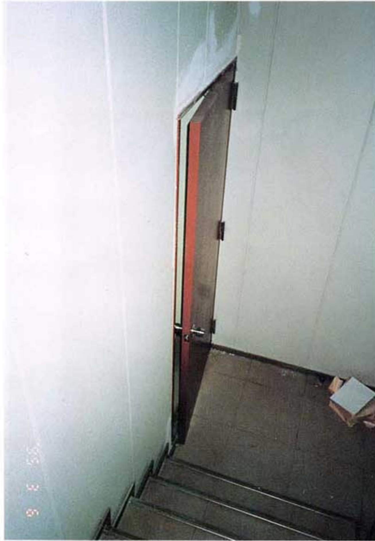
写真6.2-7 ドアクローザーの トルク不足で閉鎖 しない防火戸
