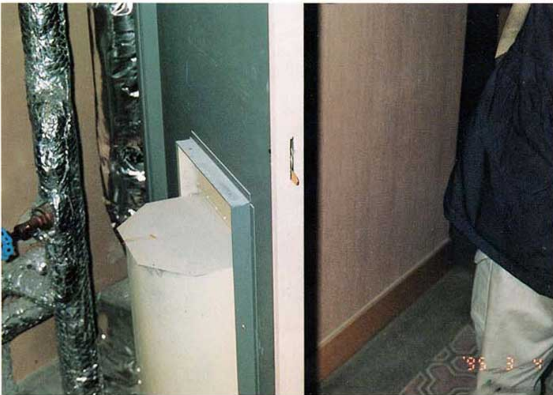
写真6.2-8 パイプシャフトの扉の 錠
