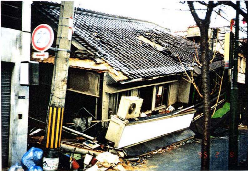
写真 2.3.67 一階部分の層崩壊、瓦 屋根の落下 宝塚市栄町の商店
