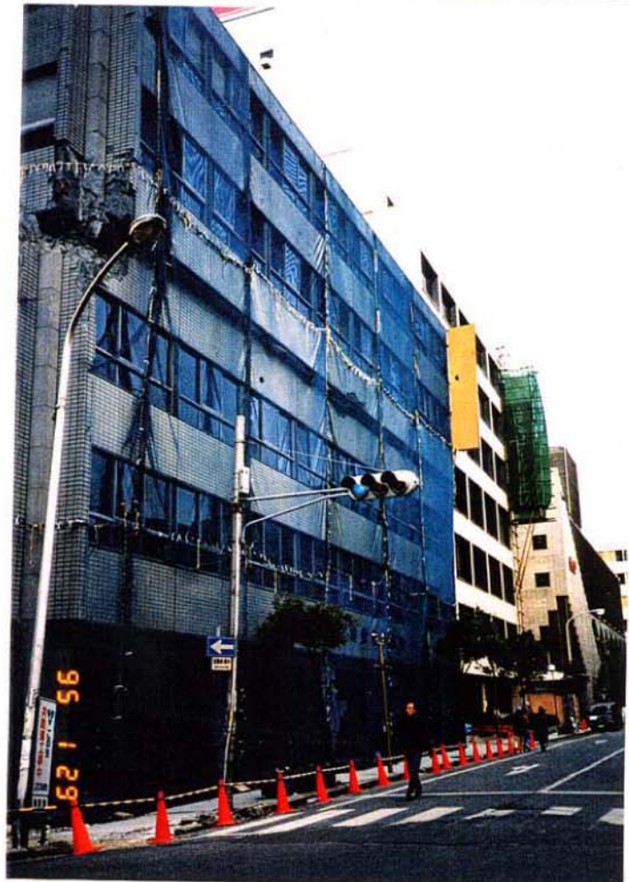
写真2.3.24 4階以上は、北西側に 移動している。4階柱 の破断面から、鉄骨形 状はアングルを用いた 組立て断面となってい る。
