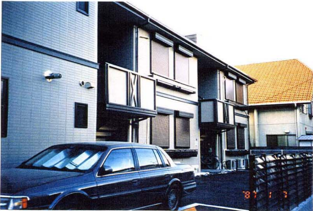
写真 2.3.70 竣工間際の共同住宅で 無被害 東灘区魚崎北町
