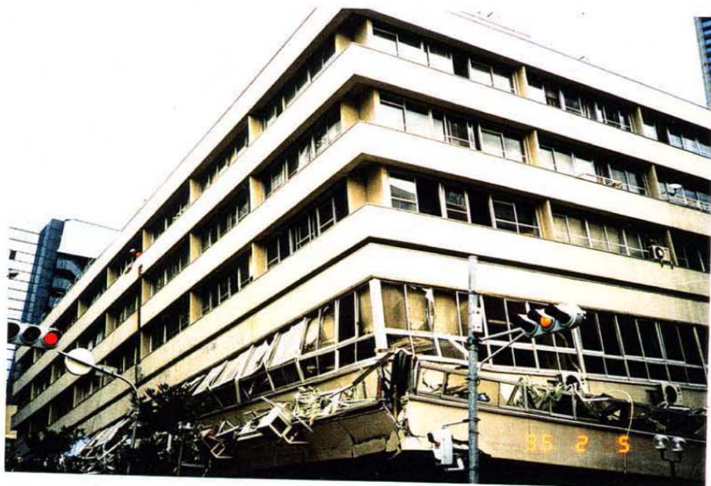
写真2.3.9 2階が層崩壊している。 1～3階まで店舗、4 階以上が住宅である。 4階以上は、1～3階 に比べ壁量が多いと思 われる。
