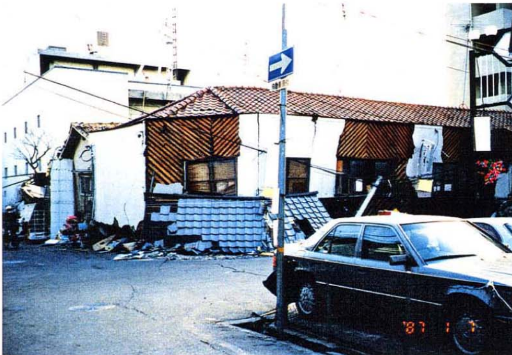
写真 2.3.68 一階部分の層崩壊、屋 根落下 東灘区魚崎北町
