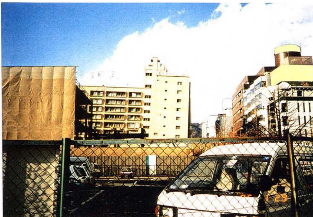
写真2.3.4 層崩壊に伴い、建物全 体が東側に傾斜してい る。
