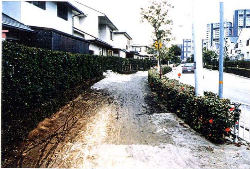
写真 2.2.3 住宅街の噴砂 (芦屋市浜風町)
