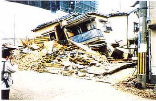
② 木造住宅の倒壊
