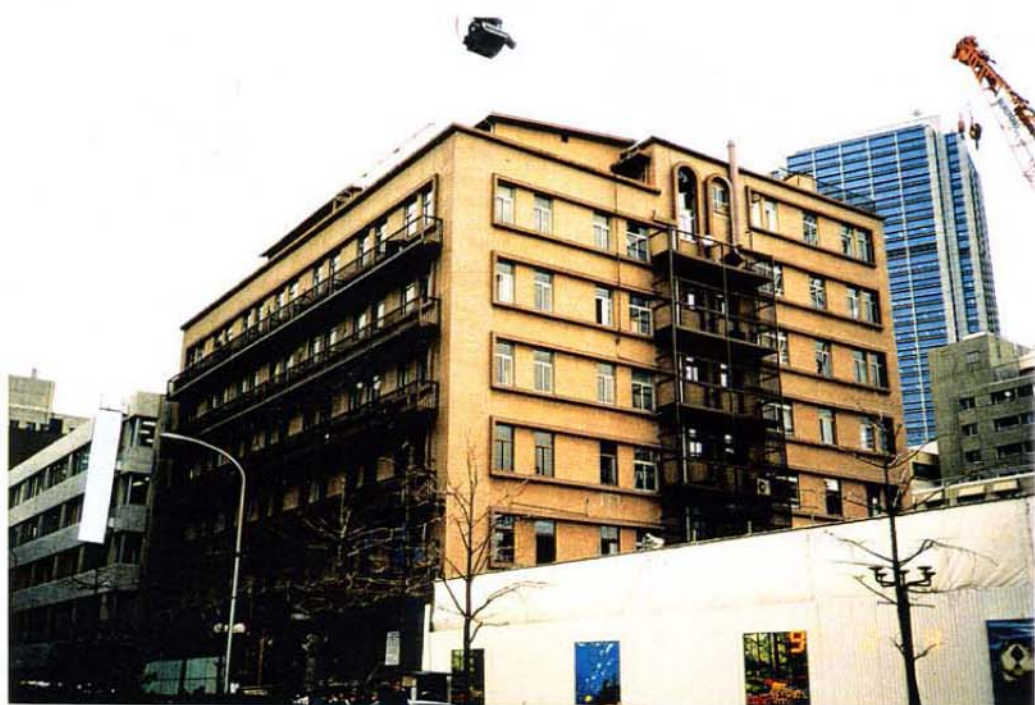
写真2.3.5 1階が層崩壊している。
