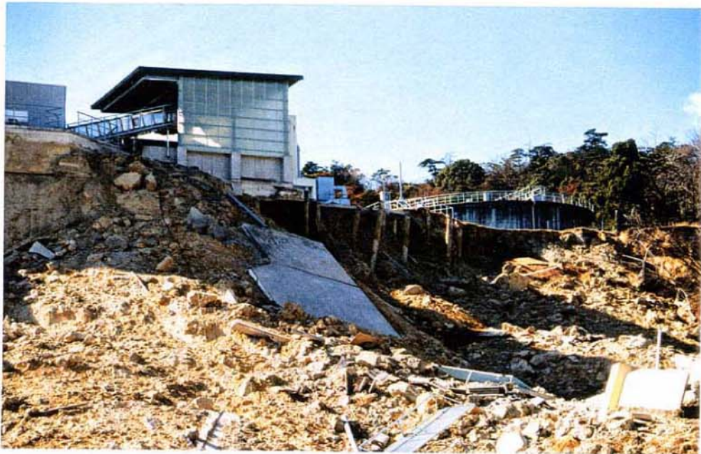
写真 2. 2. 10 マサ土斜面の崩壊 (西宮市仁川町)
