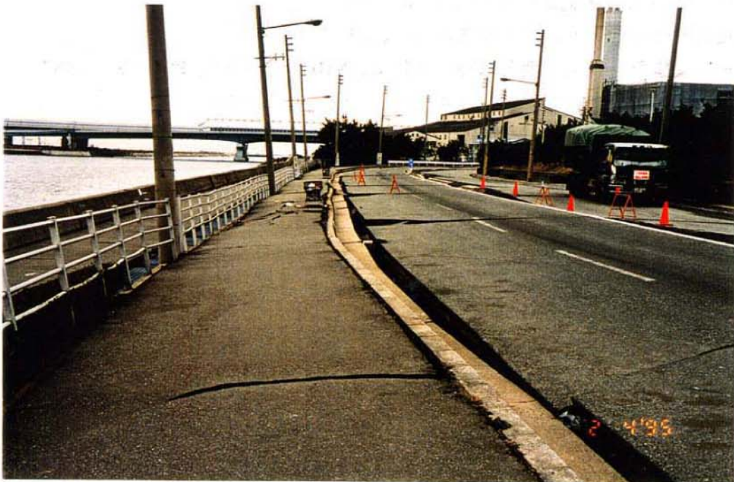
写真 2.2.2 護岸地盤の側方流動 (芦屋市尼崎港)
