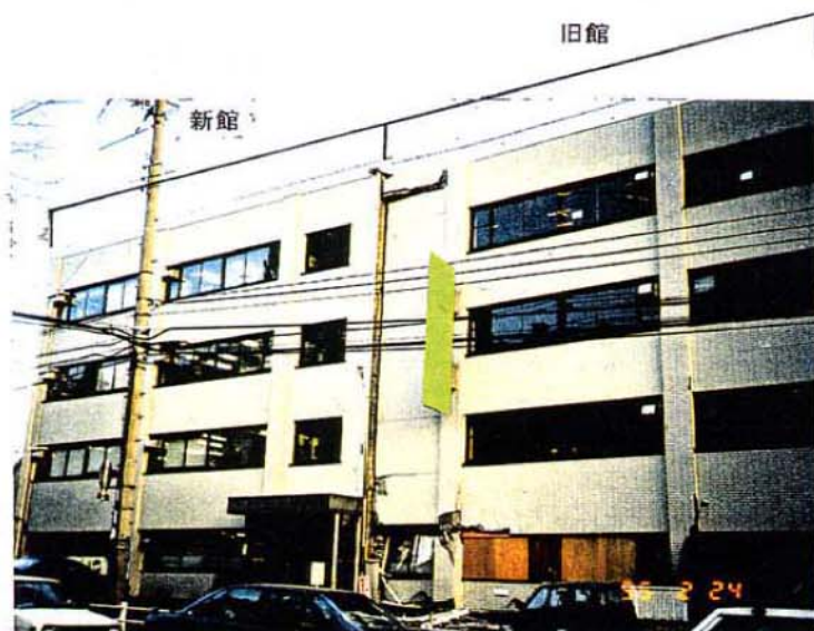
写真4.1.1 4階建て鉄筋コンクリート造事務所ビル (神戸市灘区)
