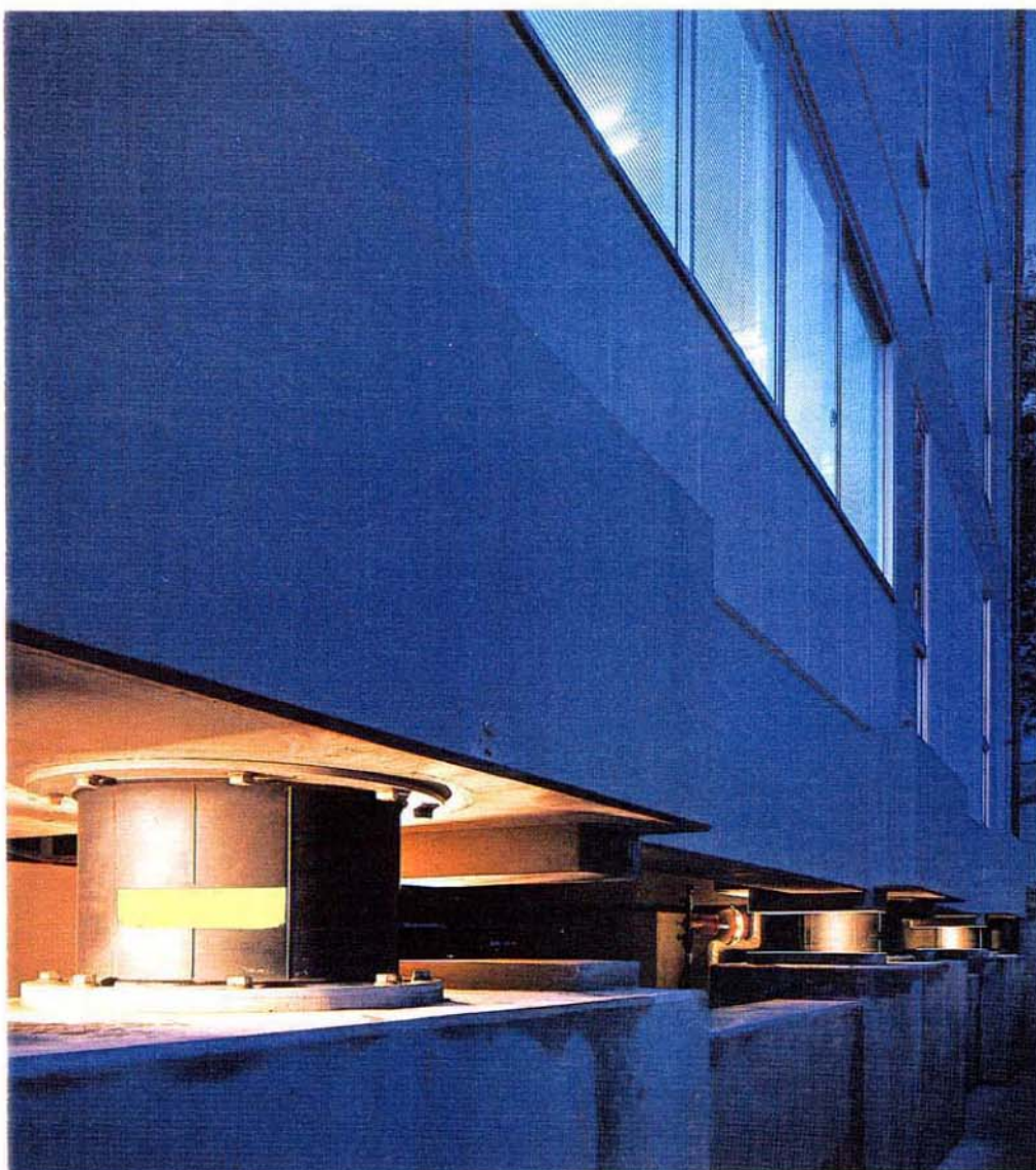
写真4.4.7 相模原機材センター
