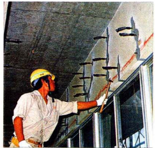
写真4.3.2 エポキシ樹脂注入1)
