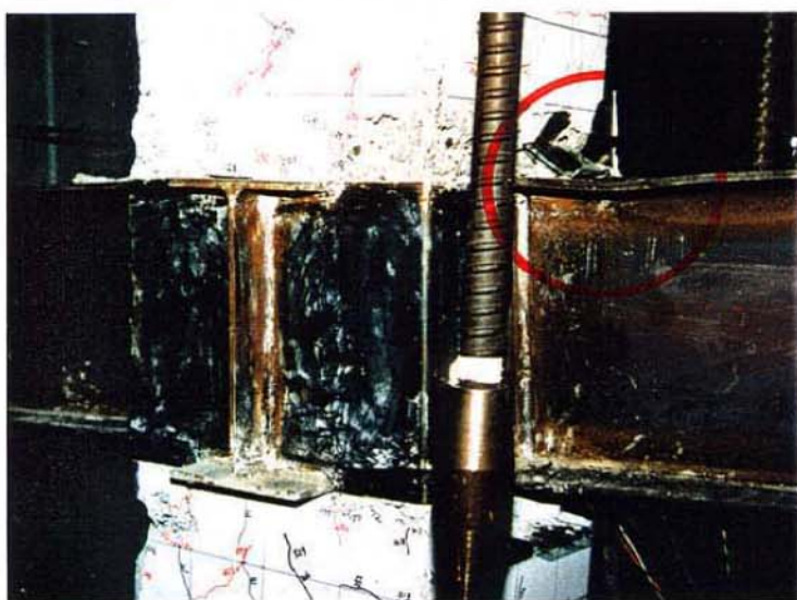
写真4.4.5 接合部状況（本構法） フランジが局部座屈しても、接合部に損傷は見られない。
