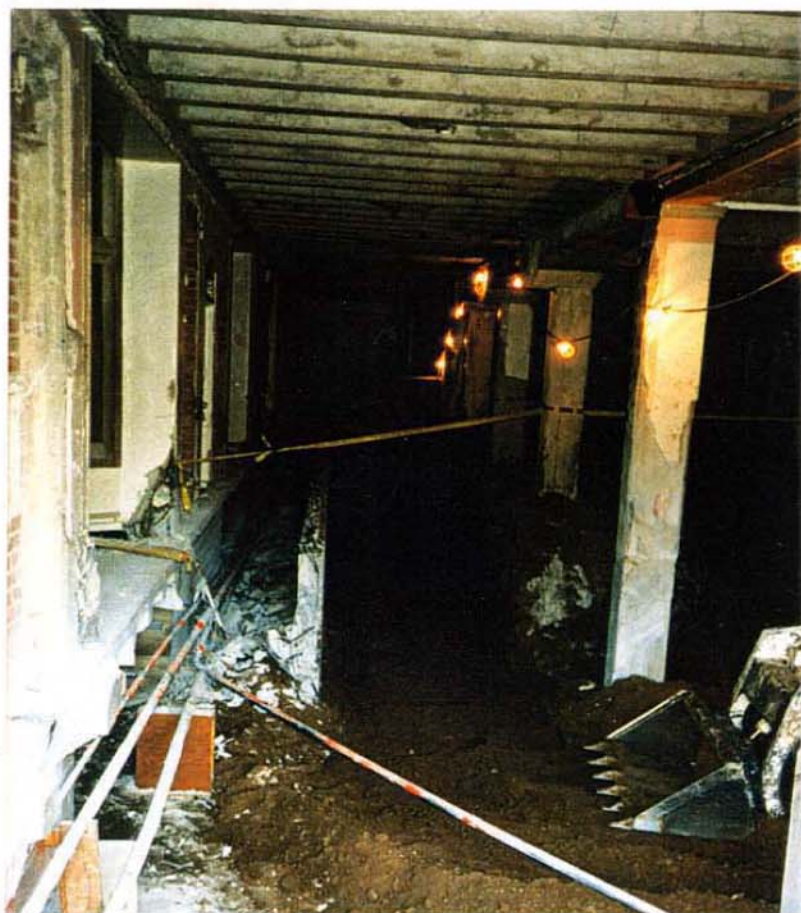
写真4.4.8 米国カリフォルニア大学ロサンゼルス校の工事 (耐震構法から免震構法に移行している。)
