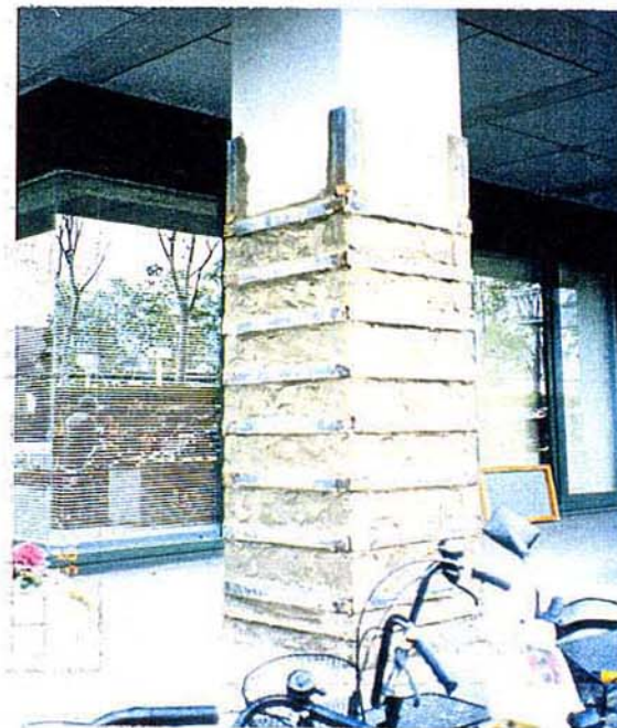
写真4.3.4 帯鋼板による補強の実例
