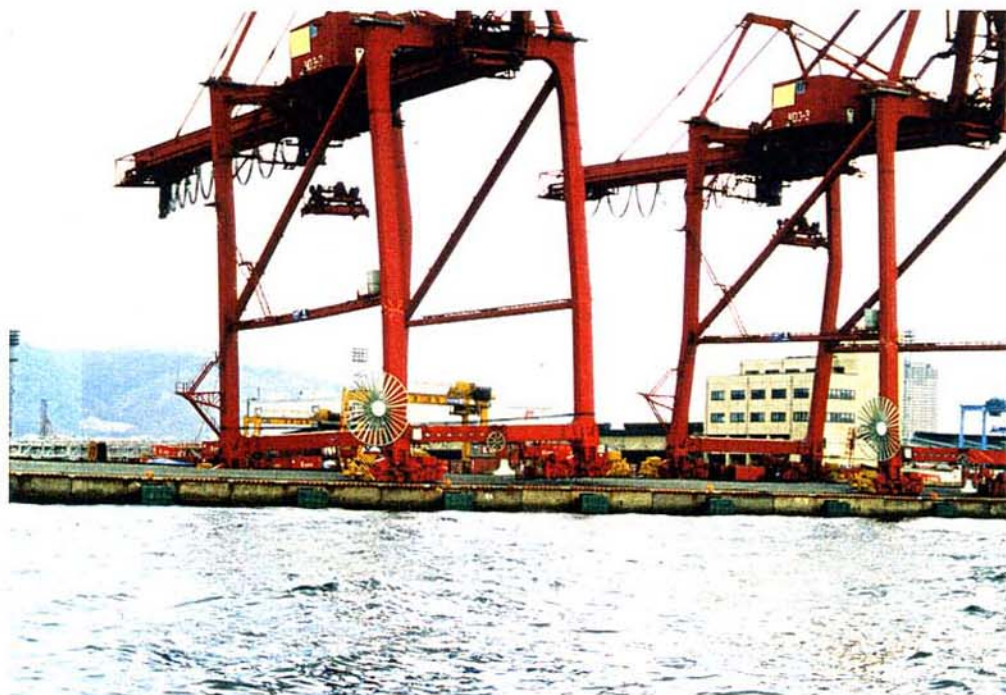
写真 3.4.1 倒壊寸前のガントリークレーン（六甲アイランド）
