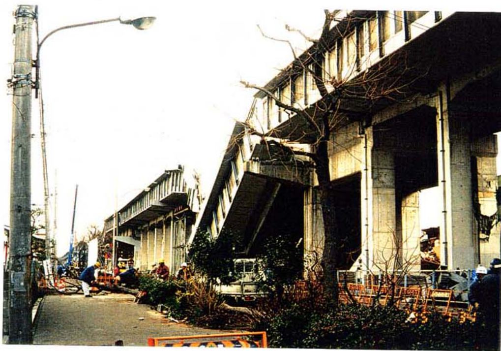
写真 3.3.13 山陽新幹線 RC ラーメン橋台の崩壊 により単純PC 桁落下
