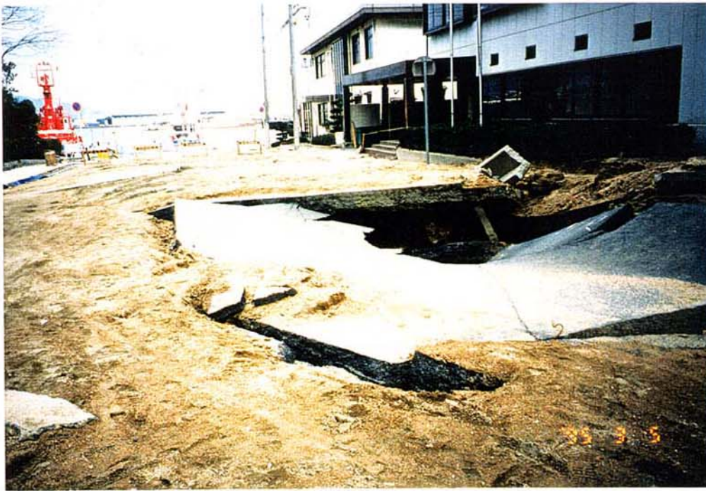
写真 3.4.16 液状化による噴砂で 覆われている
