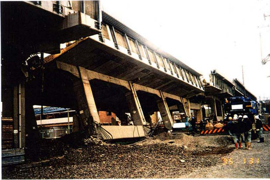
写真 3.3.7 山陽新幹線 2層ラーメン高架橋 倒壊状況 (橋脚中間梁以下にて破壊)
