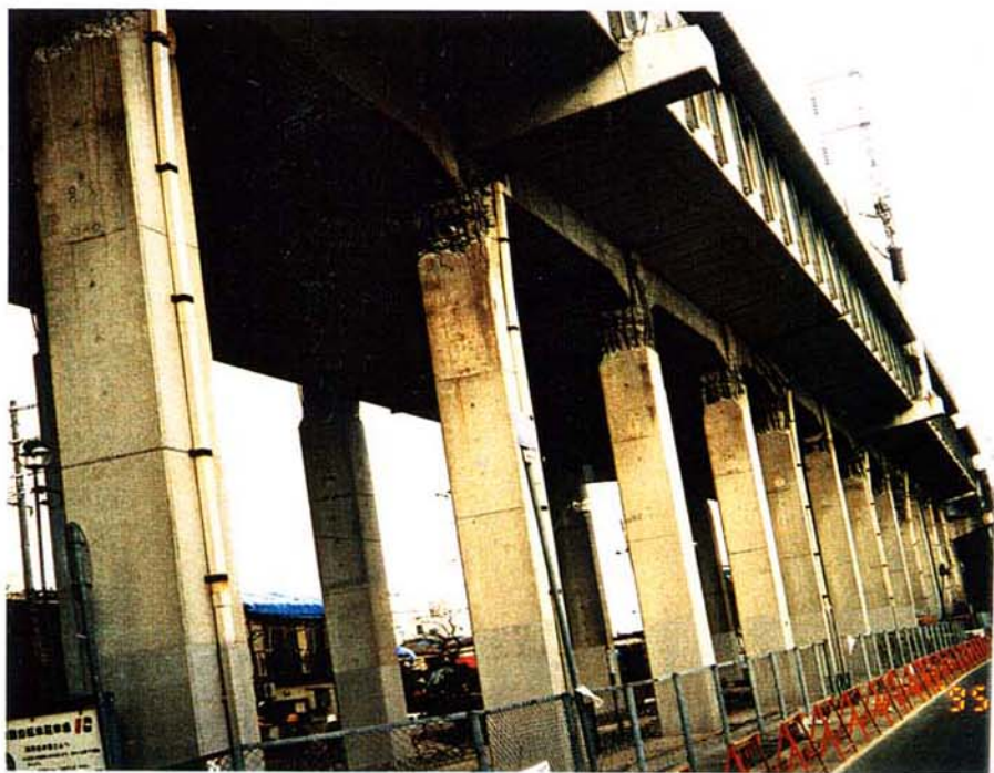
写真 3.3.3 山陽新幹線 ラーメン高架橋 ハンチ下コンクリート打継部
