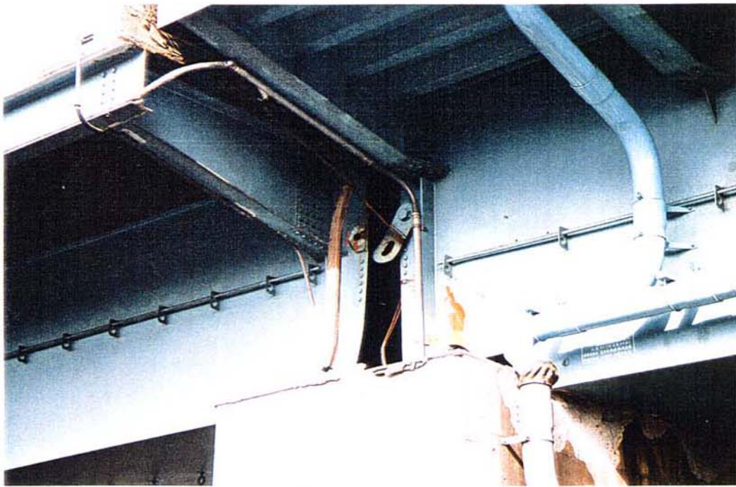
写真3.2.7 落橋防止装置のピン破断
