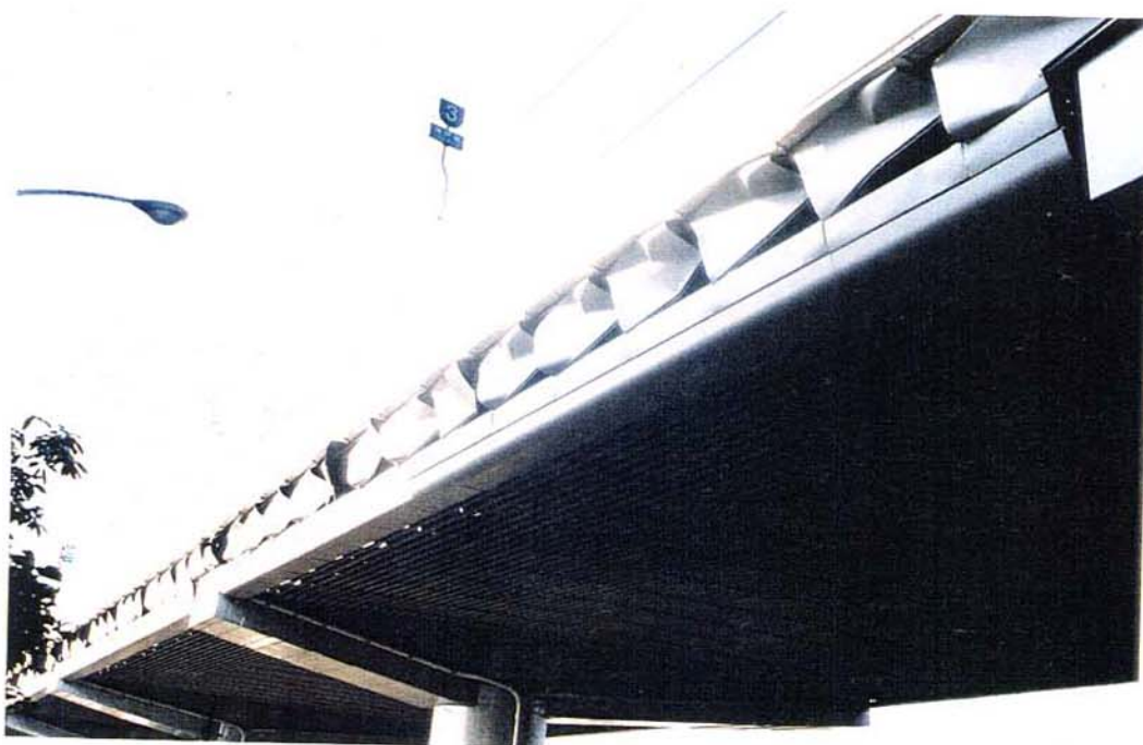
写真3. 2. 12 化粧板の変形
