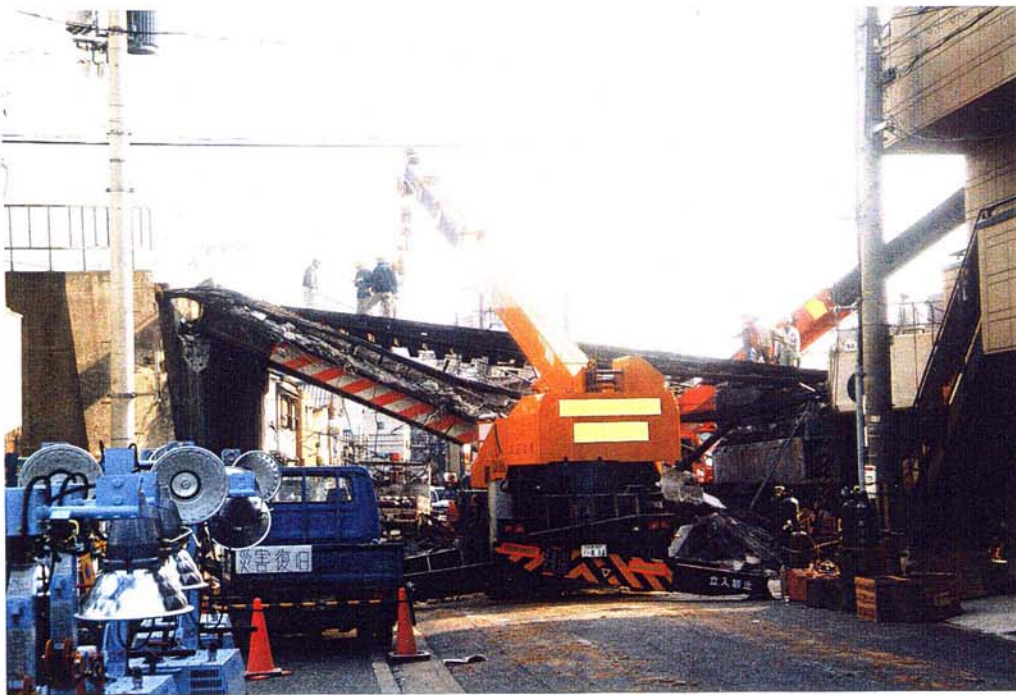
写真 3.3.25 阪神電鉄 落下橋梁撤去中
