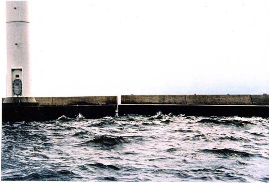
写真 3.4.3 防波堤移動
